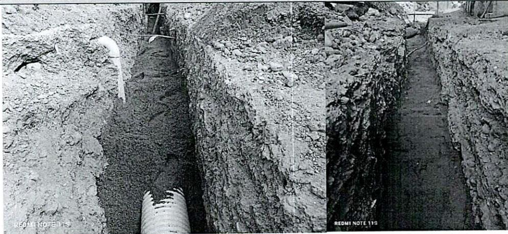
SUMINISTRO, TRANSPORTE E INSTALACION DE TUBERIA PVC CORRUGADA  $\Phi=160$  MM (6") PARA ALCANTARILLADO
