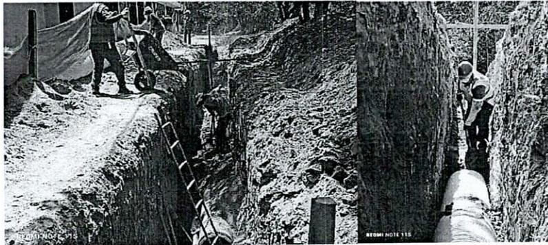
**SUMINISTRO, TRANSPORTE E INSTALACION DE TUBERIA PVC CORRUGADA  $\Phi=20''$  PARA ALCANTARILLADO, INCLUYE MANEJO DE AGUAS**
