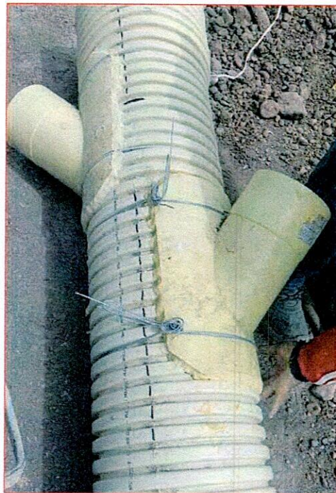
Instalación de silletas
