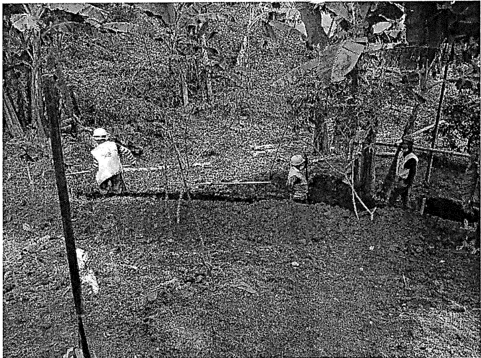
Imagen. Excavación manual para instalación de tubería.
