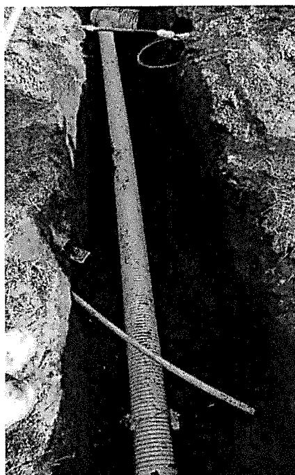
Imagen. Instalación de tubería PVC corrugada de 6" para domiciliarias
