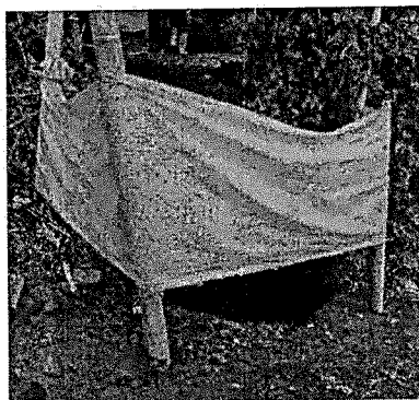
Imagen. Cerramiento con tela verde y soportes de guadua cada 2 metros.
