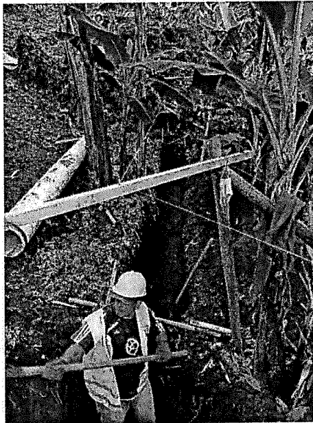
Imagen. Excavación manual para instalación de tubería.
