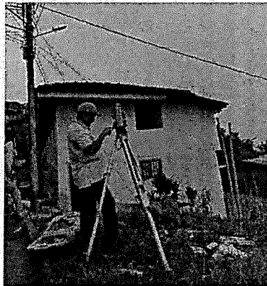
Imagen 1. Localización y replanteo mediante equipos topográficos
