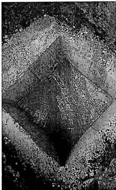
Imagen. Cajas de inspección 0,50x0,50 para domiciliarias
