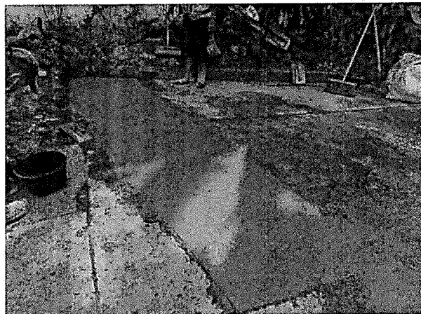
Imagen. Transporte, suministro e instalación de concreto de 21Mpa para pavimento.
