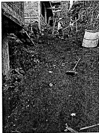
Imagen. Llenos compactados con material del sitio
