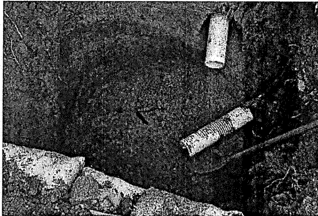
Imagen. Instalación de tubería PVC corrugada de 6" para domiciliarias
