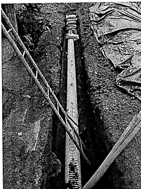
Imagen. Instalación de tubería PVC corrugada de 12"
