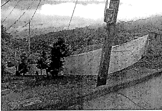
Imagen. Cerramiento con tela verde y soportes de guadua cada 2 metros.
