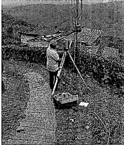
Imagen 1. Localización y replanteo mediante equipos topográficos
