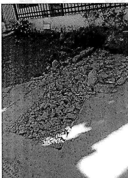
Imagen. Demolición de pavimento rígido
