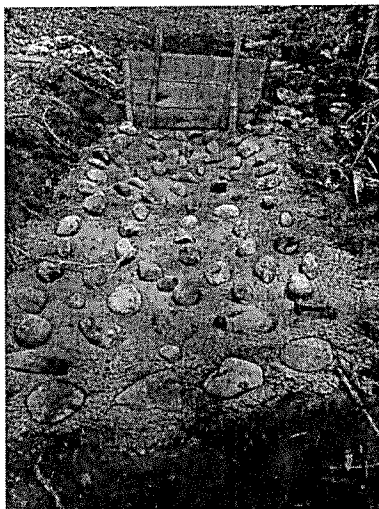
Imagen. Suministro e instalación de concreto ciclope para colchón dissipador
