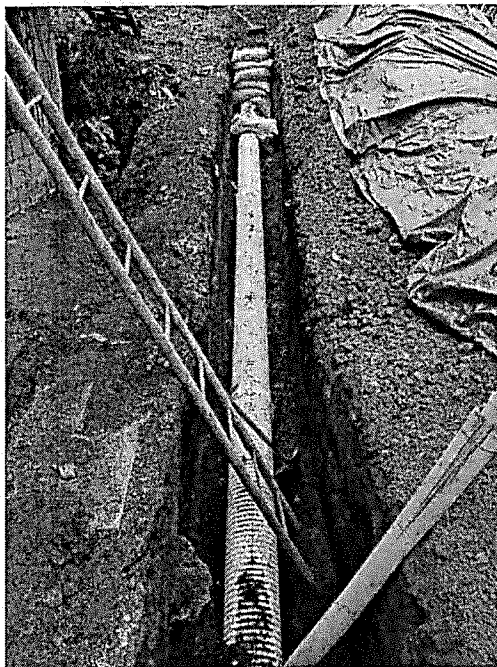
Imagen. Instalación de tubería PVC corrugada de 12"
