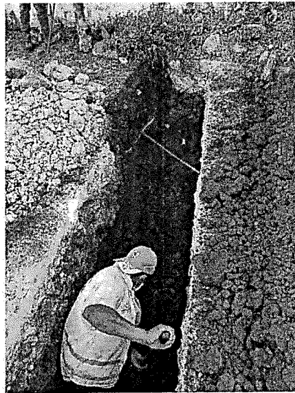
Imagen. Excavación manual
