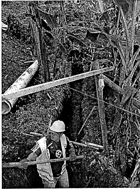
Imagen. Excavación manual para instalación de tubería.
