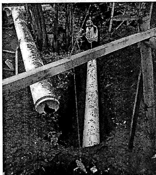
Imagen. Instalación de tubería PVC corrugada de 12".
