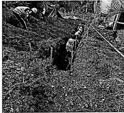
Imagen. Excavación manual para instalación de tubería.
