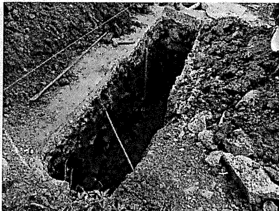
Imagen. Excavación manual para instalación de tubería de 12".
