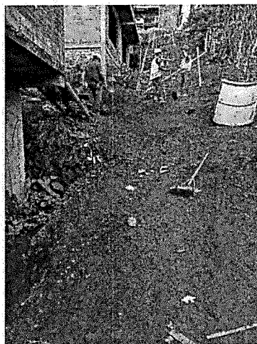
Imagen. Llenos compactados con material del sitio
