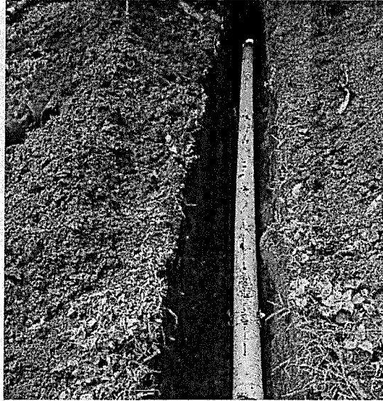
Imagen. Instalación de tubería PVC corrugada de 12"
