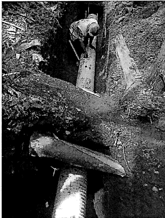
Imagen. Instalación de tubería PVC corrugada de 12"
