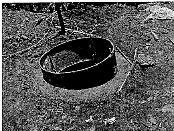
Imagen. Construcción de cámaras de inspección.
