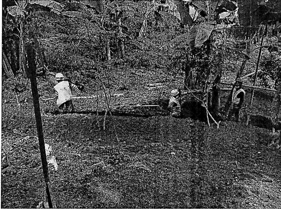
Imagen. Excavación manual para instalación de tubería.
