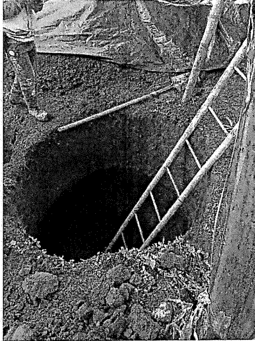
Imagen. Excavación manual para conformación de cámaras de inspección.
