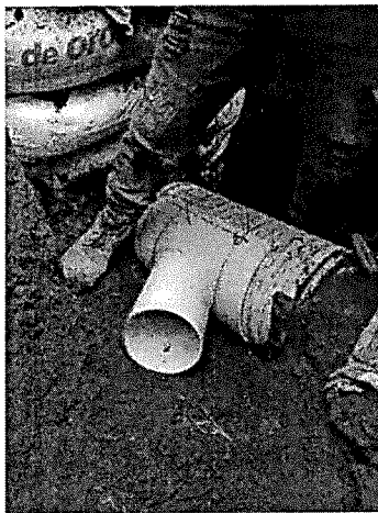
Imagen. Instalación de silletas de 12"x6"
