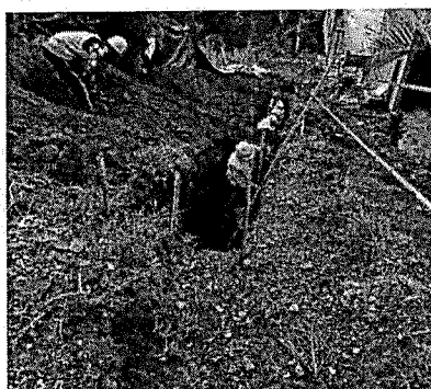
Imagen. Excavación manual para instalación de tubería.
