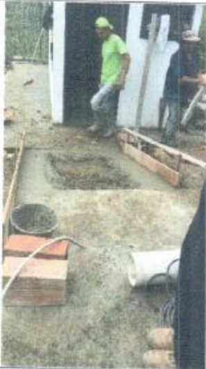
Formaleta instalada e inicio de fundida de rampa
