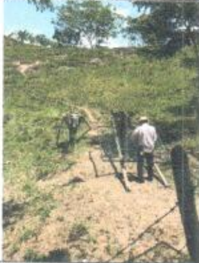
Subida de módulos de cerramiento
