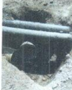
Excavación inicial de caja de inspección
