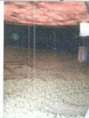
Lleno de filtros con material filtrante
