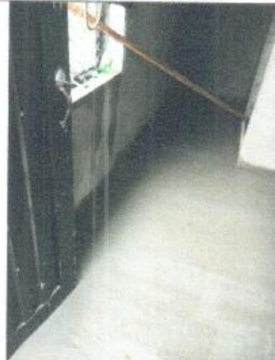
Nivelación de piso Interior de caseta
