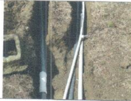
Relocalización inicial de tuberías
