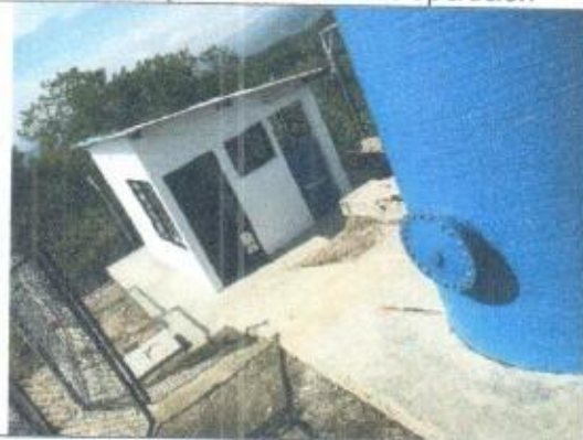
Vista de caseta finalizada
