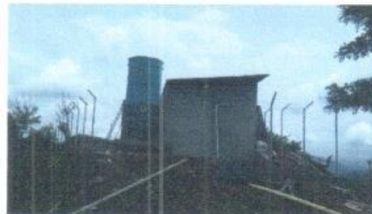
Caseta y PTAP
