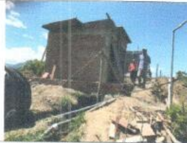
Trabajos de excavación y techo
