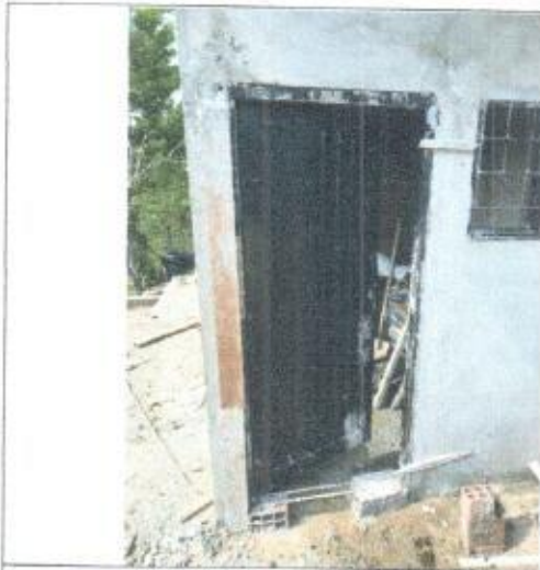
Puerta de caseta
