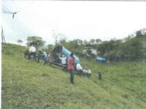
Subida de tanques a obra
