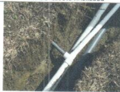
Relocalización inicial de tuberías
