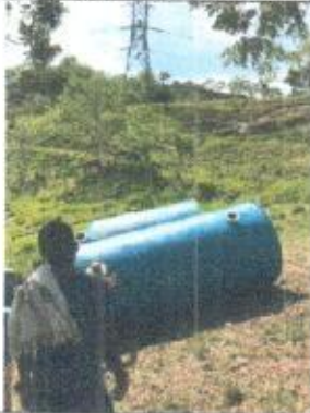
Tanques descargados para ser subidos
