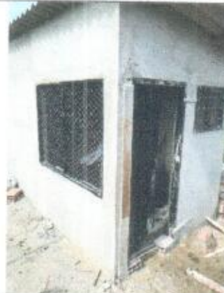
Instalación de puerta y ventanas
