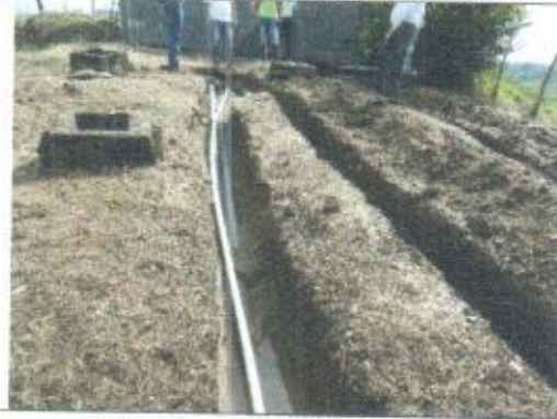
Relocalización inicial de tuberías
