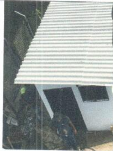
Vista superior de caseta de operación
