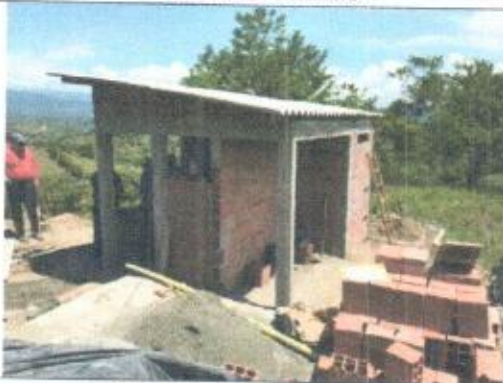
Vista de caseta techada
