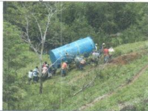
Subida de tanques a obra
