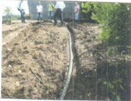
Relocalización inicial de tuberías
