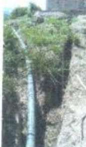
Excavación de tuberías
