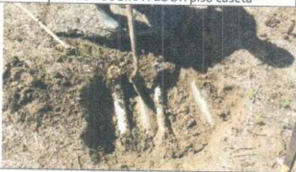
Relocalización inicial de tuberías
