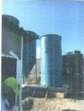
Vista de tanques ubicados
