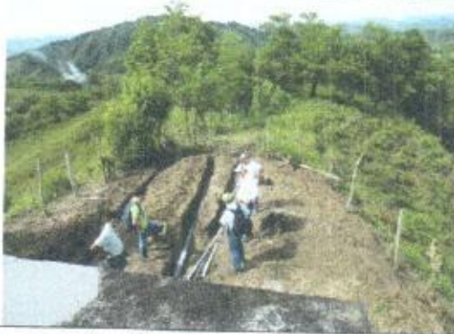
Relocalización inicial de tuberías
