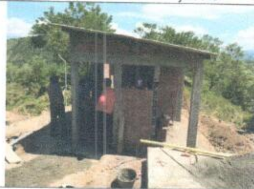
Vista de caseta techada
