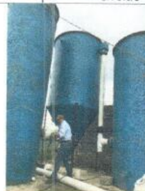
Inicio de conexiones entre tanques
