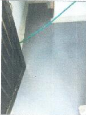
Aplicación de SIKA FLOOR piso caseta
