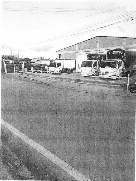
Foto: hundimiento de calzada y señalización
