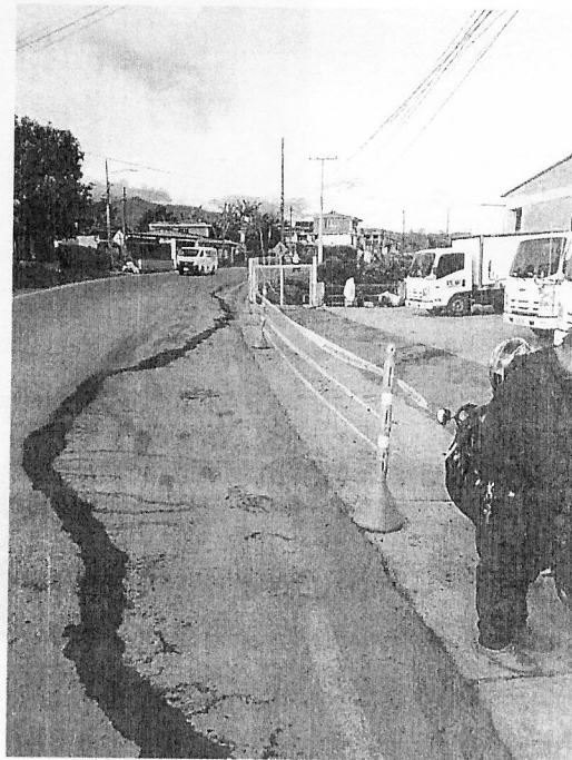
Foto: costado lateral de bodega – Se evidencia fuga de tubería de acueducto
