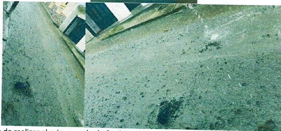
Luego de realizar el primer acabado final acorde a lo exigido por la supervisión del proyecto y conforme a la fricción requerida para el paso vehicular, se presentó un evento de precipitación alto el cual perjudicó las labores realizadas, por consiguiente, se repitió la labor.
