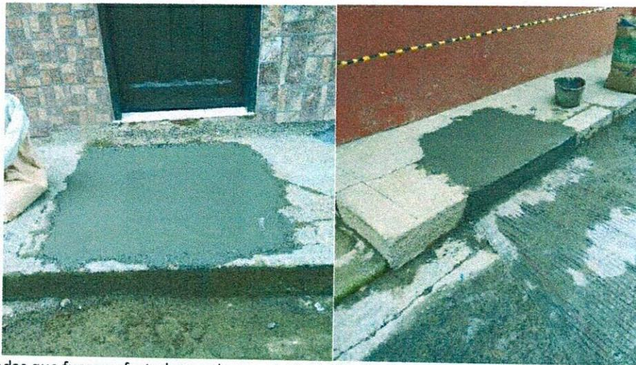
Las viviendas que fueron afectadas por la reposición de la tubería mientras se ejecutaron las actividades del proyecto, se les repuso el andén en granito, acorde con la disposición del material actual y constatando de que el dueño de la vivienda estuviera de acuerdo.
