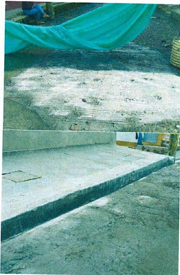
Se realizó la cuneta rectangular solicitada a la proximidad de la calle 12, permitiendo un adecuado desagüe y evitando las infiltraciones a zonas inferiores.
