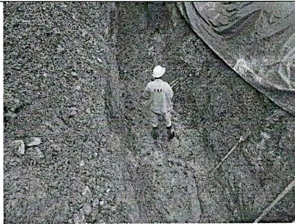
Excavaciones para instalación tubería
