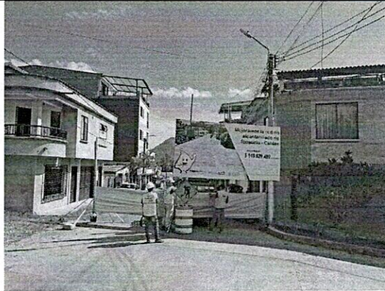
Instalación Valla, Cerramiento y Señalización
