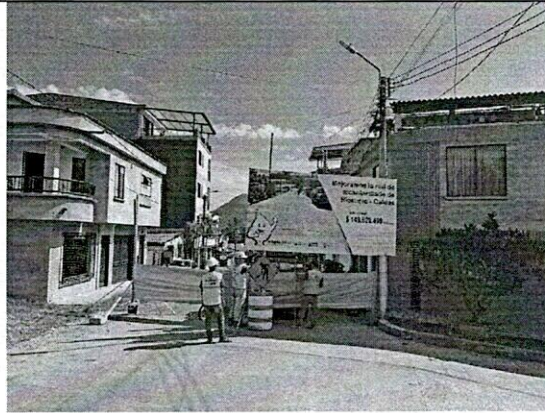
Instalación Valla, Cerramiento y Señalización
