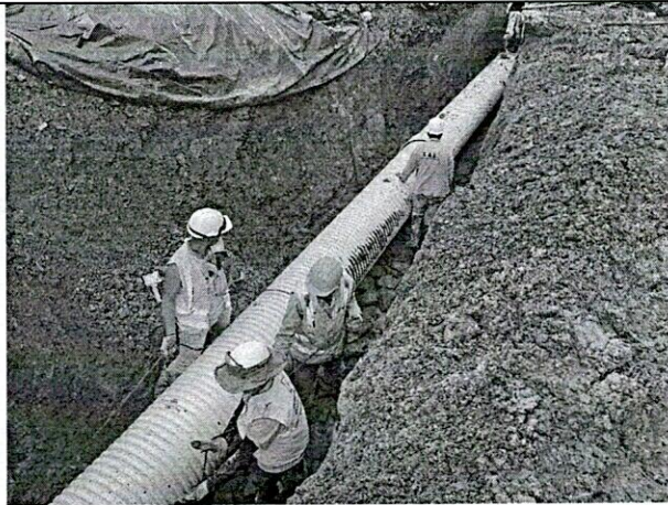
Instalación tubería
