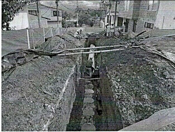
Instalación De tubería
