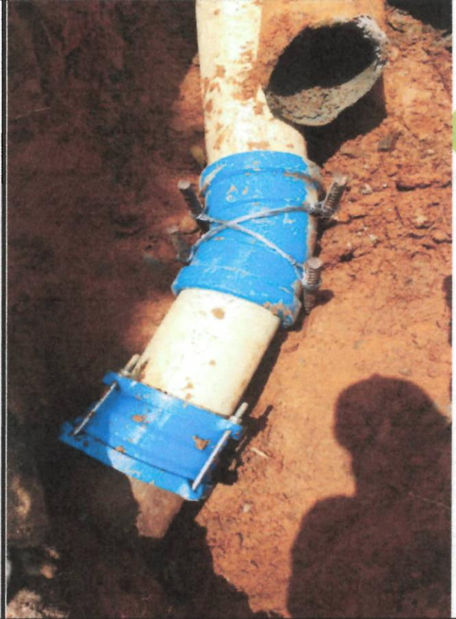
Descripción: Instalación de tubería PVC de 6"
