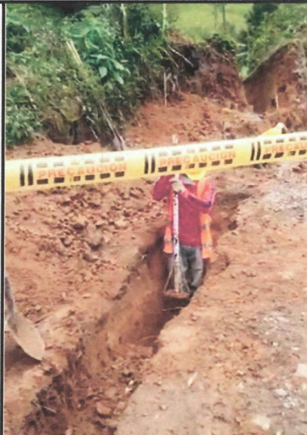
**Descripción:** Excavación En material común de 0 a 2m.
