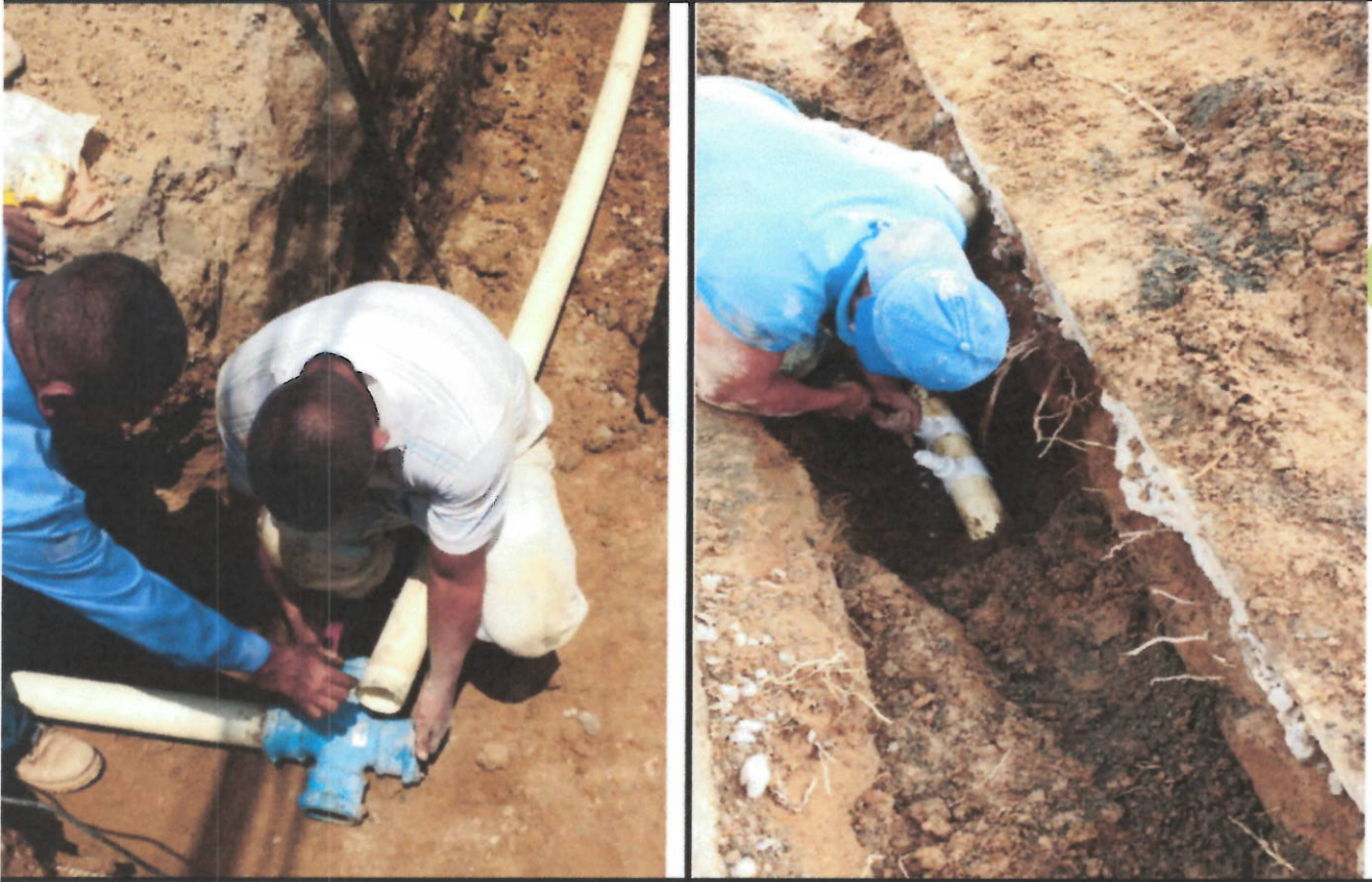
Descripción: Instalación de tubería PVC 3"
