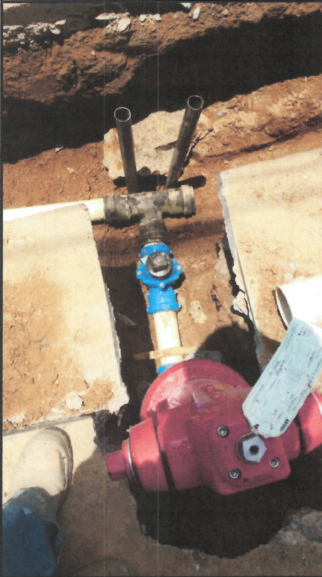
Descripción: Instalación de Válvulas e Instalación de hidrante
