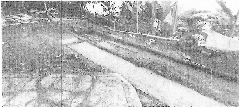
Construccion placas huellas para estacionamiento.
