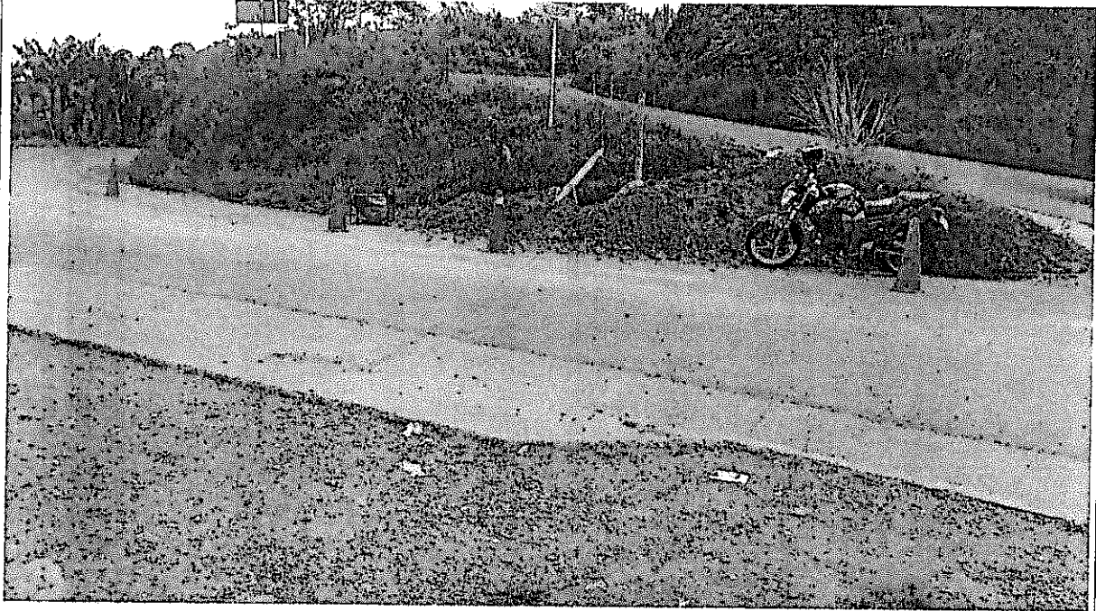
Reparación por daño presentado en el sector de la Yee que genero pactación de nuevo ítem para atención
