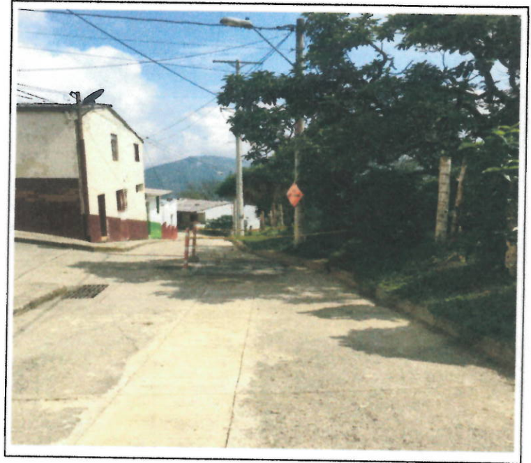
PAVIMENTO TERMINADO C2-7A Y C3-7A
