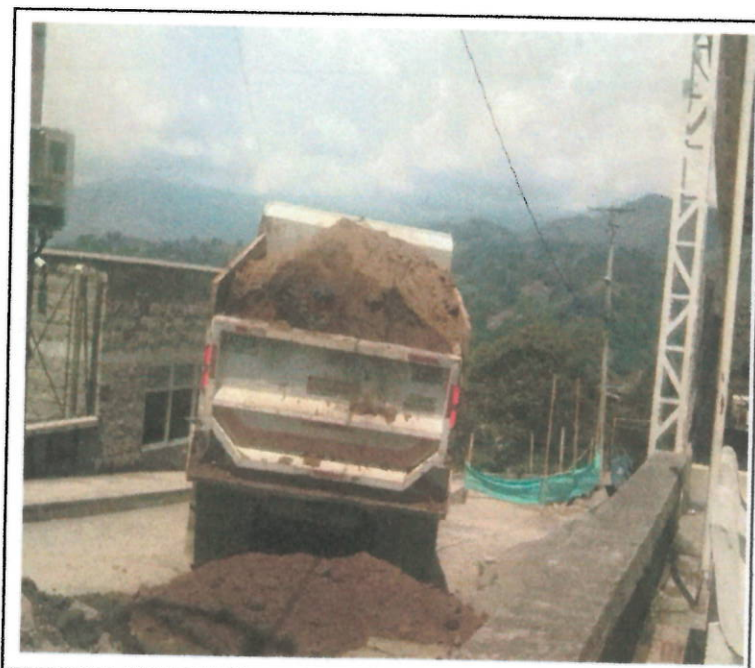
MATERIAL DE PRESTAMO PARA LLENO DE ZANJAS
