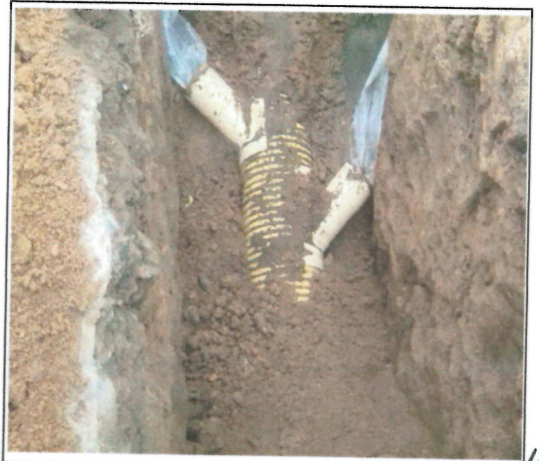
INSTALACIÓN DE SILLETAS DE 14"X6"
