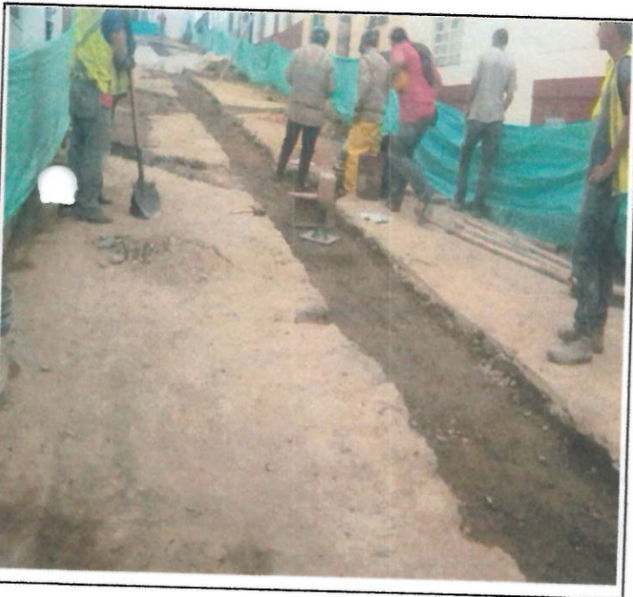
ENSAYO DENSIDAD CRA 7 ENTRE C2-7 Y C3-7
