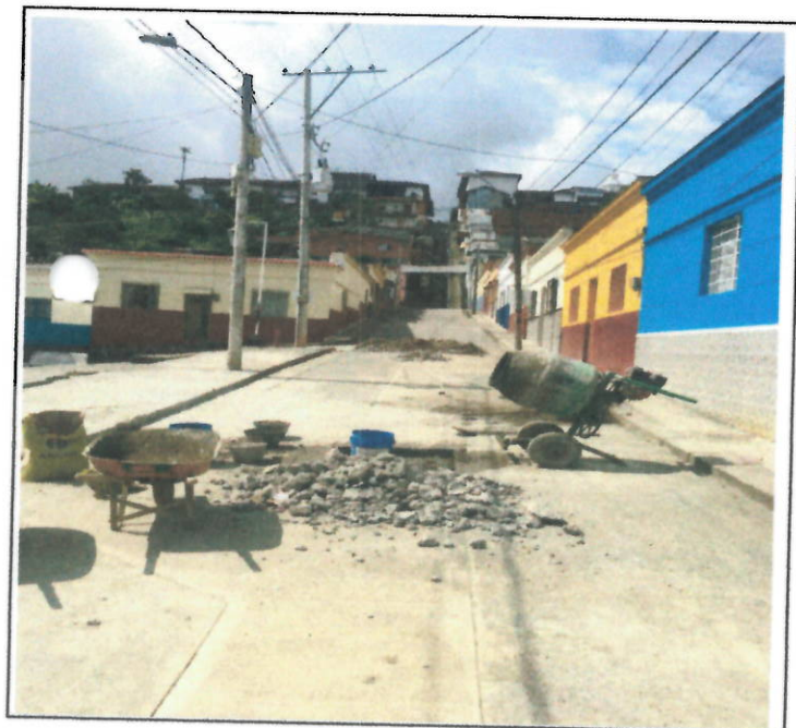
PAVIMENTO ENTRE C1-7 Y C2-7
