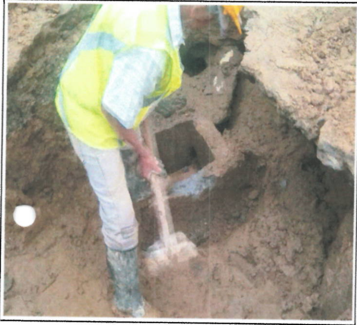
DEMOLICION CAJAS DE INSPECCIÓN EXISITENTES
