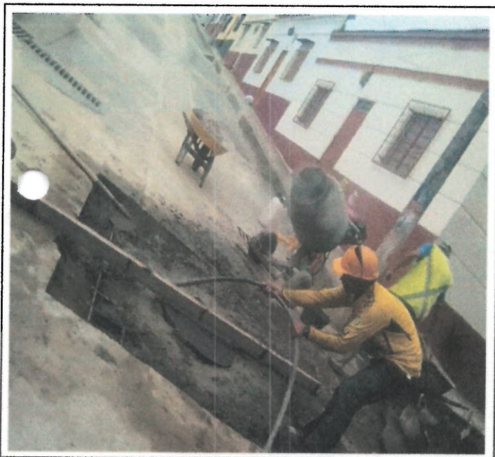
VACIADO LOSA 3C7-E
