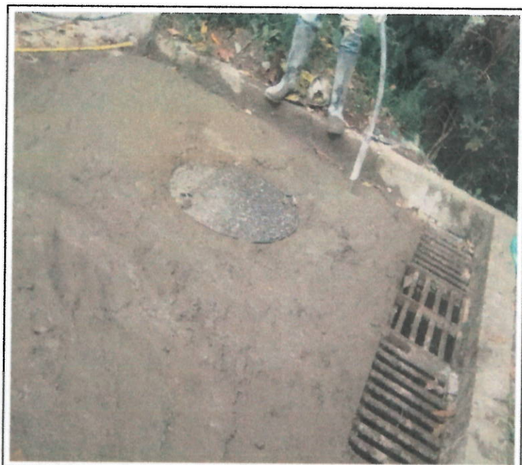
VACIADO LOSA 5C7-E
