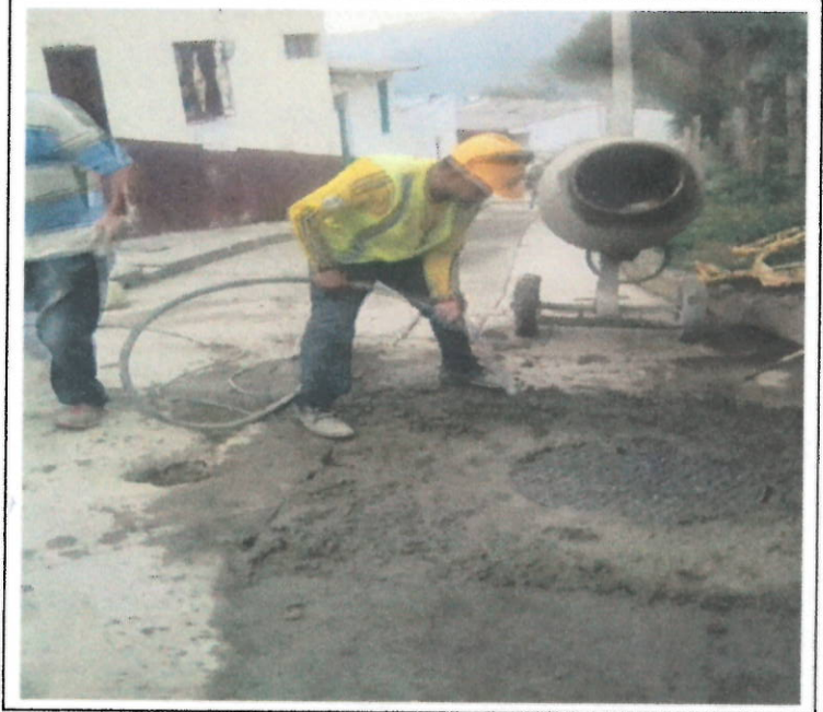
VACIADO LOSA 3C7A-E
