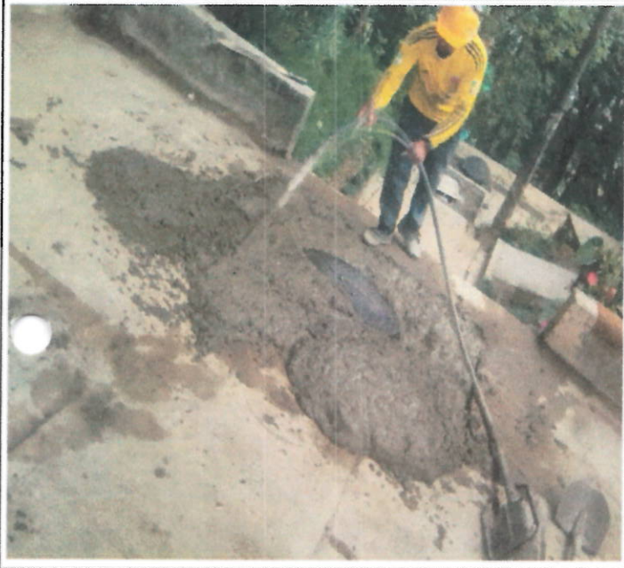
VACIADO LOSA 4C7-N
