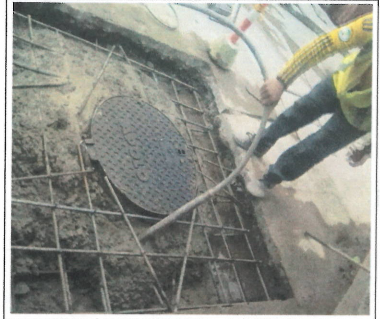
REFUERZO LOSAS CÁMARAS DE INSPECCIÓN
