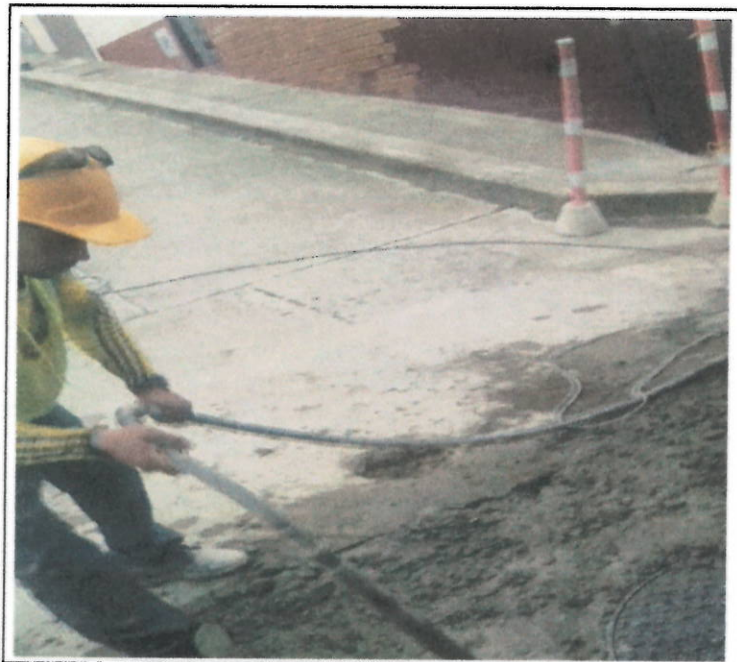
VIBRADO CONCRETO LOSAS CÁMARAS DE INSPECCIÓN
