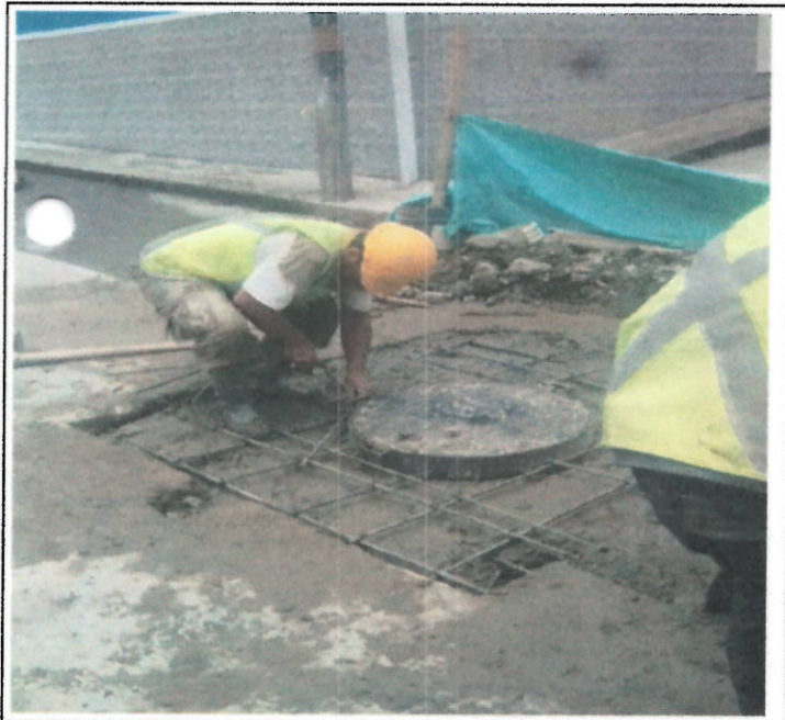
REFUERZO Y TAPA HD CÁMARAS DE INSPECCIÓN
