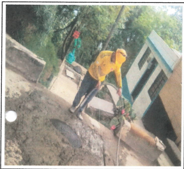
VIBRADO CONCRETO LOSAS CÁMARAS DE INSPECCIÓN
