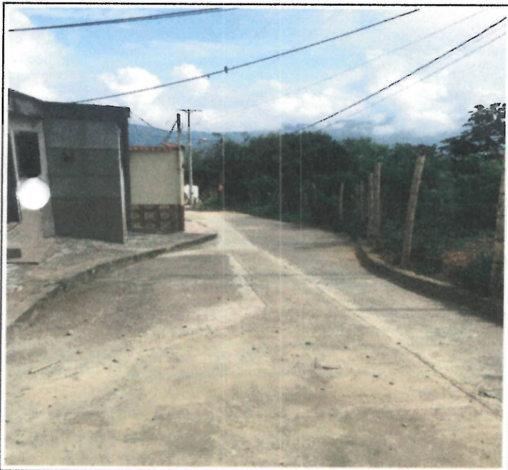
PAVIMENTO TERMINADO C2-7A Y C3-7A
