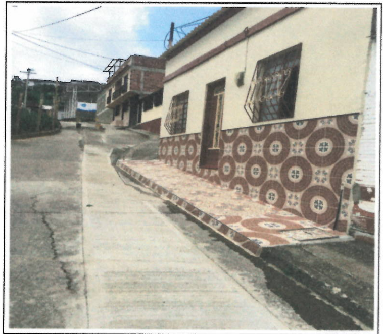
PAVIMENTO TERMINADO C2-7A Y C3-7A
