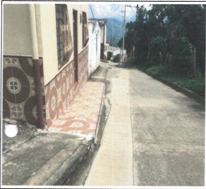
PAVIMENTO TERMINADO C2-7A Y C3-7A
