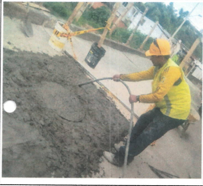
VACIADO LOSA 2C7A-E
