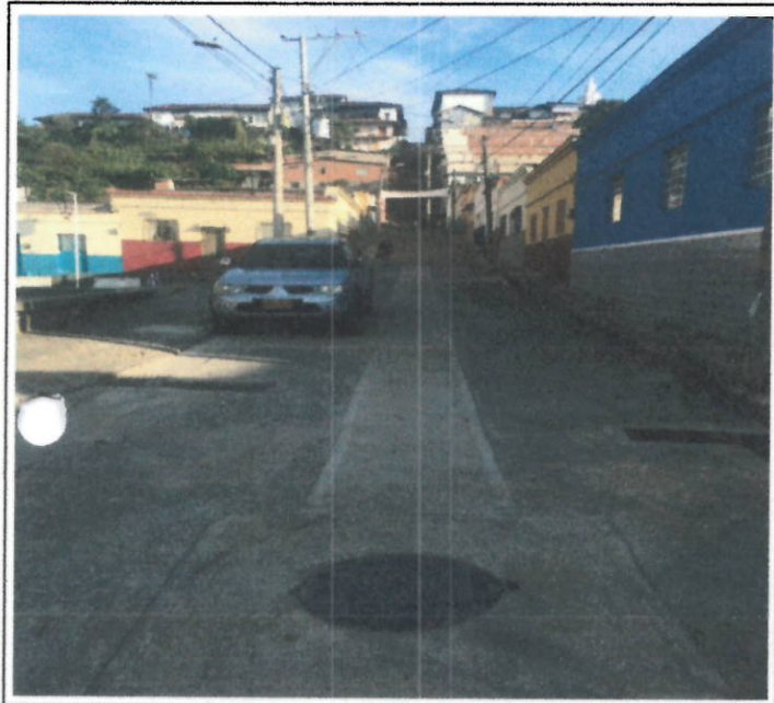
PAVIMENTO TERMINADO C1-7 Y C2-7
