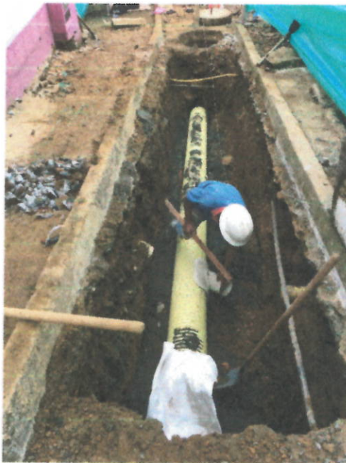
INSTALACIÓN DE TUBERIA 12"
