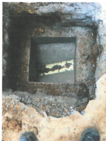
CAJAS DE INSPECCION DE 50 X 50 PARA DOMICILIARIAS
