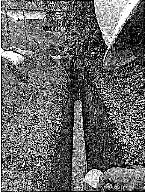
INSTALACIÓN DE TUBERIA 12"
