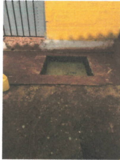
CAJAS DE INSPECCION DE 50 X 50 PARA DOMICILIARIAS
