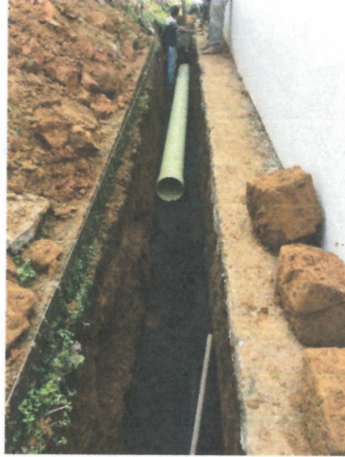
INSTALACIÓN DE TUBERIA 12"
