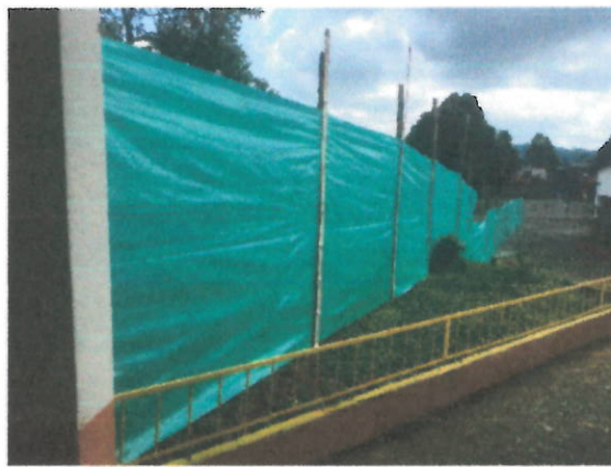
CERRAMIENTO CON TELA SECTOR LA SALLE
