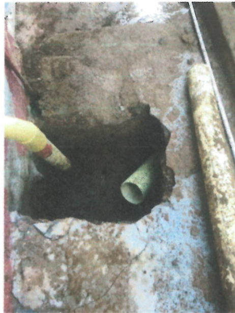
INSTALACIÓN DE TUBERIA 6"
