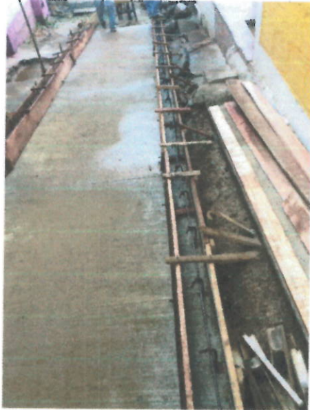
CONCRETO PARA PAVIMENTO 42 MR
