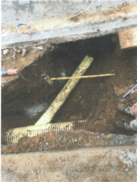
INSTALACIÓN DE TUBERIA 6"
