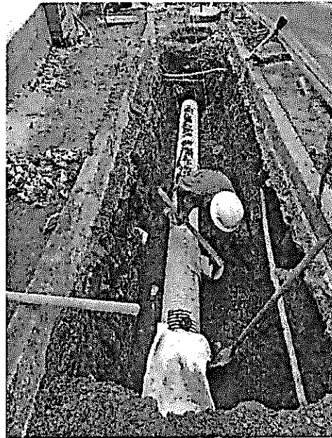
INSTALACIÓN DE TUBERIA 12"
