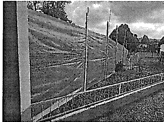
CERRAMIENTO CON TELA SECTOR LA SALLE
