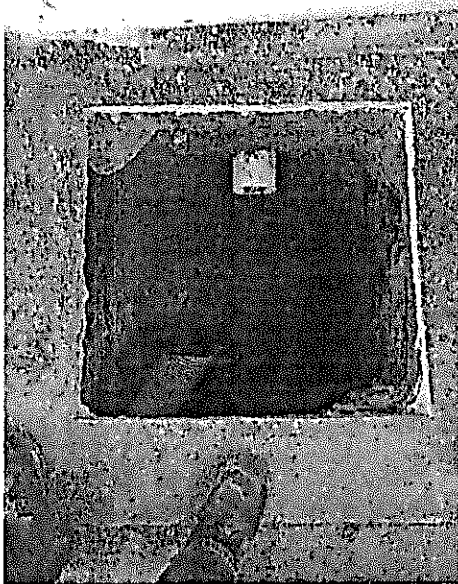
CAJAS DE INSPECCION DE 50 X 50 PARA DOMICILIARIAS
