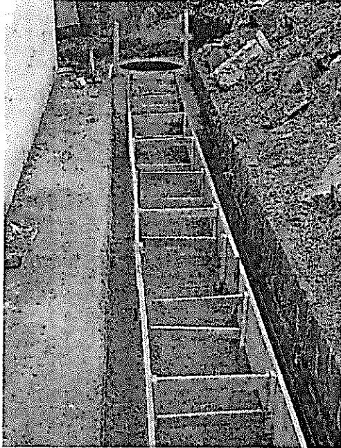
CONCRETO DE 21 Mpa PARA GRADERIAS Y ANDENES
