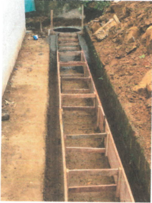
CONCRETO DE 21 Mpa PARA GRADERIAS Y ANDENES
