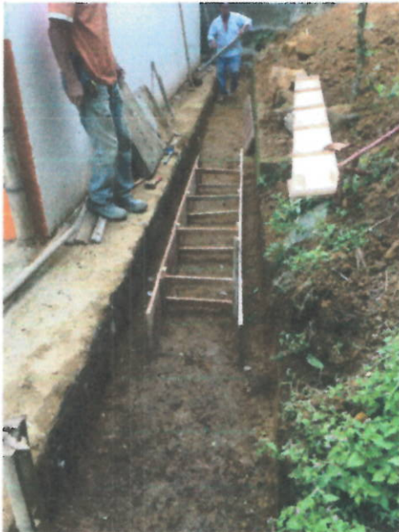
CONCRETO DE 21 Mpa PARA GRADERIAS Y ANDENES
