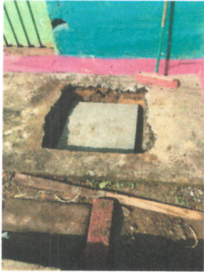
CAJAS DE INSPECCION DE 50 X 50 PARA DOMICILIARIAS
