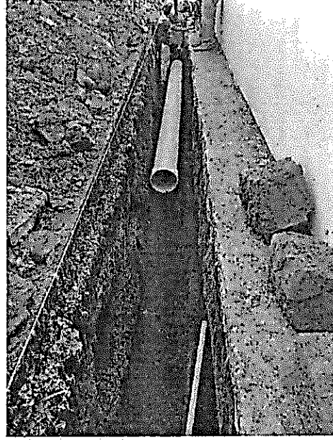
INSTALACIÓN DE TUBERIA 12"
