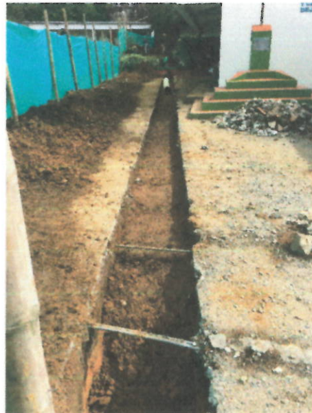
LLENO COMPACTADO CON MATERIAL DE OBRA
