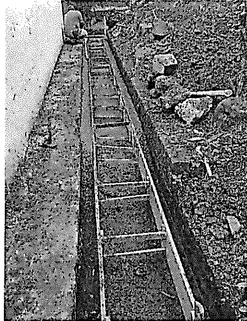
CONCRETO DE 21 Mpa PARA GRADERIAS Y ANDENES
