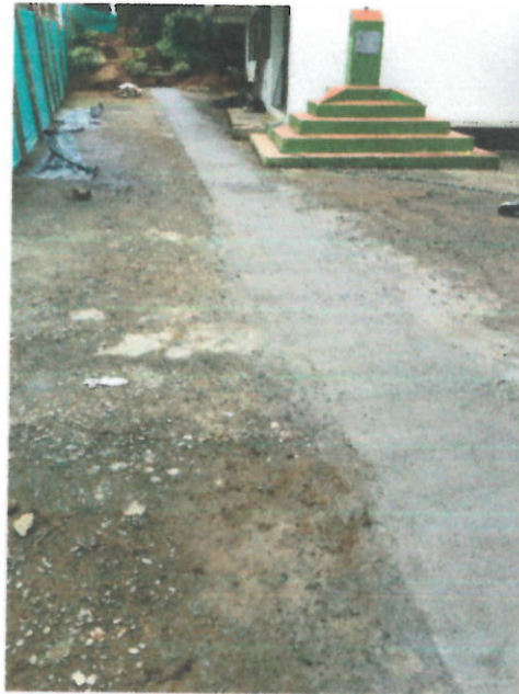
CONCRETO PARA PAVIMENTO 42 MR
