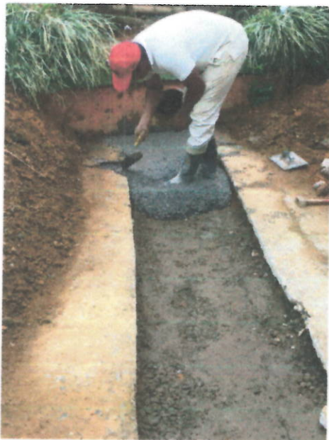
CONCRETO PARA PAVIMENTO 42 MR
