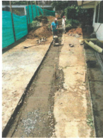
SUBBASE PARA PAVIMENTO
