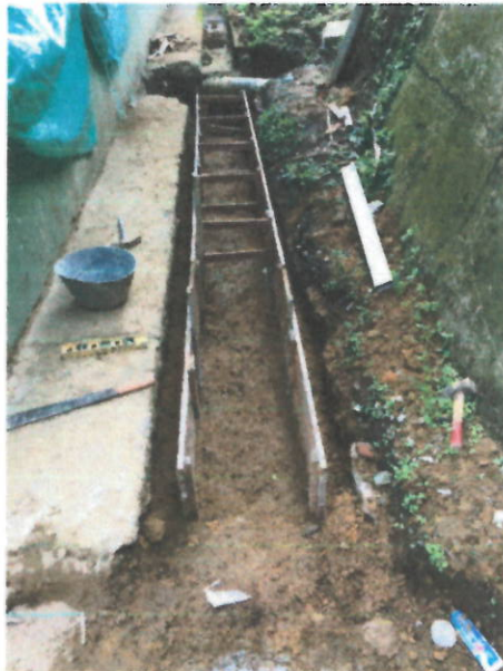
CONCRETO DE 21 Mpa PARA GRADERIAS Y ANDENES
