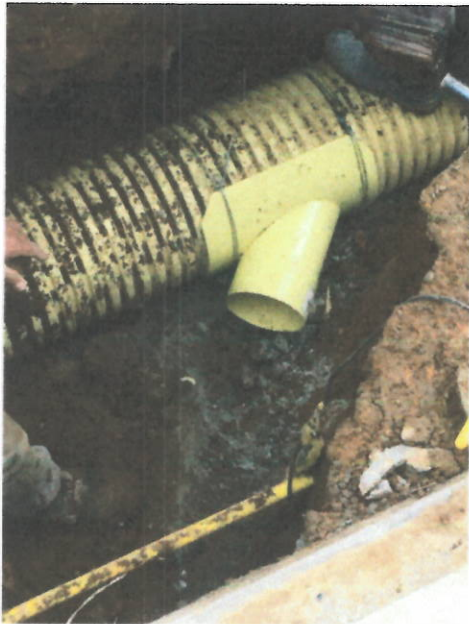
INSTALACIÓN DE SILLETAS DE 12" X 6"
