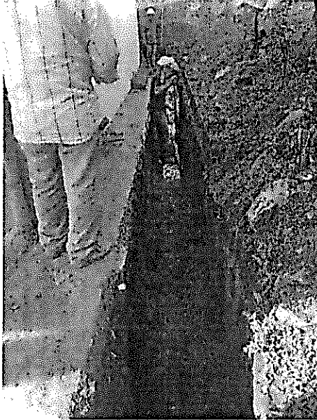
LLENO COMPACTADO CON MATERIAL DE OBRA
