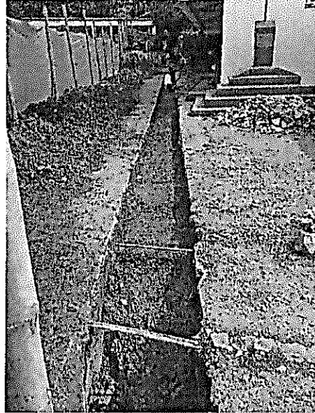
LLENO COMPACTADO CON MATERIAL DE OBRA
