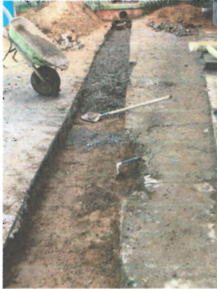
SUBBASE PARA PAVIMENTO
