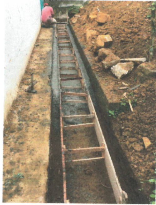
CONCRETO DE 21 Mpa PARA GRADERIAS Y ANDENES
