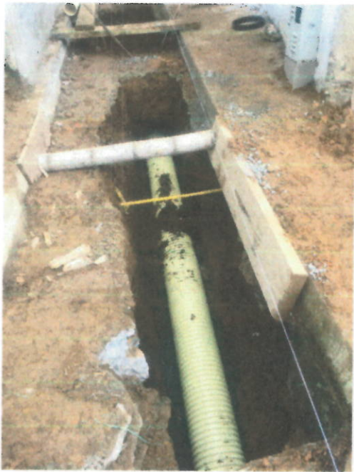
INSTALACIÓN DE TUBERIA 12"
