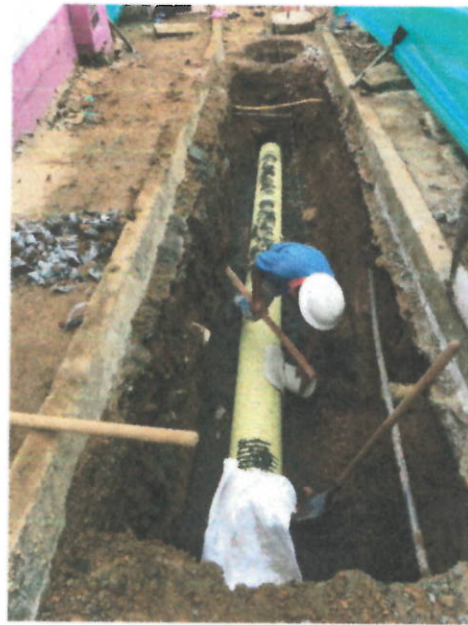
INSTALACIÓN DE SILLETAS DE 12" X 6"
