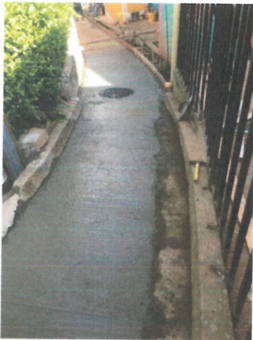
CONCRETO PARA PAVIMENTO 42 MR
