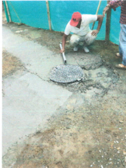
SUMINISTRO E INSTALACIÓN DE TAPA PARA POZO
