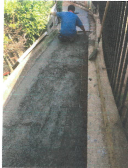
CONCRETO PARA PAVIMENTO 42 MR
