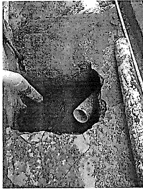
INSTALACIÓN DE TUBERIA 6"
