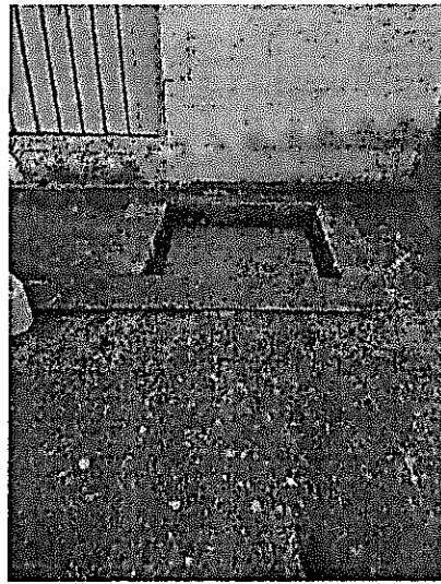
CAJAS DE INSPECCION DE 50 X 50 PARA DOMICILIARIAS
