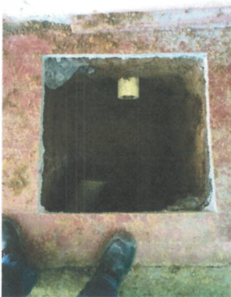
CAJAS DE INSPECCION DE 50 X 50 PARA DOMICILIARIAS
