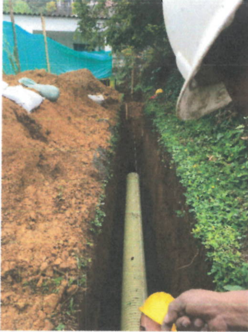
INSTALACIÓN DE TUBERIA 12"
