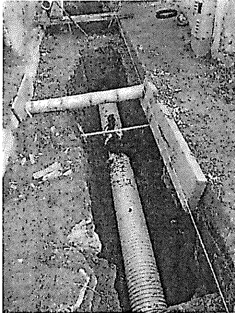
INSTALACIÓN DE TUBERIA 12"
