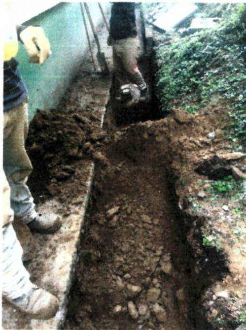
EXCAVACIONES EN MATERIAL COMUN (LA SALLE)
