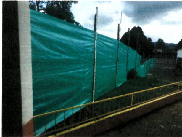
CERRAMIENTO CON TELA SECTOR LA SALLE
