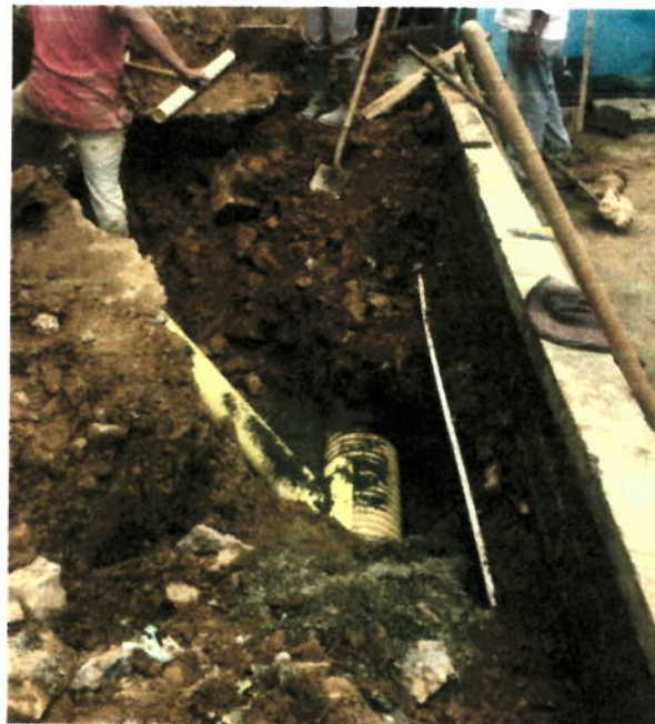
INSTALACIÓN DE SILLETAS DE 12" X 6"
