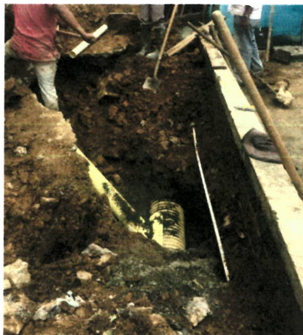
INSTALACIÓN TUBERIA PVC DE 6" PARA DOMICILIARIAS
