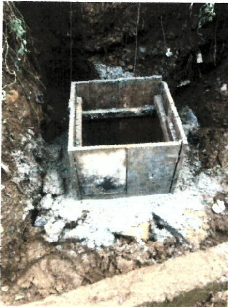
CAJAS DE INSPECCIÓN PARA DOMICILIARIAS
