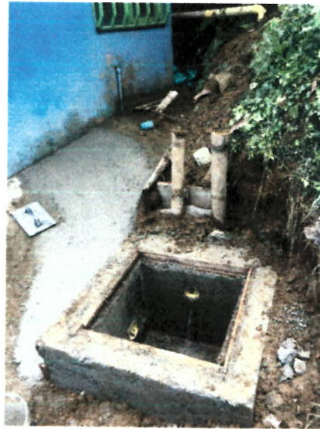
CAJAS DE INSPECCIÓN PARA DOMICILIARIAS
