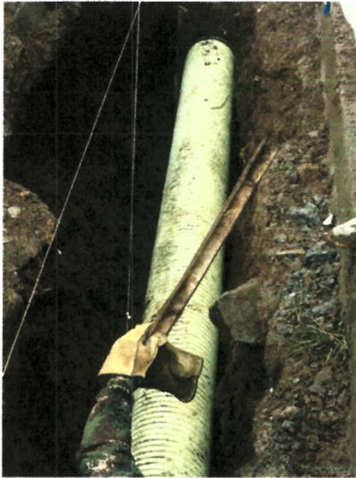
INSTALACIÓN TUBERIA CORRUGADA DE 12"
