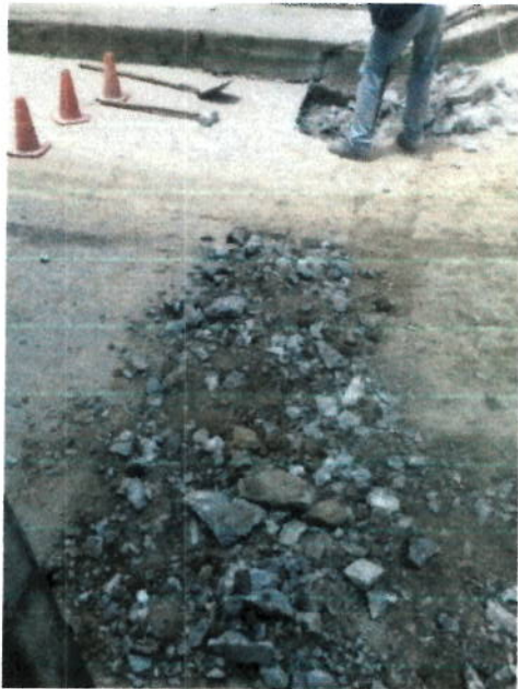
DEMOLICIÓN DE ESTRUCTURAS EN CONCRETO (FILADELFIA)
