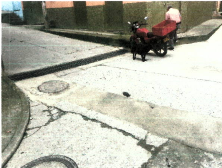
CONSTRUCCIÓN DE IMBORNALES COMPLETO EN CONCRETO
