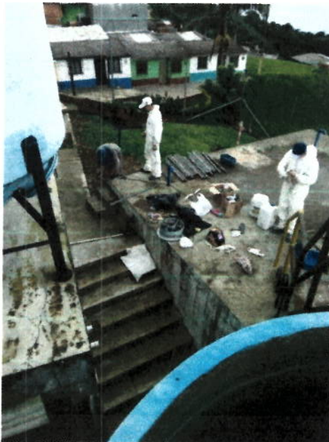
REPARACIÓN DIVISION FLOCULADOR PLANTA SAN JOSE
