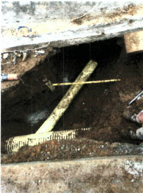
INSTALACIÓN TUBERIA PVC DE 6" PARA DOMICILIARIAS
