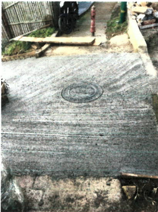
CONCRETO PARA PAVIMENTO 42 MR
