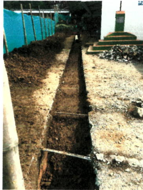
LLENO COMPACTADO CON MATERIAL DE OBRA
