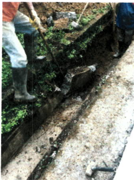
DEMOLICIÓN DE ESTRUCTURAS EN CONCRETO (GIRASOLES)
