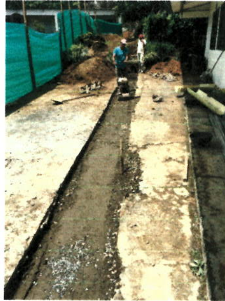
SUB BASE PARA PAVIMENTO
