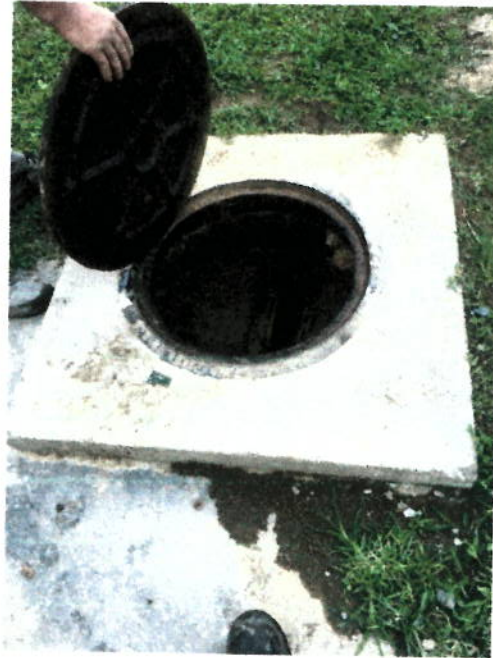
SUMINISTRO E INSTALACIÓN TAPA CON ARO PARA PÓZO
