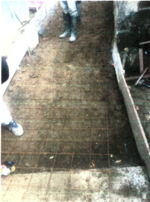
SUMINISTRO E INSTALACIÓN DE MALLA ELECTRO SOLDADA
