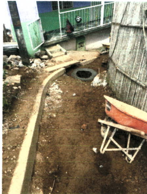
LLENO COMPACTADO CON MATERIAL DE OBRA
