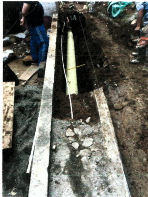
INSTALACIÓN TUBERIA CORRUGADA DE 12"
