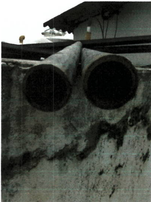
TUBERIA DE DIAMETRO 2" RECUBIERTO EN FIBRA DE VIDRIO PLANTA SAN JOSE
