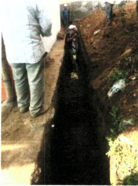
LLENO COMPACTADO CON MATERIAL DE OBRA
