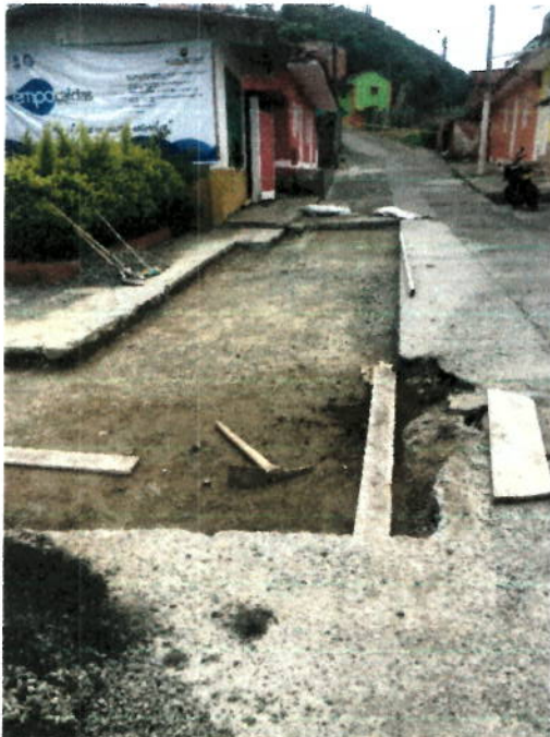
EXCAVACIONES EN MATERIAL COMUN (LA SALLE)
