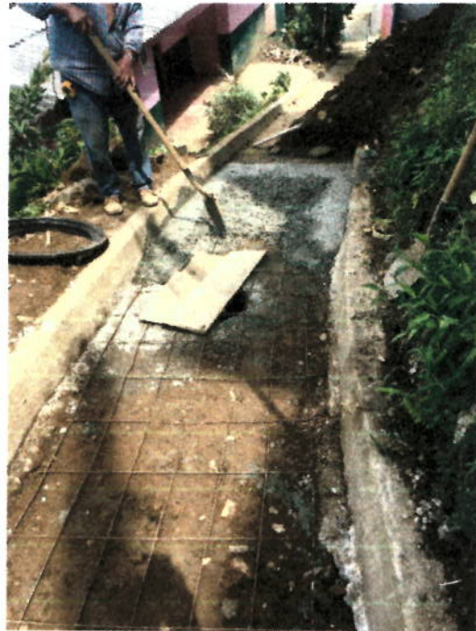
SUMINISTRO E INSTALACIÓN DE MALLA ELECTRO SOLDADA
