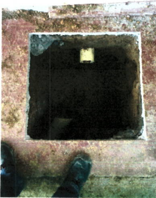
CAJAS DE INSPECCIÓN PARA DOMICILIARIAS
