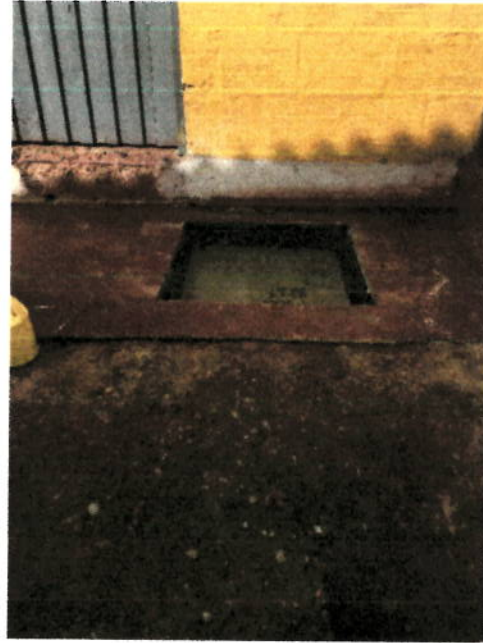
CAJAS DE INSPECCIÓN PARA DOMICILIARIAS
