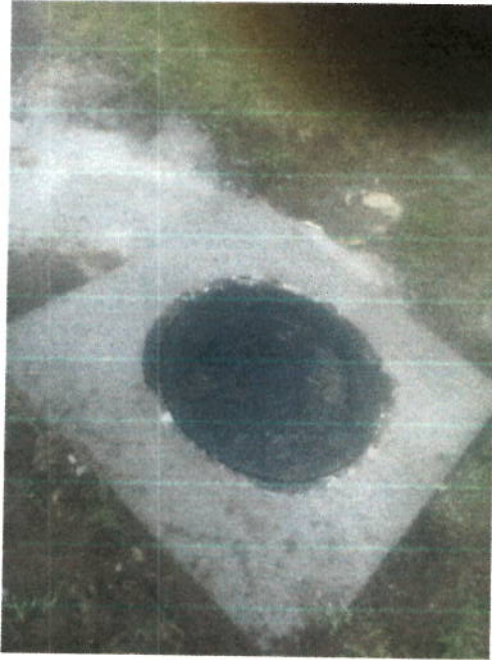
SUMINISTRO E INSTALACIÓN TAPA CON ARO PARA PÓZO
