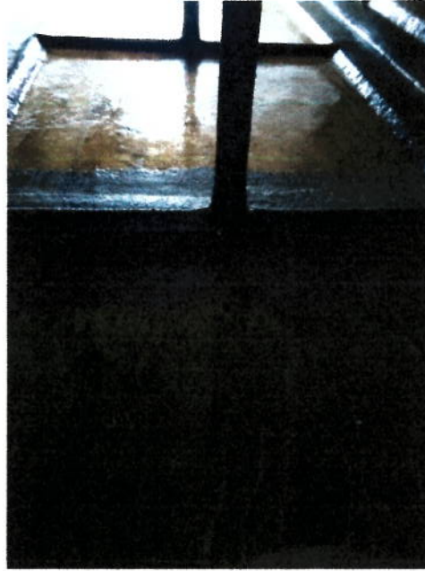
SUMINISTRO E INSTALACIÓN DE ANGULOS DE 1.1/2" X 3/16 RECUBIERTO CON FIBRA DE VIDRIO PLANTA SAN JOSE
