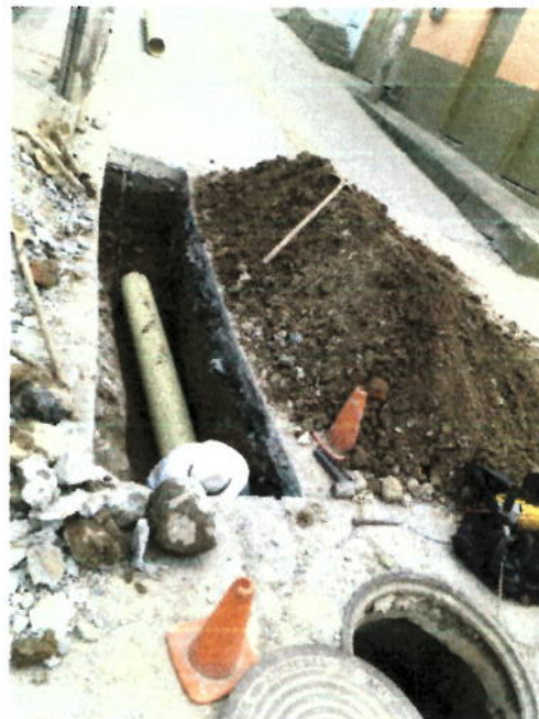
INSTALACIÓN TUBERIA CORRUGADA DE 10"
