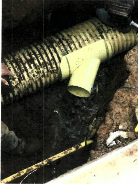
INSTALACIÓN DE SILLETAS DE 12" X 6"
