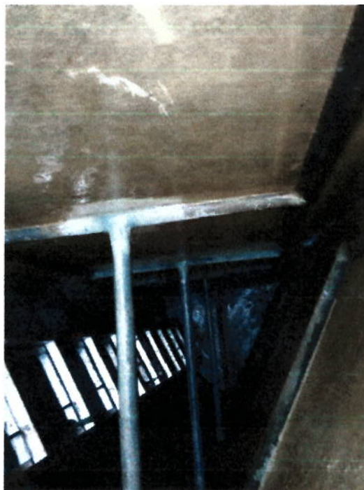
TUBERIA DE DIAMETRO 2" RECUBIERTO EN FIBRA DE VIDRIO PLANTA SAN JOSE
