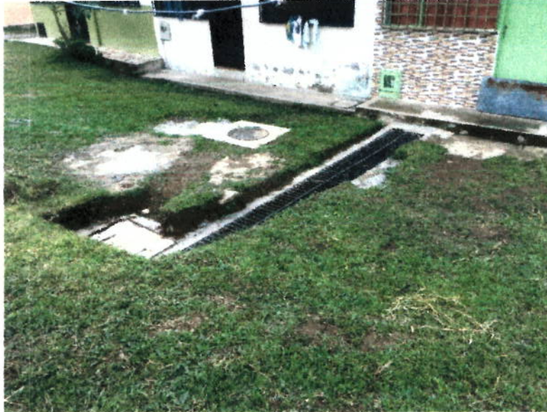
CONSTRUCCIÓN DE IMBORNALES COMPLETO EN CONCRETO
