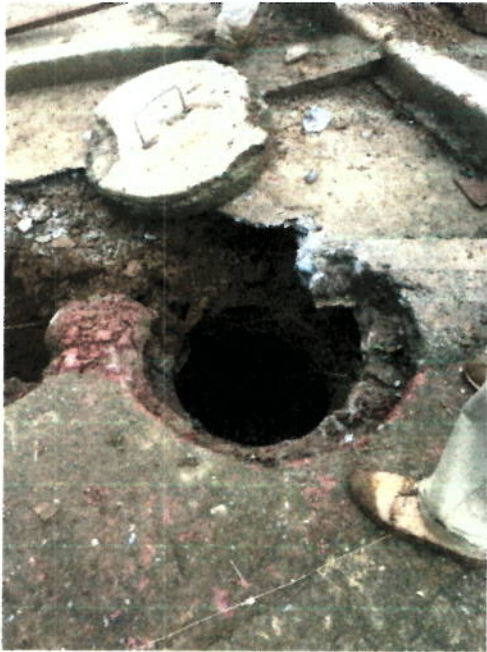
DEMOLICIÓN DE ESTRUCTURAS EN CONCRETO (GIRASOLES)
