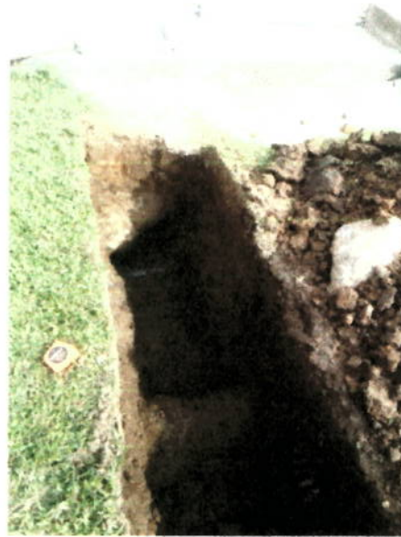
EXCAVACIONES EN MATERIAL COMUN (FILAELDIA)
