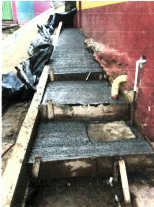
CONCRETO DE 21 Mpa PARA GRADERIAS Y ANDENES
