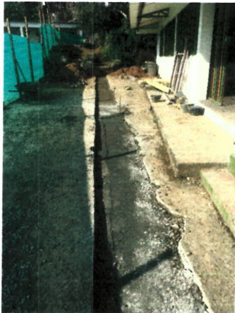
SUB BASE PARA PAVIMENTO
