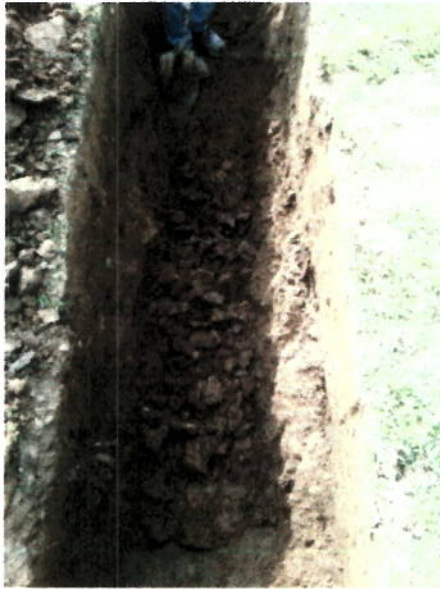
EXCAVACIONES EN MATERIAL COMUN (FILAELDIA)
