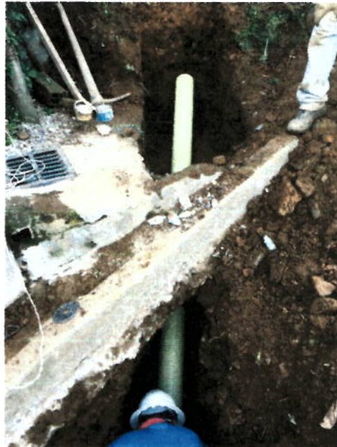
INSTALACIÓN TUBERIA PVC DE 6" PARA DOMICILIARIAS
