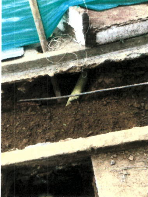
INSTALACIÓN TUBERIA PVC DE 6" PARA DOMICILIARIAS
