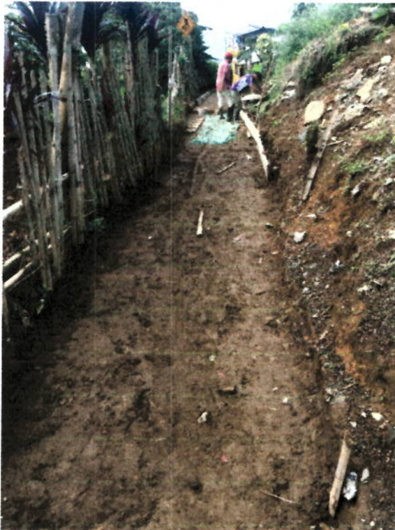
LLENO COMPACTADO CON MATERIAL DE OBRA
