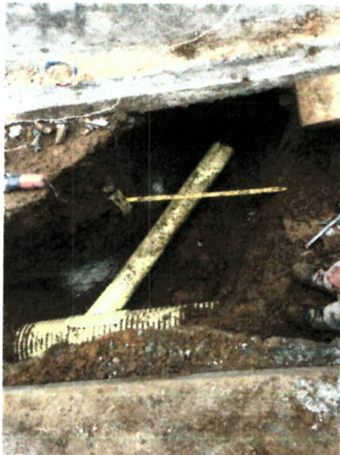
INSTALACIÓN DE SILLETAS DE 12" X 6"
