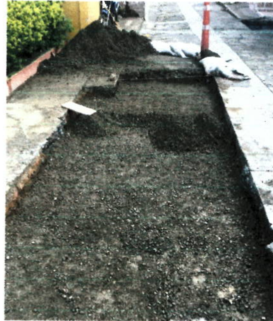
SUB BASE PARA PAVIMENTO
