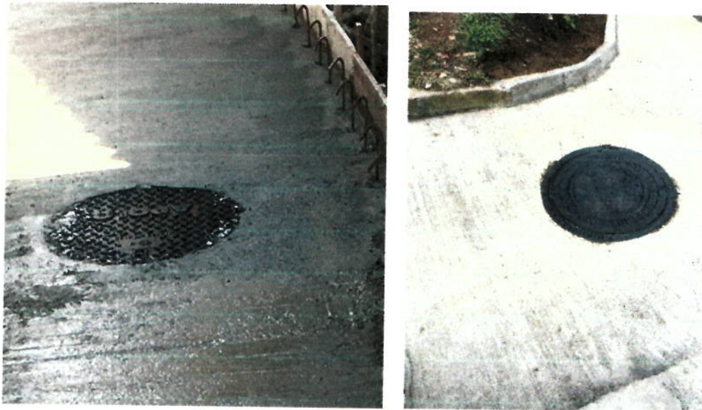
SUMINISTRO E INSTALACIÓN TAPA CON ARO PARA PÓZO
