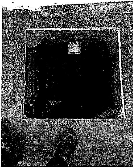
CAJAS DE INSPECCIÓN DE 50 X 50 PARA DOMICILIARIAS
