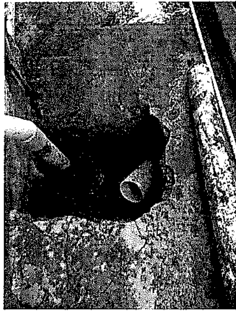
INSTALACIÓN DE TUBERÍA 6"
