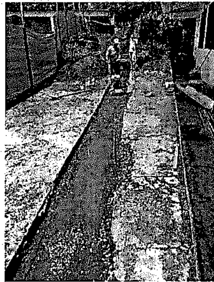
SUBBASE PARA PAVIMENTO
