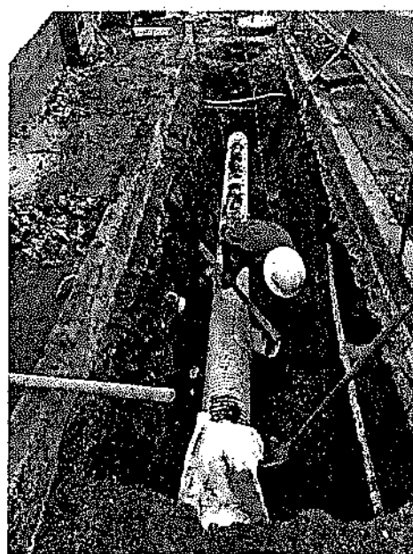
INSTALACIÓN DE SILLETAS DE 12" X 6"
