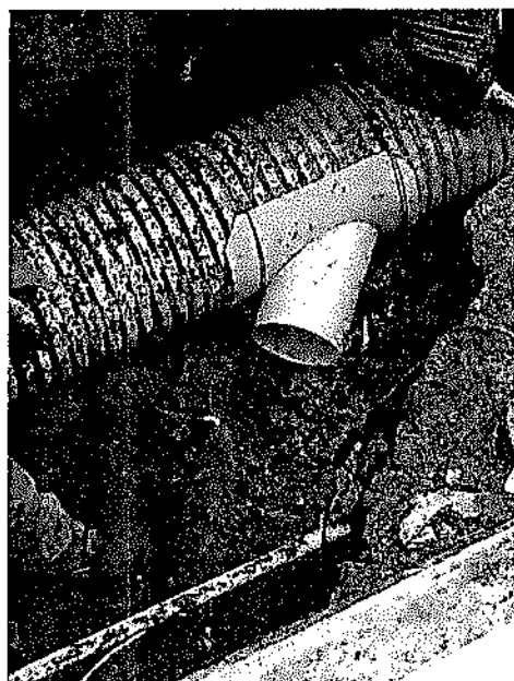
INSTALACIÓN DE SILLETAS DE 12" X 6"
