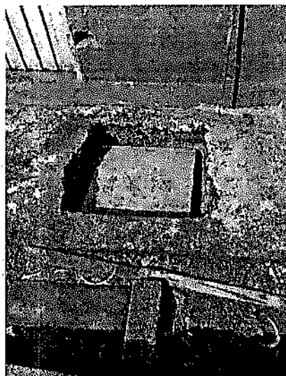
CAJAS DE INSPECCIÓN DE 50 X 50 PARA DOMICILIARIAS
