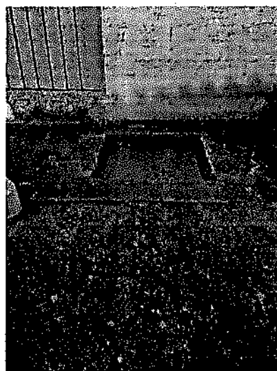
CAJAS DE INSPECCIÓN DE 50 X 50 PARA DOMICILIARIAS
