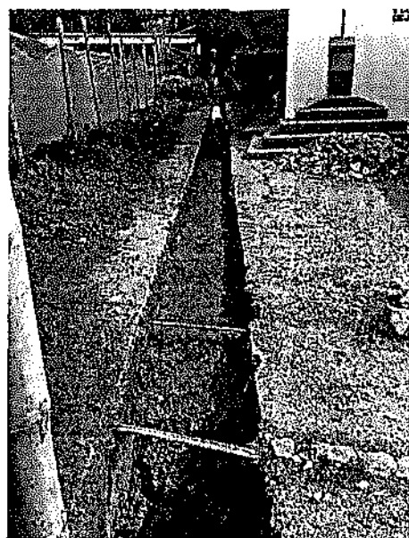
LLENO COMPACTADO CON MATERIAL DE OBRA
