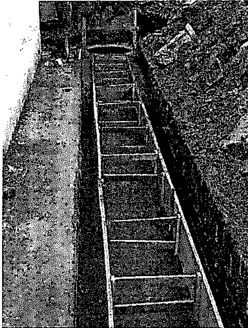
CONCRETO DE 21 Mpa PARA GRADERIAS Y ANDENES
