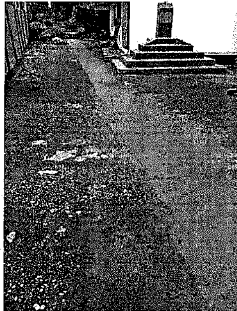
CONCRETO PARA PAVIMENTO 42 MR
