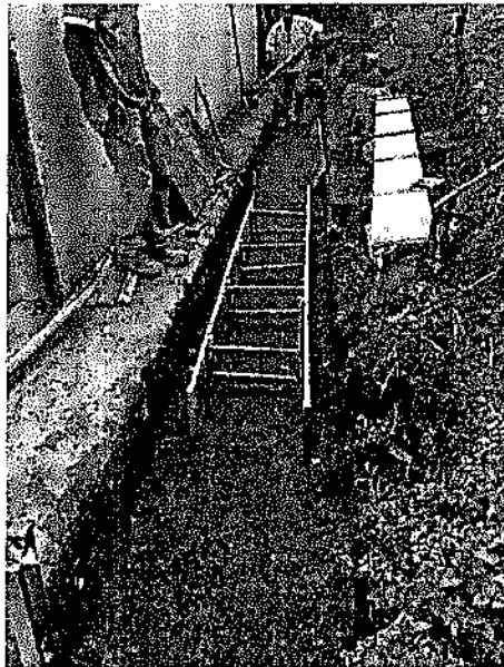
CONCRETO DE 21 Mpa PARA GRADERIAS Y ANDENES
