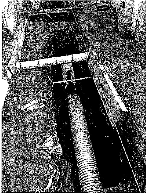
INSTALACIÓN DE TUBERIA 12"
