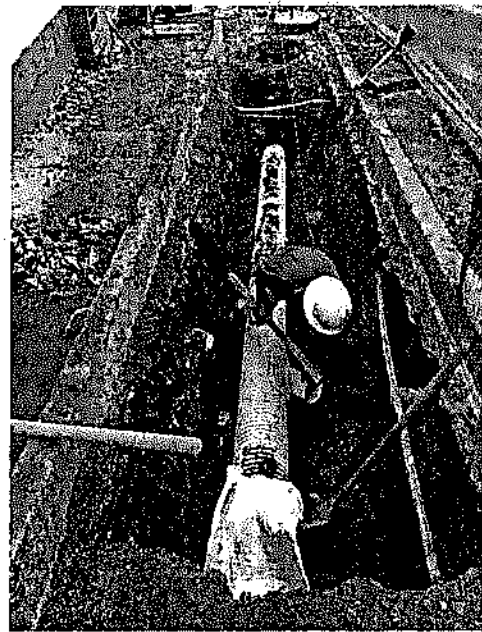
INSTALACIÓN DE TUBERIA 12"
