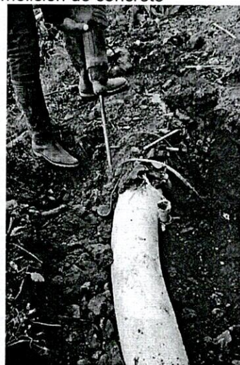
Demolición de concreto
