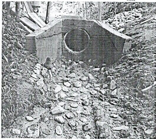
FOTO 1. Vista de la estructura en concreto con aletas para el descole de las aguas captadas desde la parte superior (vía Cantadelicia-Aranzazu).
