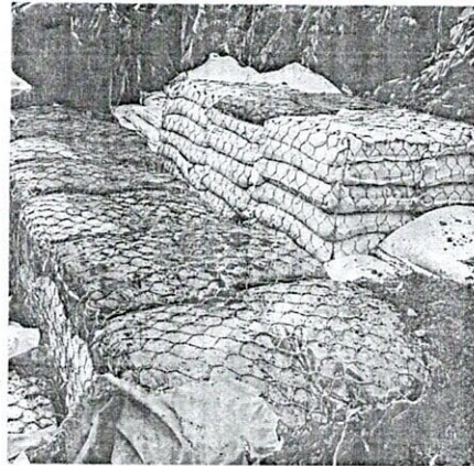
FOTO 4. Complemento de la anterior. Vista del proceso de construcción antes de llenos
