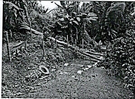
FOTO 6. Lleno conformado entre las dos laderas, generando dique de contención con desvío permanente de aguas empleando la tubería de gran diámetro en reposición.
