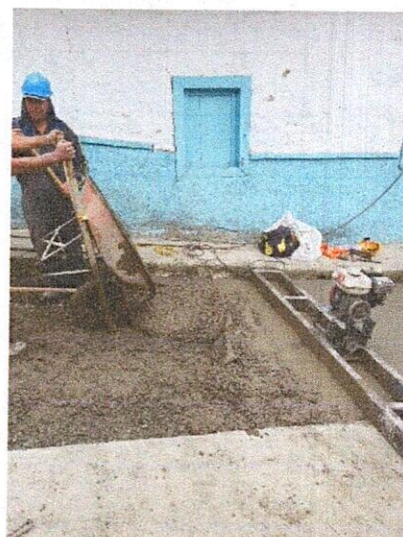
FOTO 8. Vaciado de concreto.
