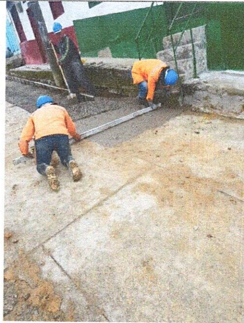
FOTO 10. Nivelado del concreto
