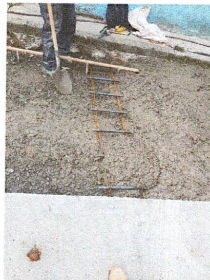
FOTO 12. Suministro e instalación de dovelas.
