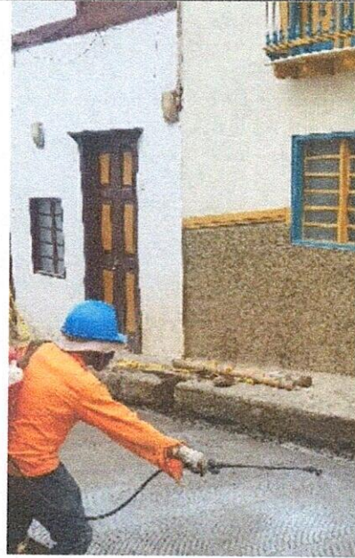
FOTO 18. Aplicación de antisol
