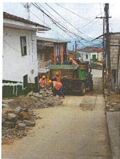
FOTO 7. Retiro de escombros.
