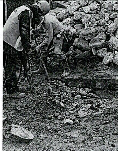
FOTO 2. Demoliciones placa de concreto en mal estado
