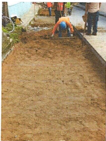
FOTO 5. Excavación para sub-base
