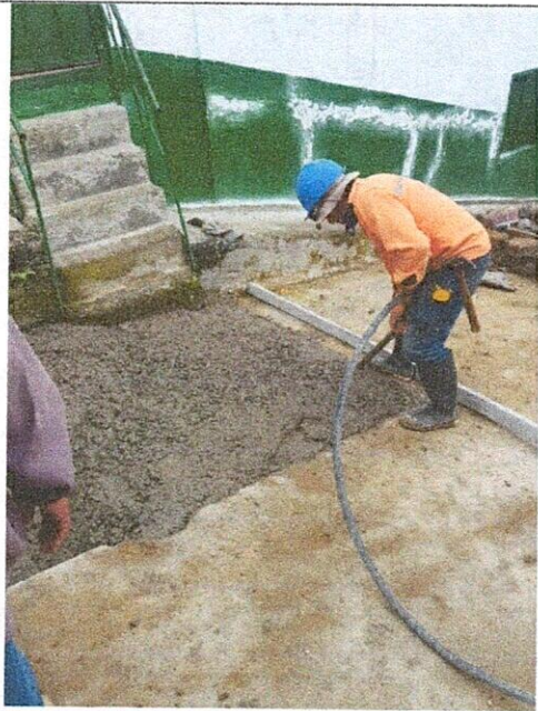
FOTO 9. Vibrado del concreto.
