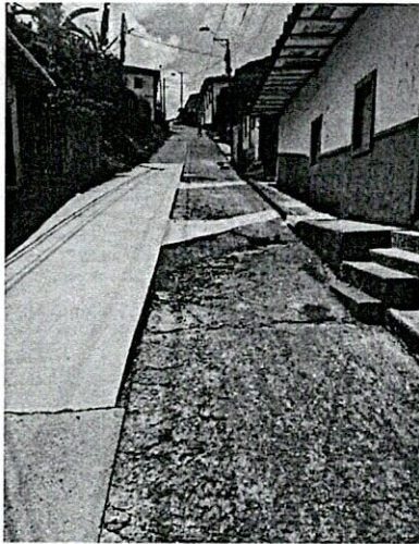
FOTO 1. Vista inicial del sitio de intervención
