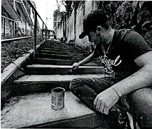
FOTO 3. Técnica de pintura de la contrahuella manualmente una a una.
