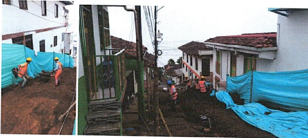
SEÑALIZACIÓN DE LA OBRA.
