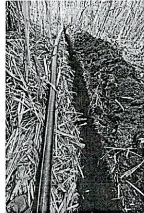
Imagen 5 y 6. Tubería de polietileno 4 pulgadas para reparación
