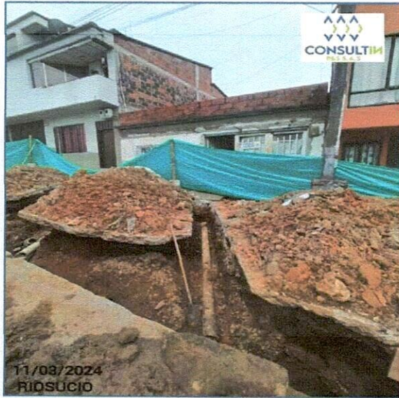
Instalación de silletas de 14"x6"
