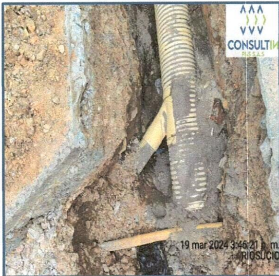
Instalación de silletas de 14"x6"
