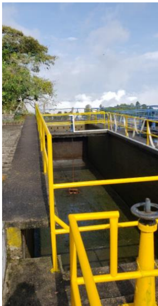
Sedimentador 2 desocupado para su inspección .
