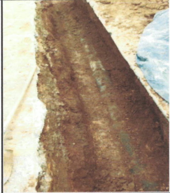
Descripción: Excavaciones en zanja - material Común 0 a 2 m y Excavaciones en Material Conglomerado
