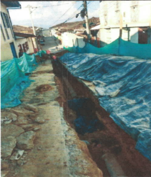
Descripción: Excavaciones en zanja - material Común 0 a 2 m y Excavaciones en Material Conglomerado
