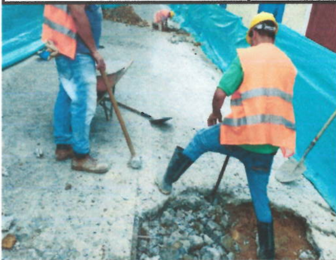
Descripción: Demoliciones de pavimentos rígidos y Demoliciones varias de muros en concretos, otros
