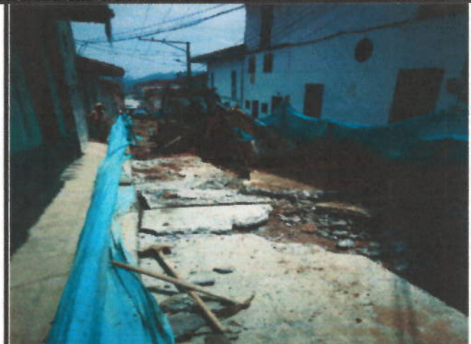
Descripción: Excavaciones en zanja - material Común 0 a 2 m y Excavaciones en Material Conglomerado
