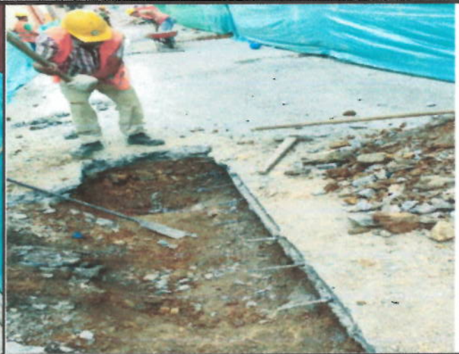
Descripción: Demoliciones de pavimentos rígidos y Demoliciones varias de muros en concretos, otros
