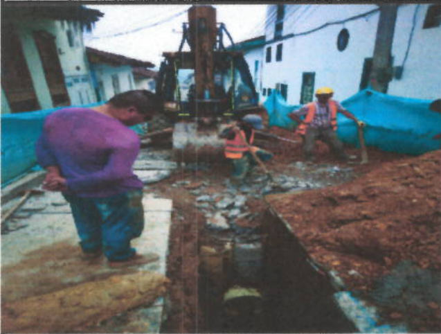
Descripción: Excavaciones en zanja - material Común 0 a 2 m y Excavaciones en Material Conglomerado
