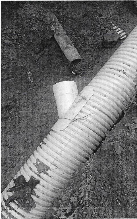
INSTALACIÓN DE SILLETA
