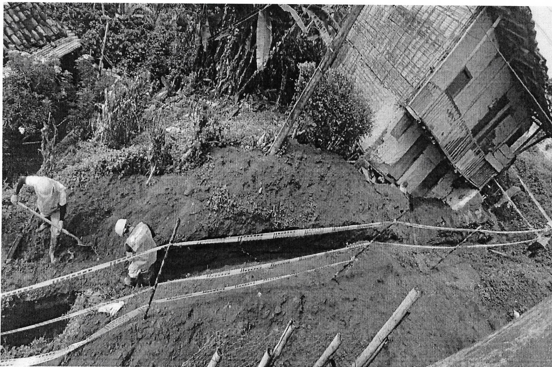
EXCAVACIÓN PARA INSTALACIÓN DE TUBERÍA
