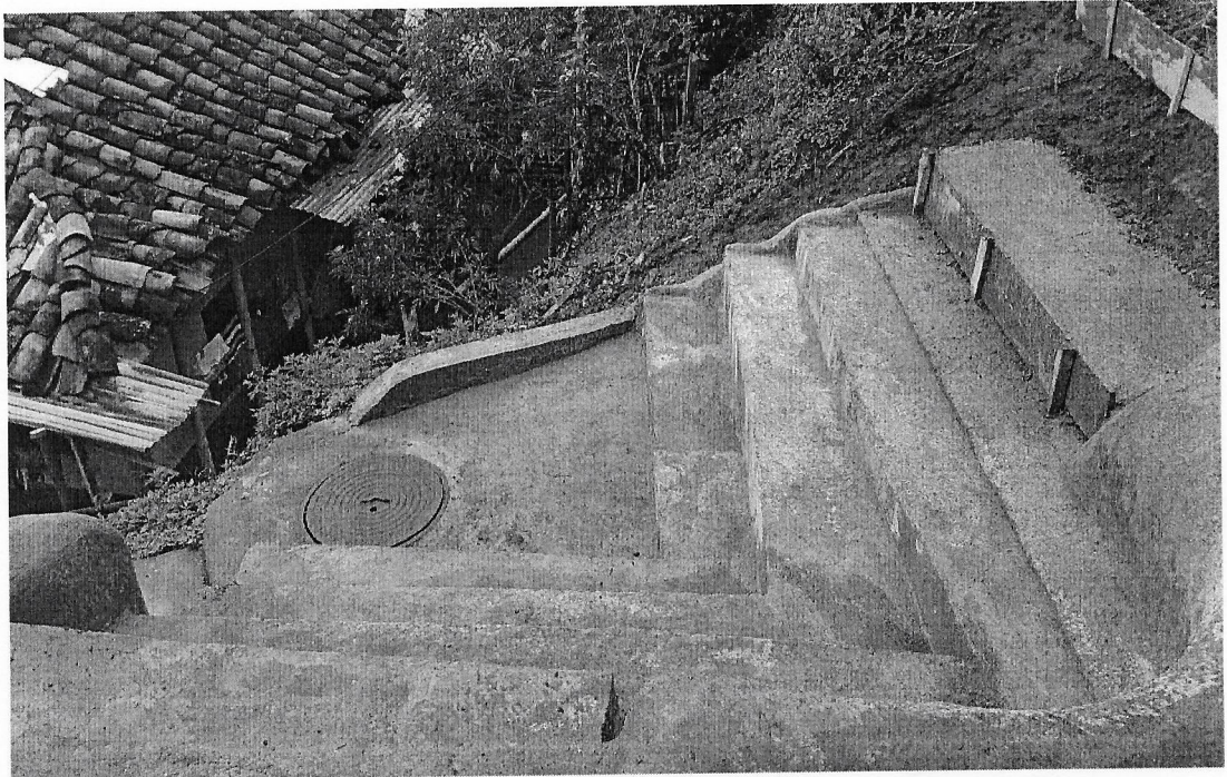
TERMINADO FINAL DE CÁMARA Y GRADAS EN CONCRETO PARA CONFINAMIENTO DEL TERRENO
