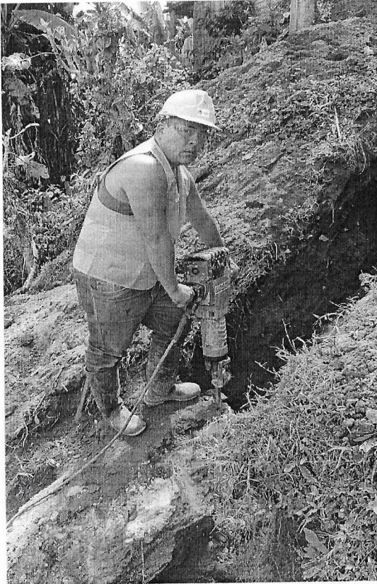
DEMOLICIÓN DE MURO EXISTENTE
