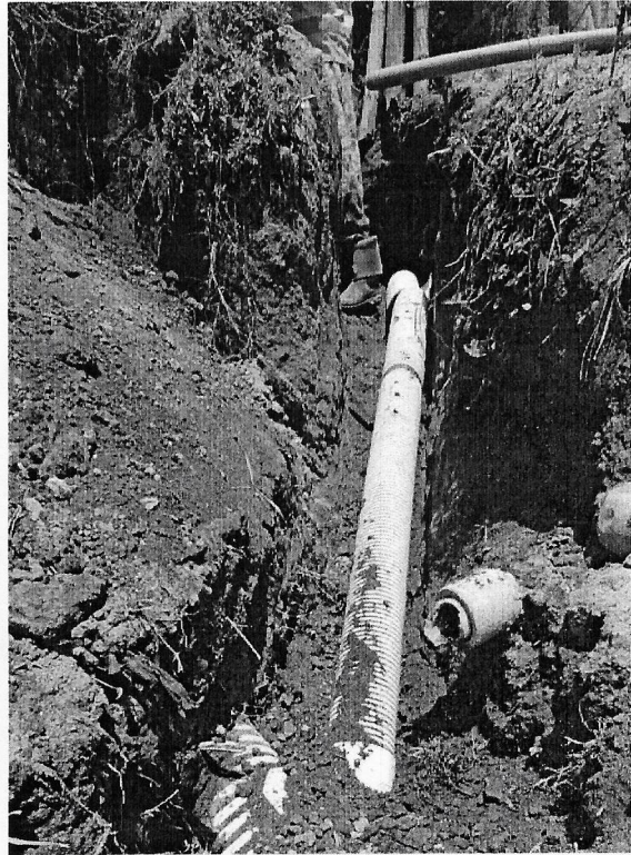
INSTALACIÓN DE TUBERÍA RED DOMICILIARIA
