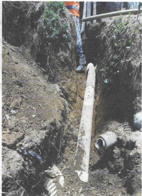
INSTALACIÓN DE TUBERÍA RED DOMICILIARIA
