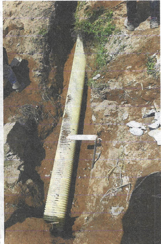
INSTALACIÓN DE TUBERÍA RED PRINCIPAL
