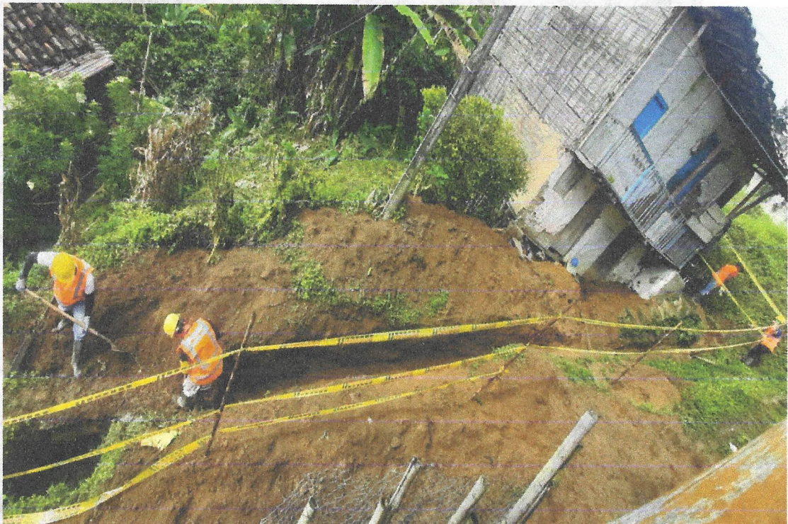
EXCAVACIÓN PARA INSTALACIÓN DE TUBERÍA
