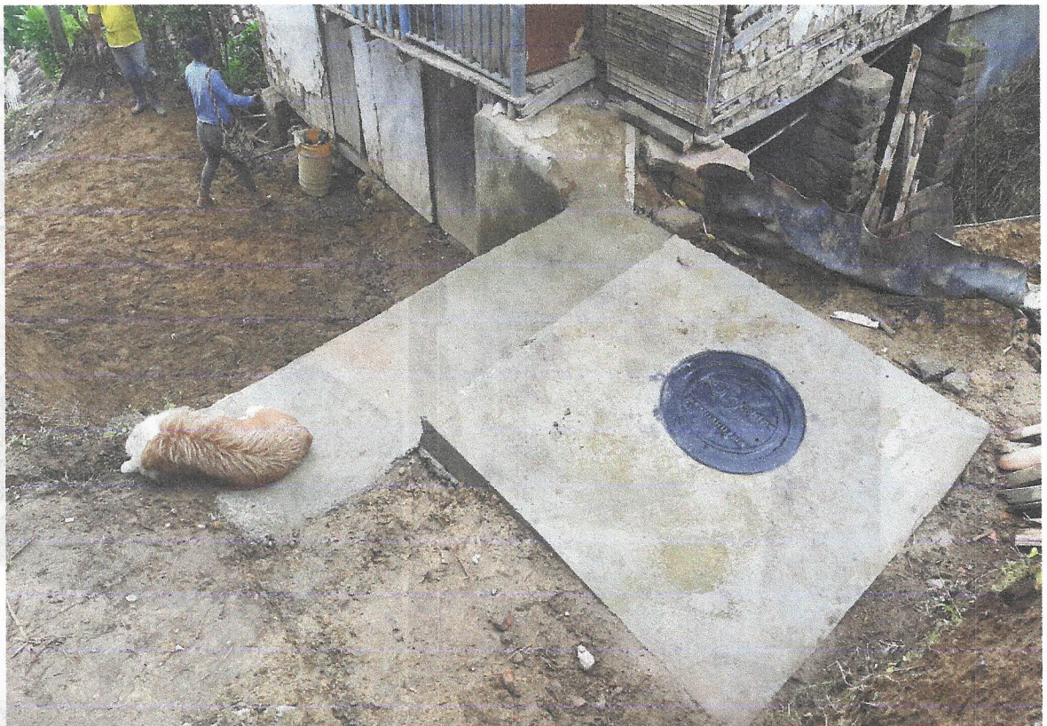
TERMINADO FINAL DE CÁMARA 2 Y ENTRADA A VIVIENDA
