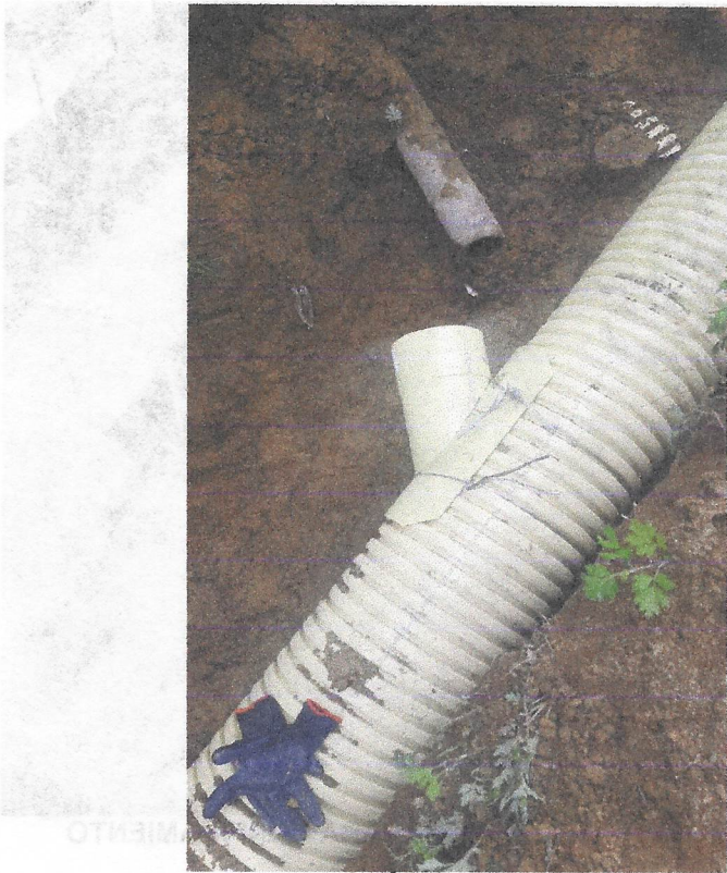
INSTALACIÓN DE SILLETA
