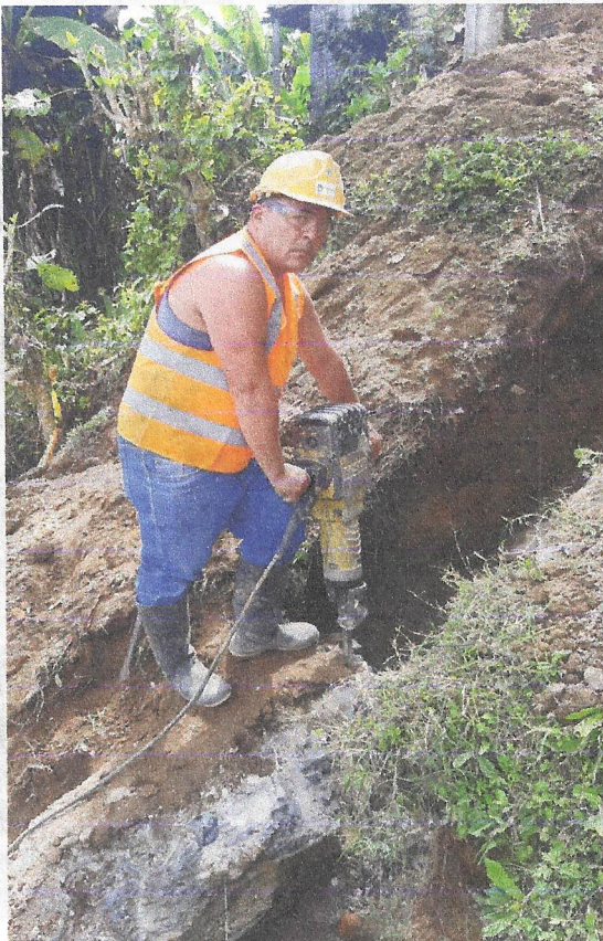
DEMOLICIÓN DE MURO EXISTENTE
