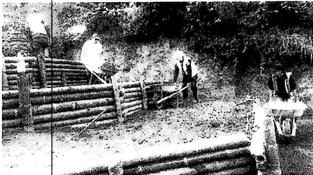
CONSTRUCCIÓN DE TRINCHOS EN GUADUA COMO ÚLTIMA ACTIVIDAD EJECUTADA
