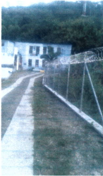
HUELLAS ZONAS DE ACCESO A LA PUERTA
