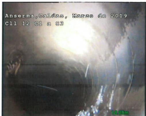
Desde los 21,8 m presenta achatamiento que se agudiza a los 25 m, donde se presenta un fenómeno de rotura o desprendimiento de la junta en la batea (piso) de la tubería:
