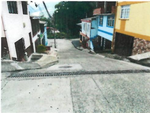
En este sitio, se encuentra una reja transversal de captación de aguas lluvias y una cámara C13 que es simplemente para recibir las aguas captadas y entregarlas a la tubería del tramo C12 – C14
