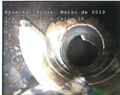
La cámara C22 tiene la cañuela rota, permitiendo la infiltración del agua al terreno. En este sector se nota fisuración entre el pavimento y el sardinel:
