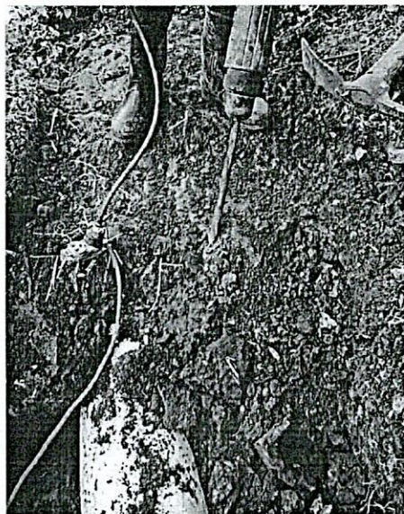
Imágenes 3 y 4. Tubería PVC afectada con el movimiento del terreno
