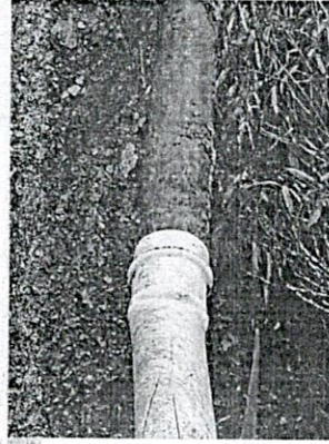
Fotos 1 y 2. Afectación de la conducción al corregimiento de Arma por deslizamiento en el sector de la Casianera, generando desempate de la unión de tubería de PVC y AC.
