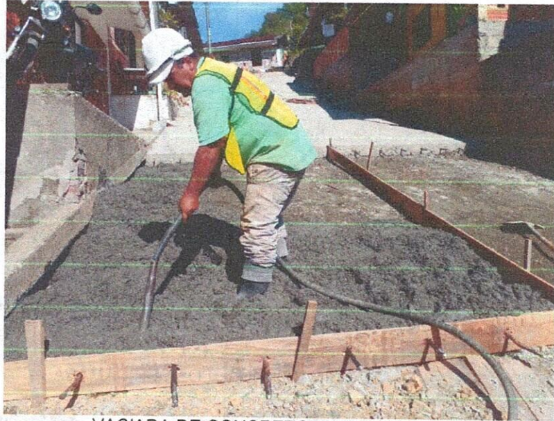
VACIADA DE CONCRETO HECHO EN OBRA
