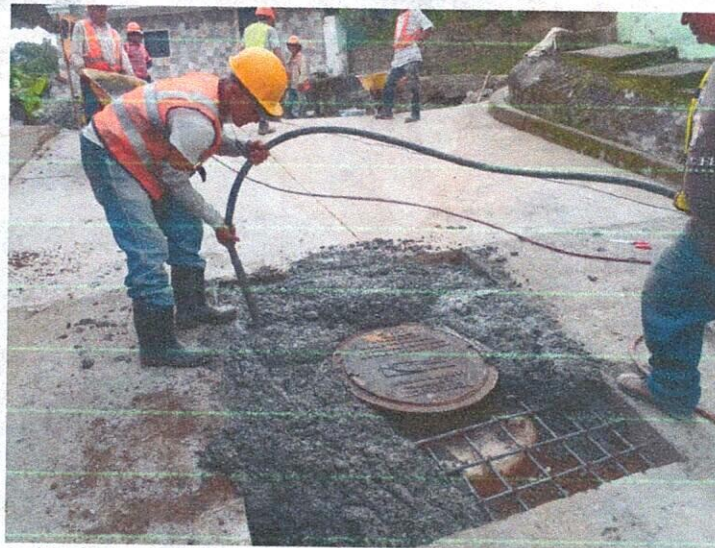
VACIADO DE LOSA PARA CAMARA EMPARRILLADO
