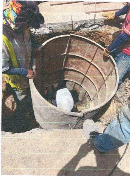
CONSTRUCCIÓN DE CÁMARA
