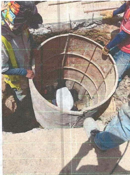
CONSTRUCCIÓN DE CÁMARA
