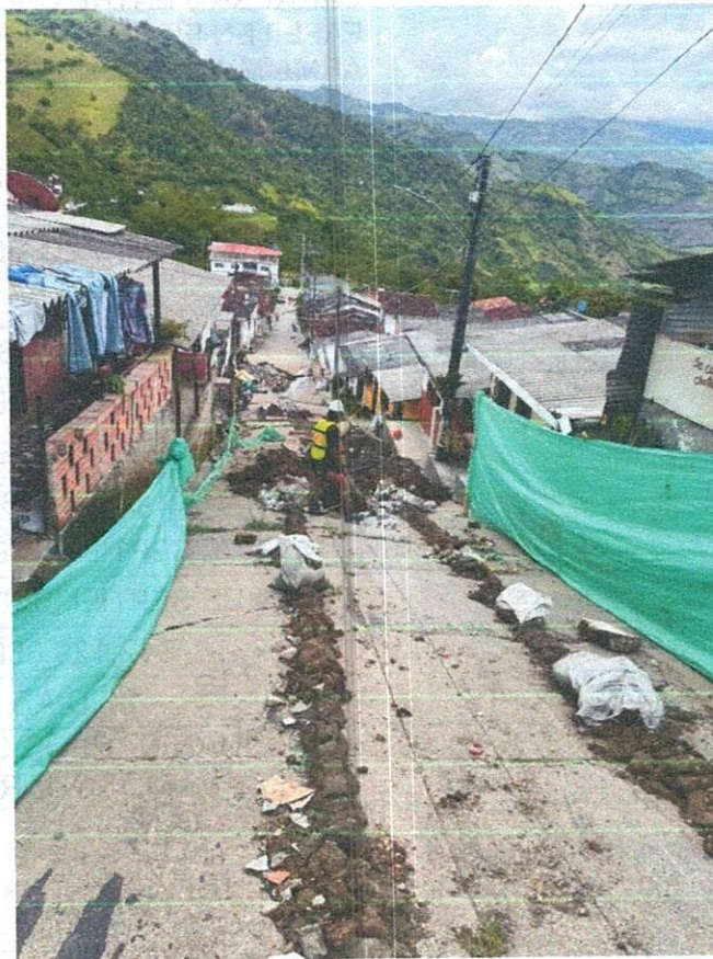
DEMOLICIÓN E INSTALCIÓN DE TUBERÍA
