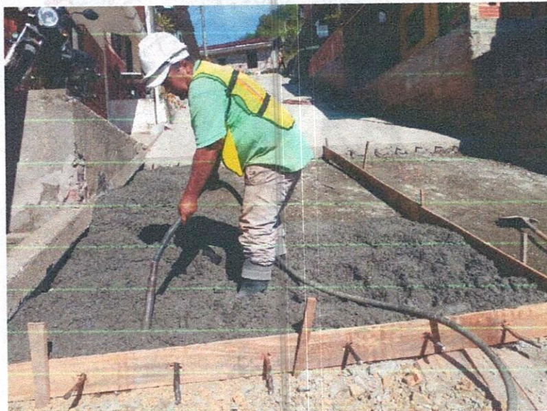
VACIADA DE CONCRETO HECHO EN OBRA
