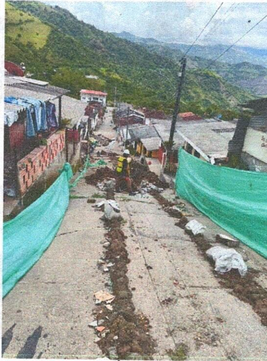
INSTALCIÓN DE TUBERÍA
