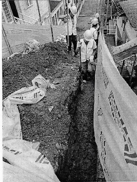
Imagen 9. Inicio de excavación en material común en zanja.
