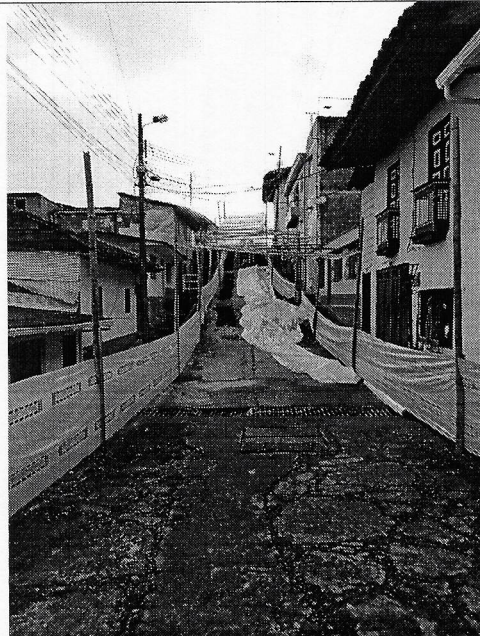
Imagen 10. Construcción de techado provisional en plástico y guadua.
