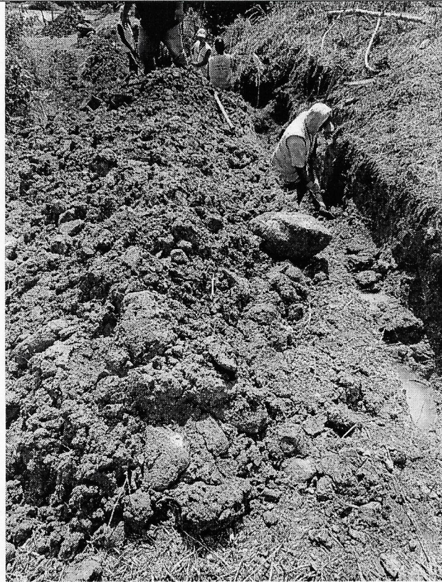
Imagen 17. Comienzo de excavación en zanja.
