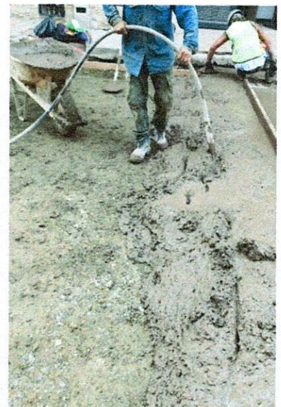
Fotografías No. 16,17,18// Tapa en HF para cámara, aro de tapa, dovelas con canastilla de soporte, vaciado y vibrado de pavimento MR42
