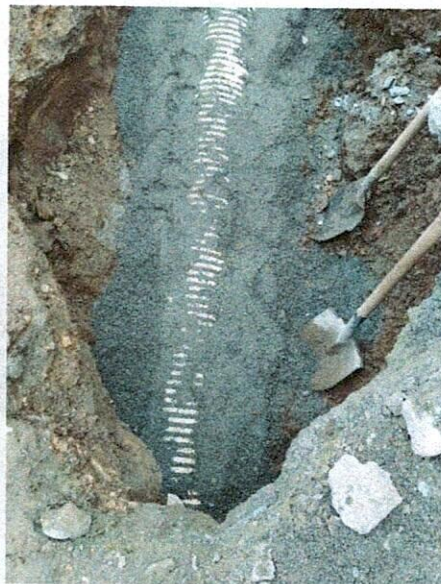
Fotografías No. 7,8 y 9// tubería de 12", cama de arena, recuperación de imbornal existente.
