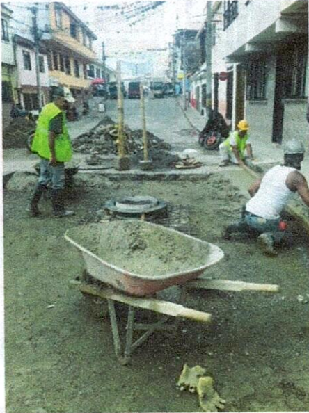
Fotografías No. 10,11,12// Subbase, reconstrucción cañuela, mantenimiento de cámara de gran profundidad
