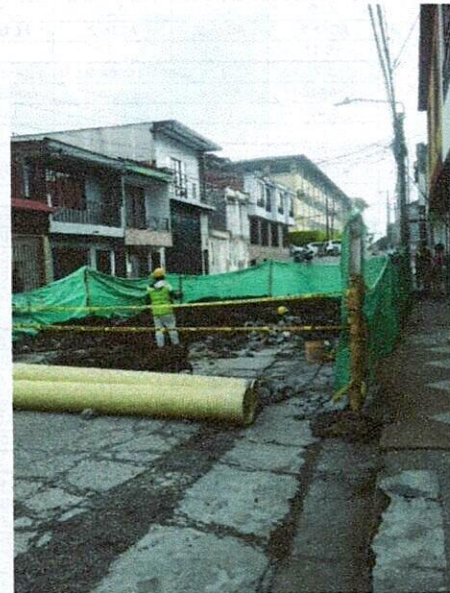
Fotografías No. 1,2 y 2// Valla de la obra, señalización vertical y cerramiento provisional
