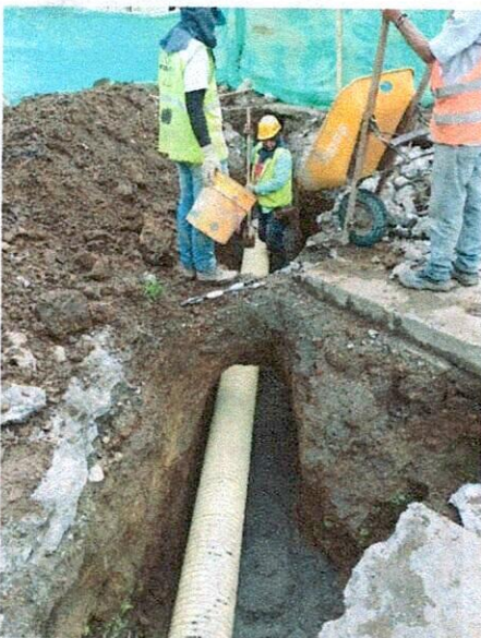
Fotografías No. 7,8 y 9// tubería de 12", cama de arena, recuperación de imbornal existente.
