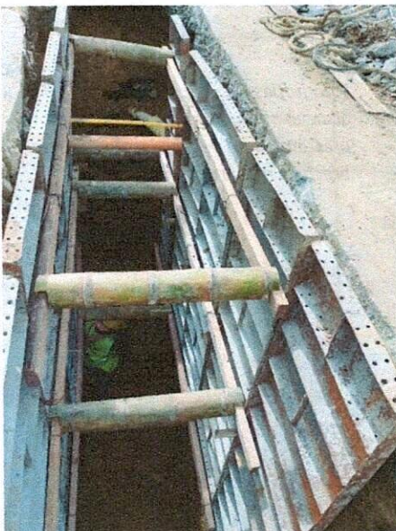
Fotografías No. 1,2,3,4,5 y 6 // valla institucional, demoliciones, excavaciones, entibado metálico, tubería de 24", derrumbes en brecha
