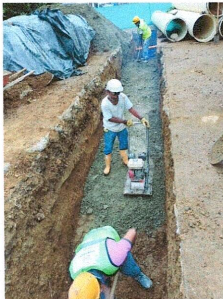
Fotografías No. 13,14,15,16 //Table estacado, Llenos compactados mecánicamente
