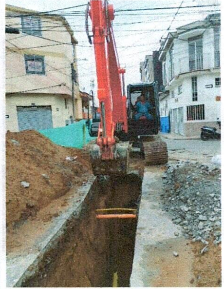
Fotografías No. 1,2,3,4,5 y 6 // valla institucional, demoliciones, excavaciones, entibado metálico, tubería de 24", derrumbes en brecha
