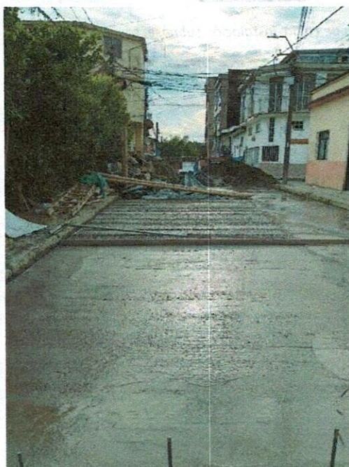
Fotografías No. 7 y 8 // dovelas para pavimento, vaciado de pavimento.
