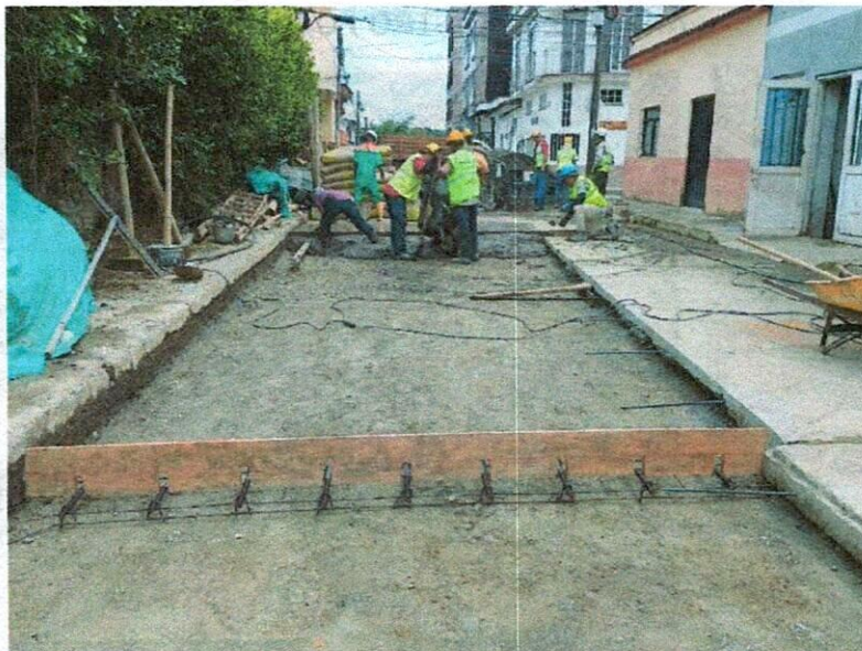
Fotografías No. 7 y 8 // dovelas para pavimento, vaciado de pavimento.
