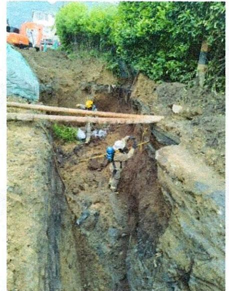
Fotografías No. 03,04 y 05// Excavaciones profundas, Tablestacado, deslizamiento y redes de gas presentes.
