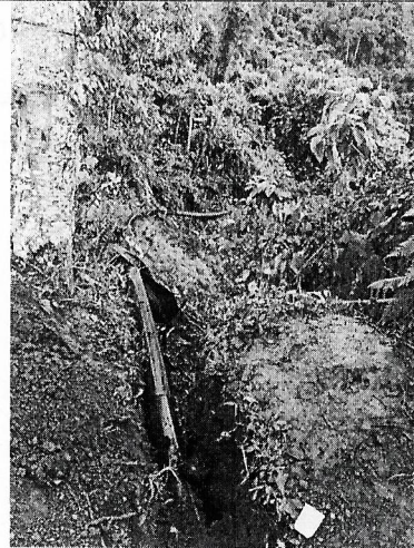
Reparación mediante termo fusión de tubería
