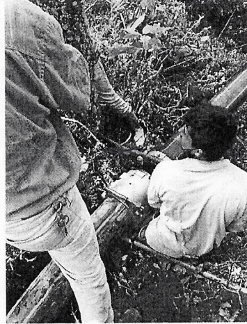
Reparación mediante termo fusión de tubería
