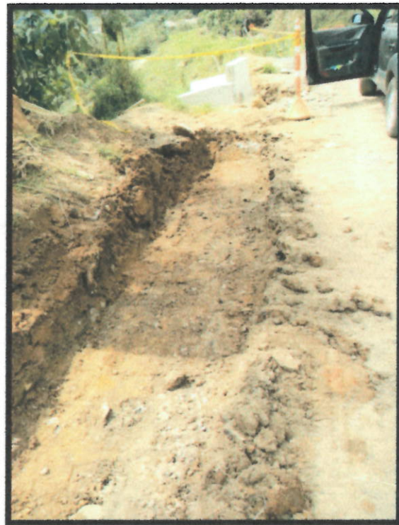
Foto N°10. Excavación para reemplazo de material
