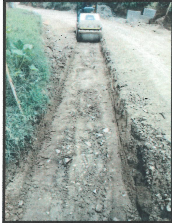
Foto N°2. Excavación para reemplazo de material
