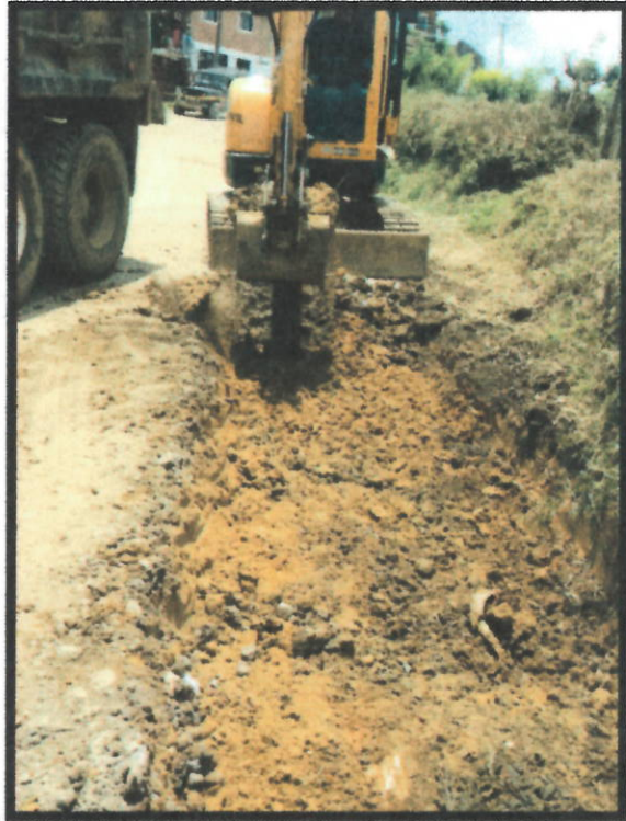
Foto N°6. Excavación para reemplazo de material
