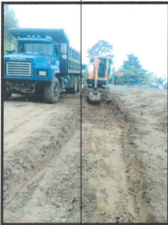
Foto N°9. Excavación para reemplazo de material
