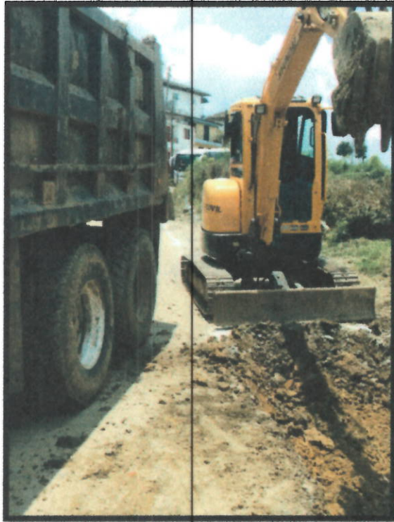
Foto N°5. Excavación para reemplazo de material
