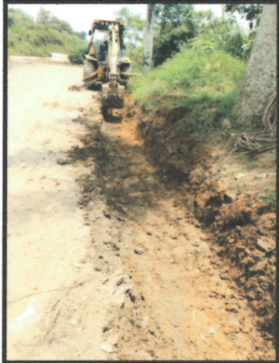
Foto N°6. Excavación para reemplazo de material
