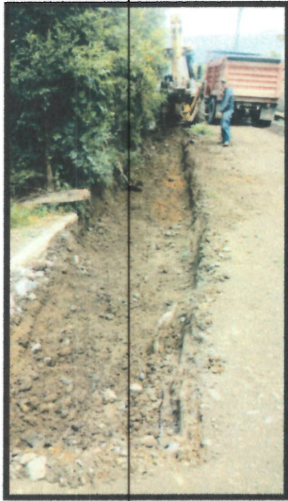
Foto N°9. Excavación para reemplazo de material
