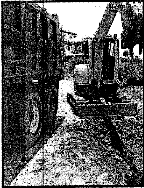
Foto N°5. Excavación para reemplazo de material
