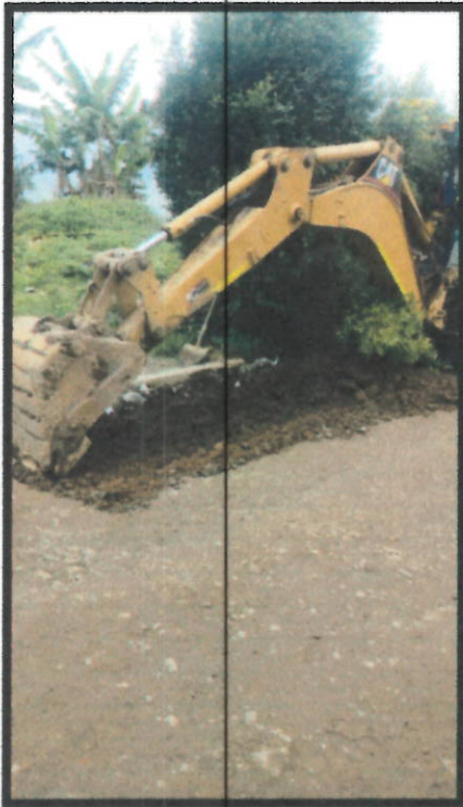
Foto N°1. Excavación para reemplazo de material
