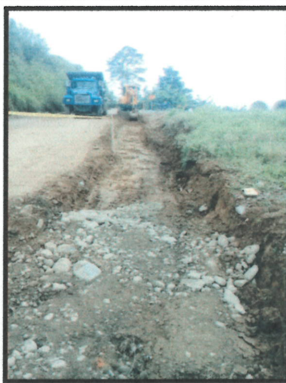
Foto N°14. Relleno para Estructuras con Recebo
