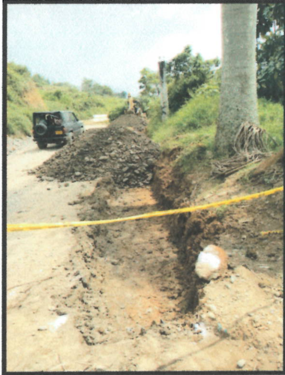
Foto N°18. Relleno para Estructuras con Recebo
