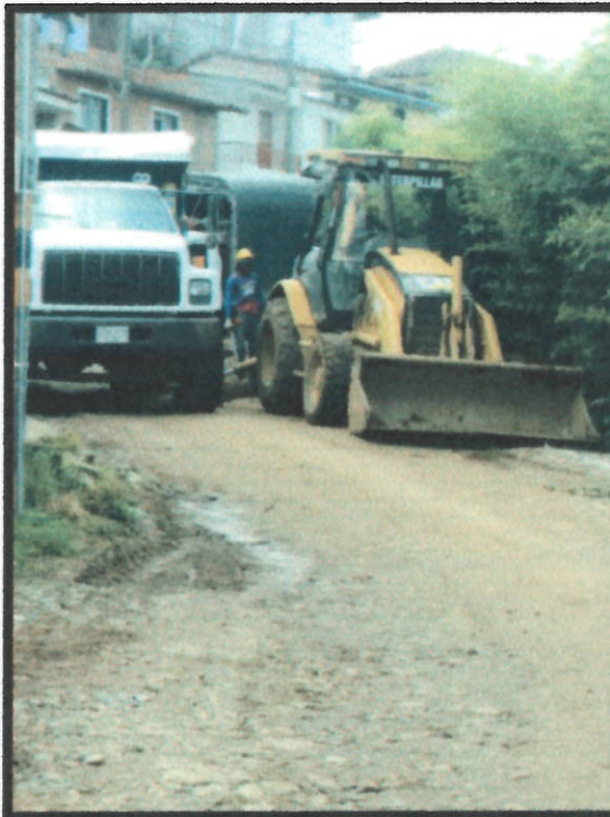
Foto N°14. Relleno para Estructuras con Recebo
