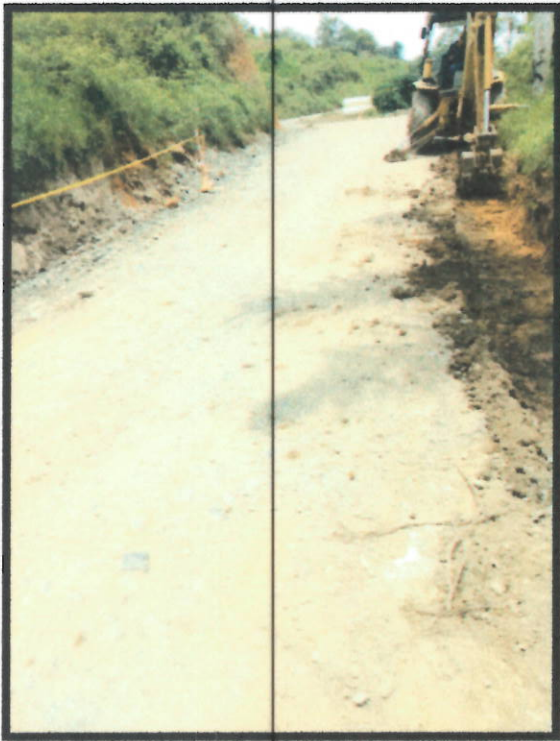
Foto N°5. Excavación para reemplazo de material
