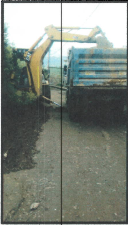
Foto N°1. Excavación para reemplazo de material
