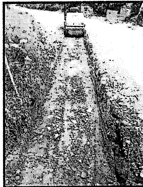
Foto N°4. Excavación para reemplazo de material
