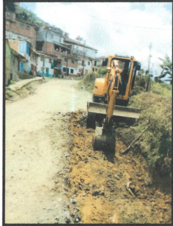
Foto N°2. Excavación para reemplazo de material
