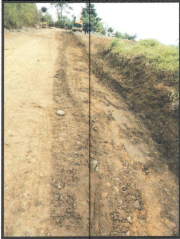
Foto N°17. Relleno para Estructuras con Recebo
