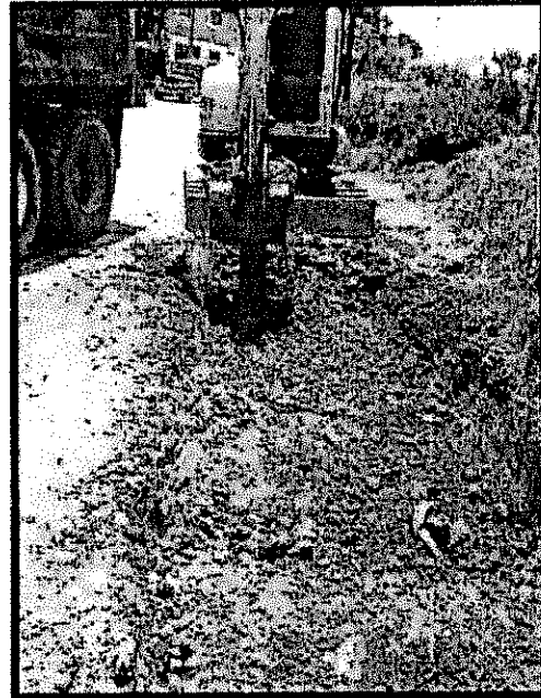
Foto N°6. Excavación para reemplazo de material
