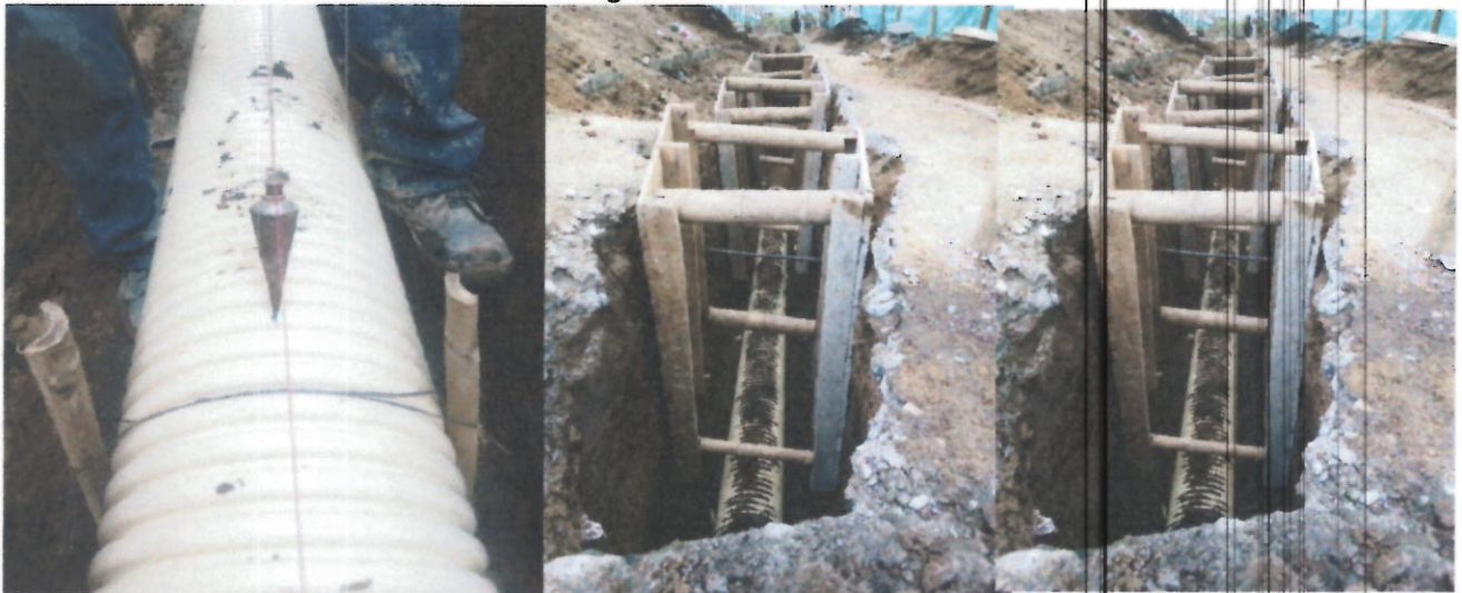
21 Instalacion de tubería PVC corrugada de 6" para domiciliarias
