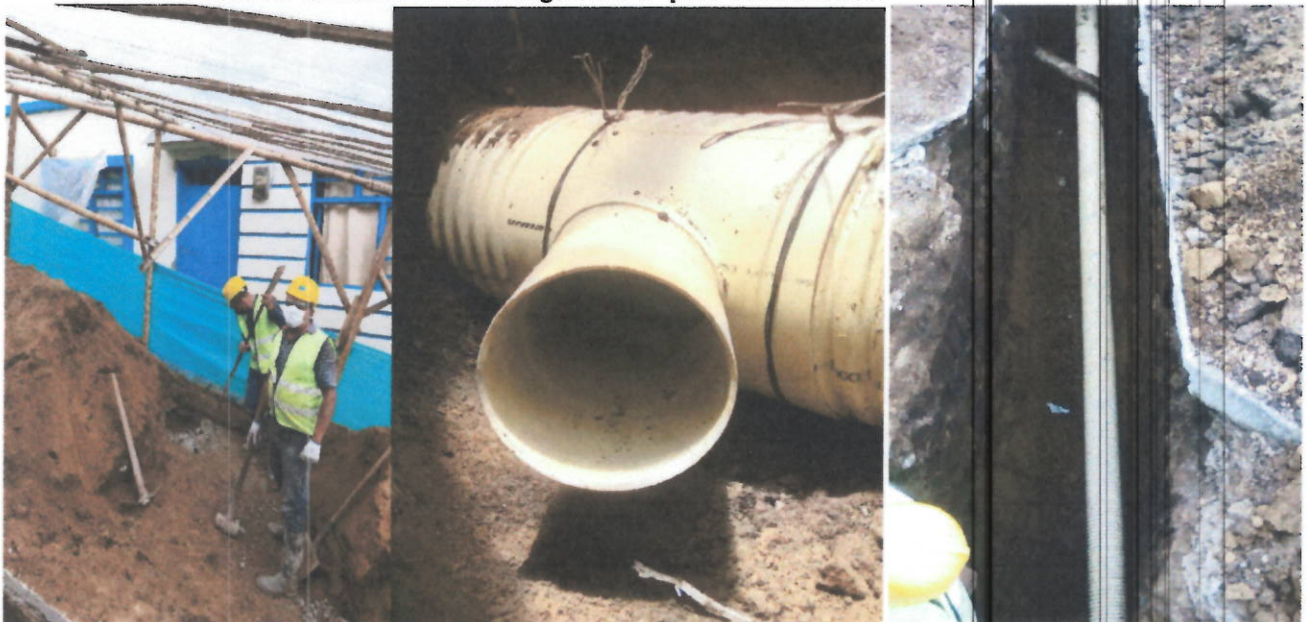
21 Instalacion de tubería PVC corrugada de 6" para domiciliarias
