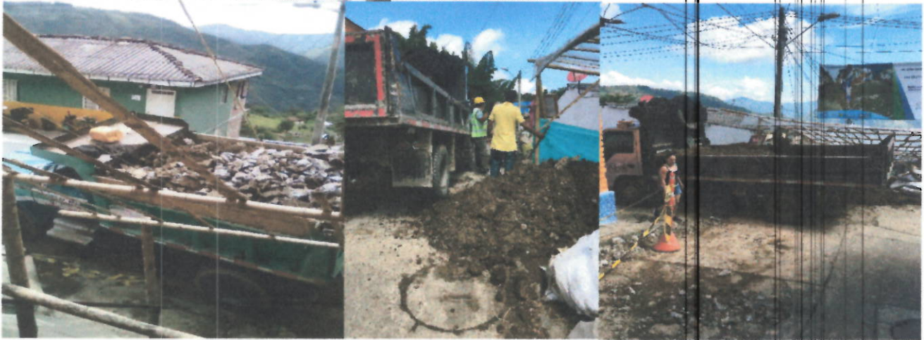
16 Instalacion de tubería PVC corrugada de 12"
