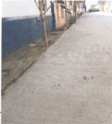
SUMINISTRO, TRANSPORTE E INSTALACION SARDINEL ANCHO = 15 CM H = 15 CM EN CONCRETO 3000 PSI
