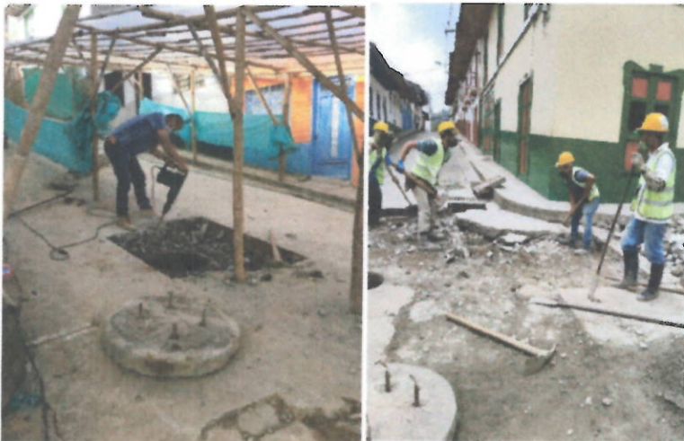
Demolición de estructuras en concreto hidráulico Incluye andenes, gradería y cañuelas
