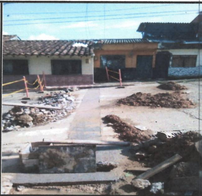
**Descripción:** Pavimento en rigido de 4000 Psi de espesor 0,20 en obra incluye Acelerante, Antisol, ensayos de laboratorios
