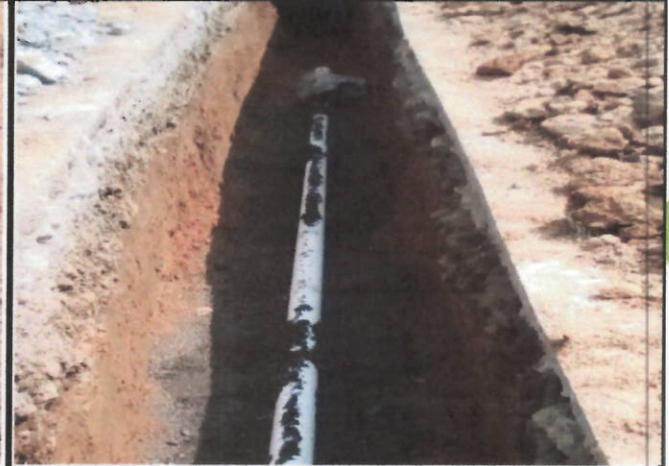
**Descripción:** Suministro e instalación de tubería corrugada PVC-S de 200 mm (ø8") incluye manejo de aguas.
