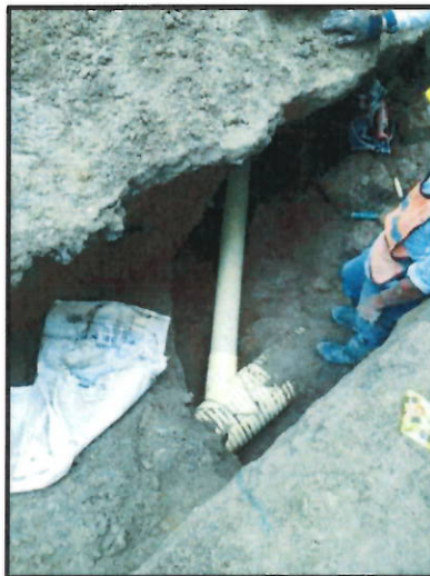
Fotografías No.16 No.17 y No. 18/ Instalación de tubería de 12", instalación de silletas, tubería de 6" para domiciliarias, evidencia de sobreechamientos en las excavaciones debido a derrumbes
