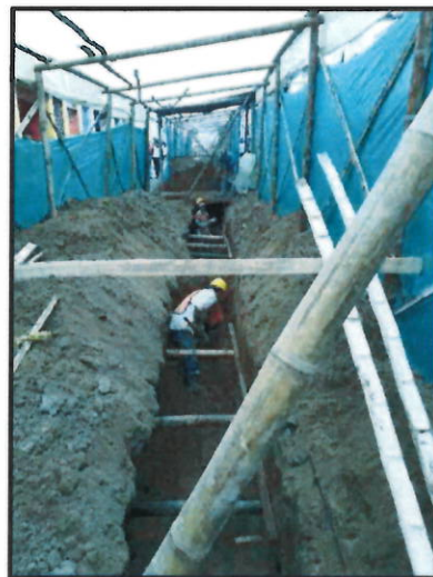
Fotografías No.4 No.5 y No. 6 / Excavaciones, cerramiento y techo provisional, demolición y excavaciones frente al cafecito para buscar tubería profunda existente
