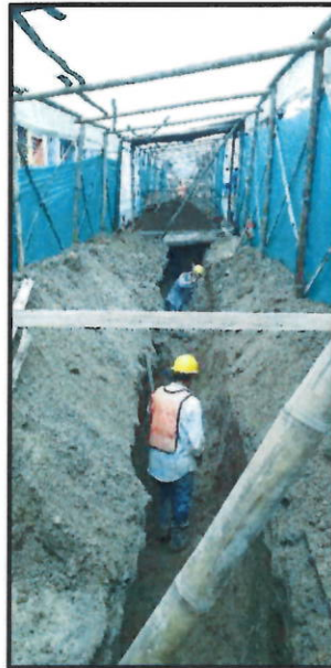
Fotografías No.4 No.5 y No. 6 / Excavaciones, cerramiento y techo provisional, demolición y excavaciones frente al cafecito para buscar tubería profunda existente
