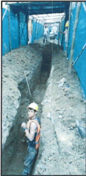
Fotografías No.4 No.5 y No. 6 / Excavaciones, cerramiento y techo provisional, demolición y excavaciones frente al cafecito para buscar tubería profunda existente
