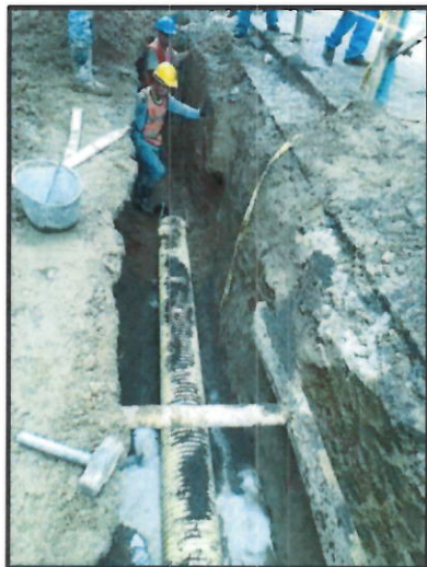
Fotografías No.16 No.17 y No. 18/ Instalación de tubería de 12", instalación de silletas, tubería de 6" para domiciliarias, evidencia de sobreechamientos en las excavaciones debido a derrumbes
