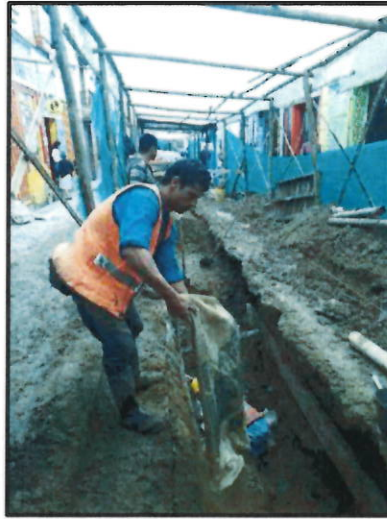
Fotografías No.13 No.14 y No. 15/ llenos con material de préstamo, sobreacarreo interno y compactación mecánica
