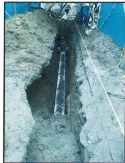
Fotografías No.4 No.5 y No. 6 / Excavaciones, cerramiento y techo provisional, demolición y excavaciones frente al cafecito para buscar tubería profunda existente
