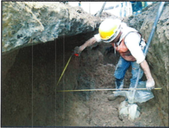
Fotografía No.7 / instalación de silletas y tubería de 6" para conexión de domiciliarias
