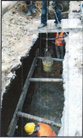
Fotografía No.2/ Excavación a más de 2 más de profundidad sacada en valdes.
