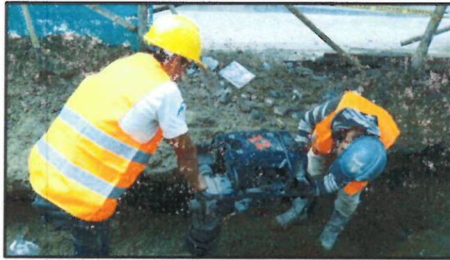
Fotografía No. 01 "compactación mecánica de llenos"
