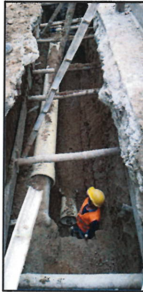
Fotografías No.4 y No. 5/ Instalación de tubería de 12” Novafort, Arena para base y atraque y entibados.
