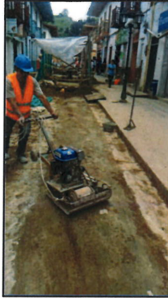
Fotografía No.3/ Llenos con material de sustitución, afinados con cemento hasta nivel del pavimento existente.
