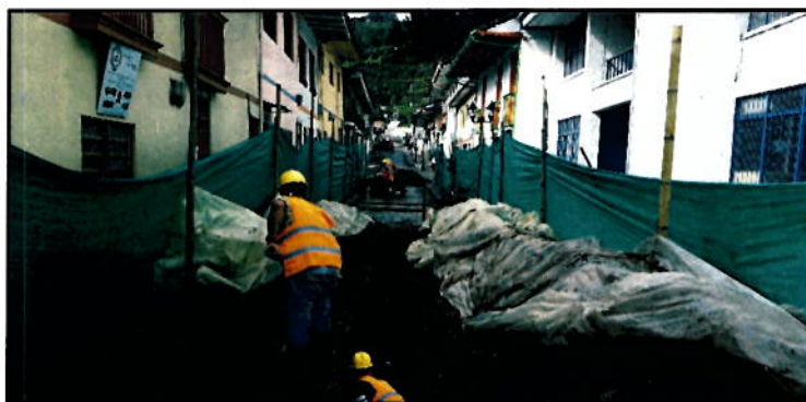
Fotografía No. 01 "cerramiento en yute, excavaciones"
