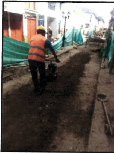
Fotografías No.5, No. 6 y No. 7 / compactación de llenos, vaciado de cámara
