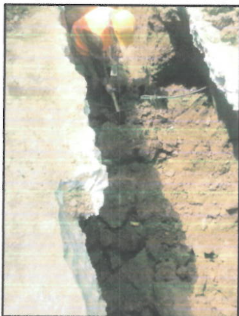
Fotografías No. 1, 2 y 3 // evidencia de sobre excavaciones en la red.
