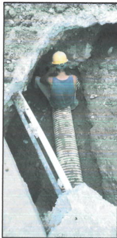
Fotografías No. 1, 2 y 3 // evidencia de sobre excavaciones en la red.
