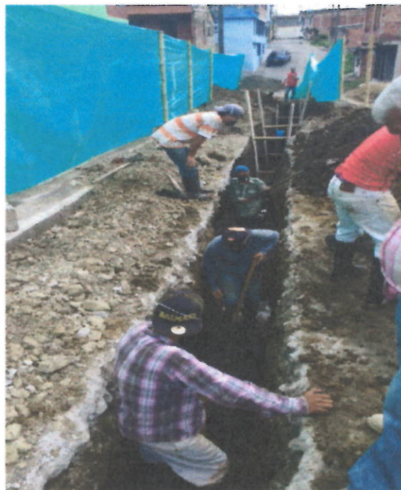
Demolicion de pavimento existente y excavacion en zanja
