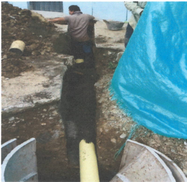
Instalación tubería 6" para domiciliaria de alcantarillado.
