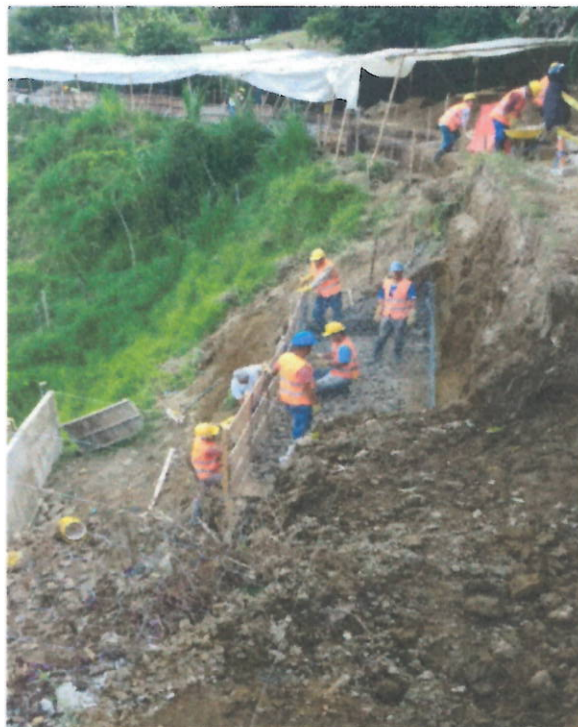
Excavaciones para instalación de nuevo muro de gaviones
