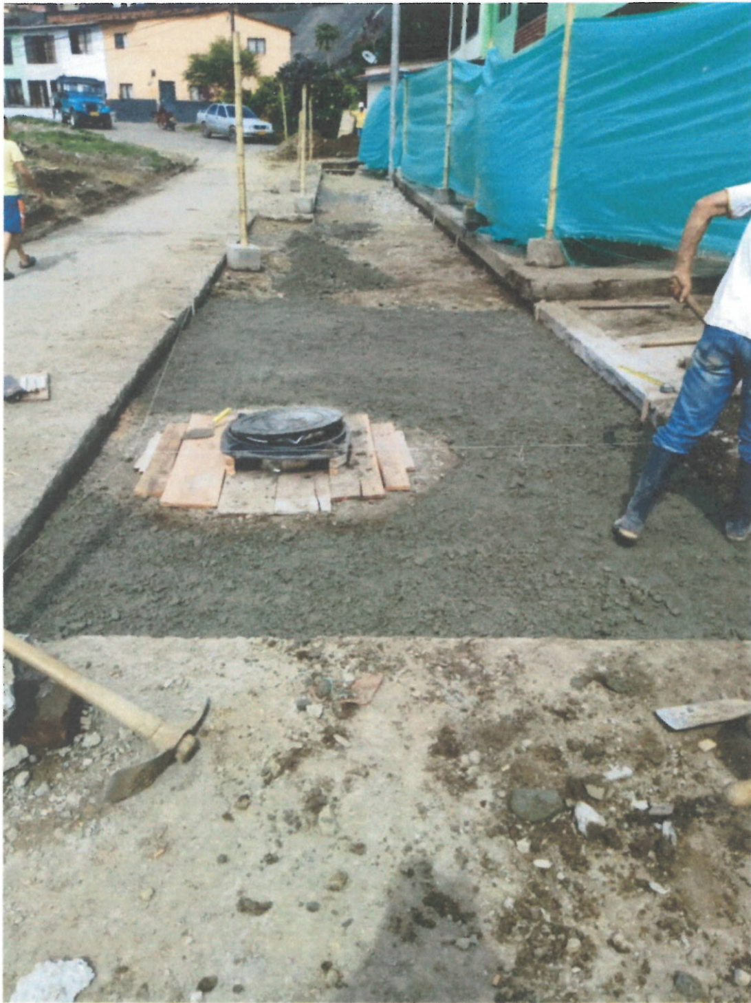
Instalación de subbase para pavimento.
