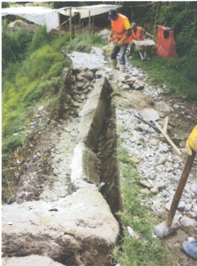
Desmonte gavioneria existente
