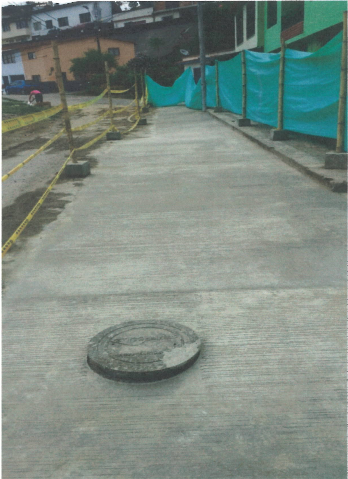
Pavimento MR 42 instalado
