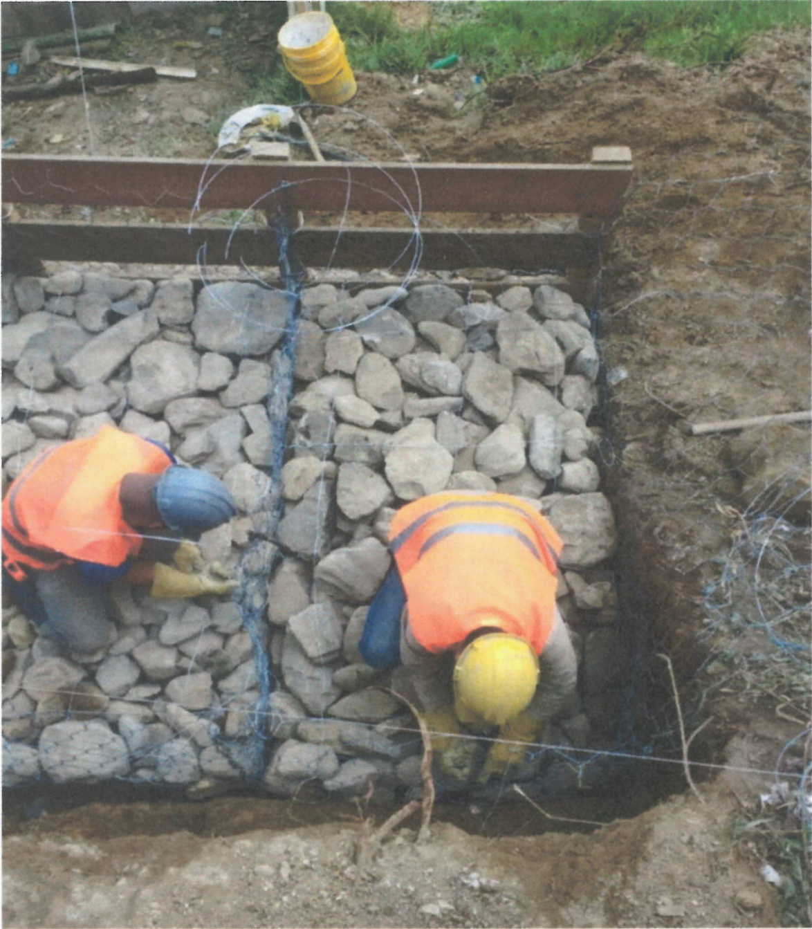
Instalación de gaviones en el sitio
