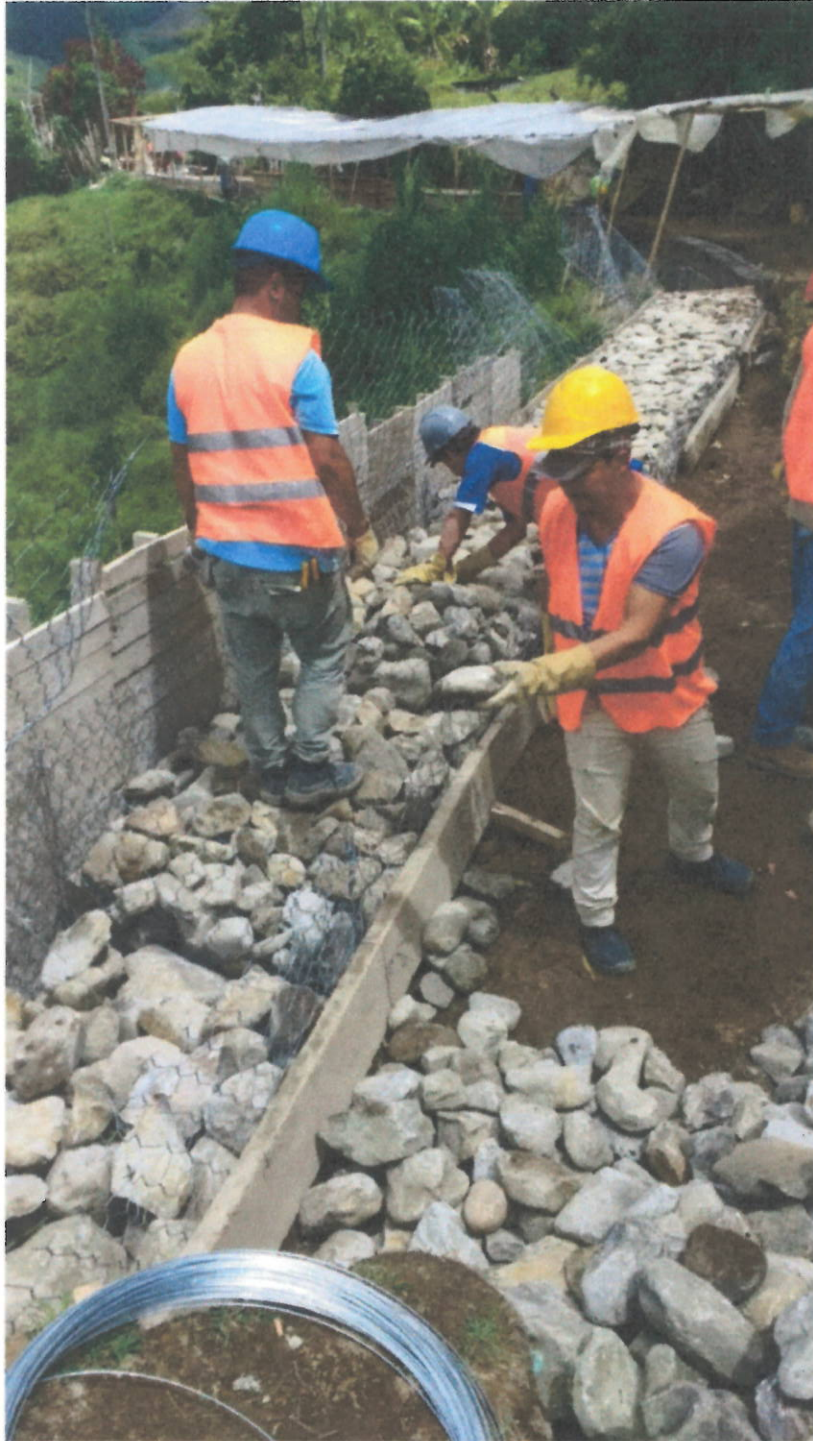
Instalación de gaviones en el sitio
