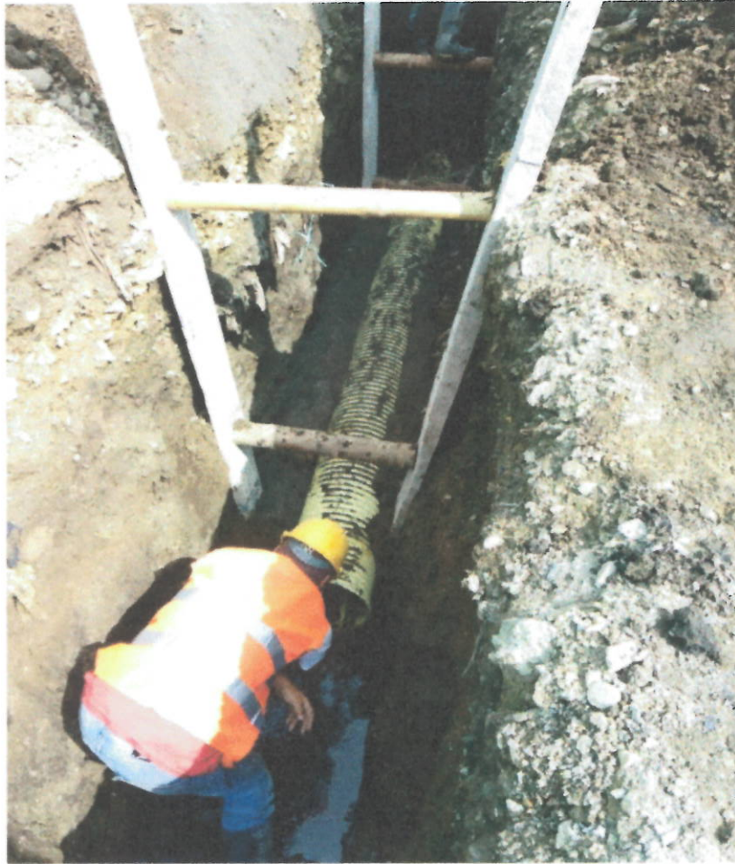
Instalación de tubería 12" para red principal de alcantarillado.
