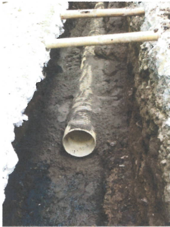
Instalación de tubería 12" para red principal de alcantarillado
