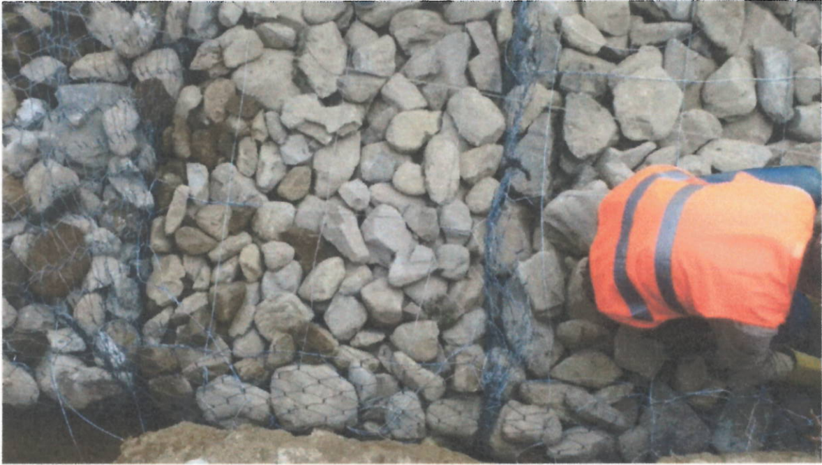
Instalación de gaviones en el sitio
