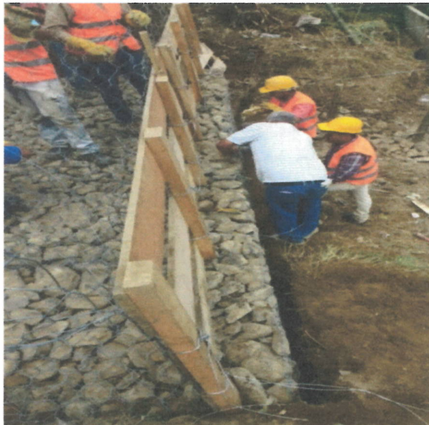
Instalación de gaviones en el sitio
