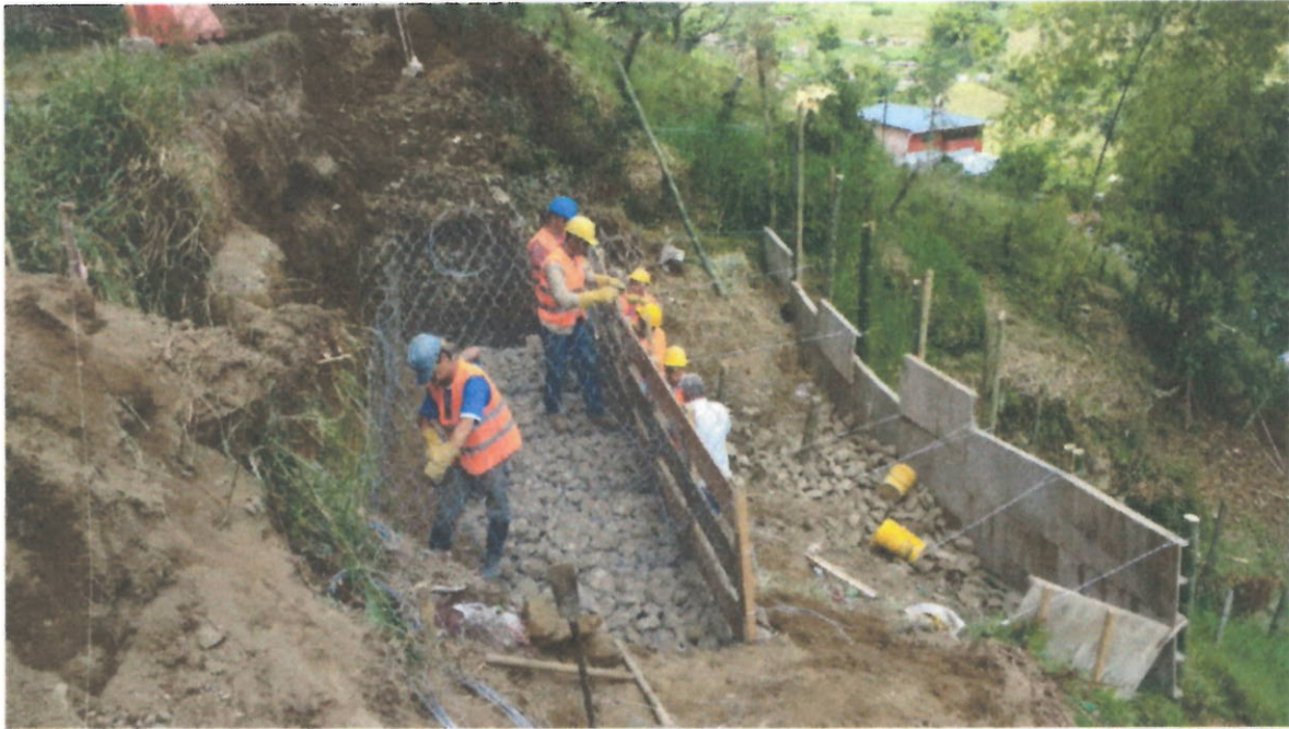
Instalación de gaviones en el sitio
