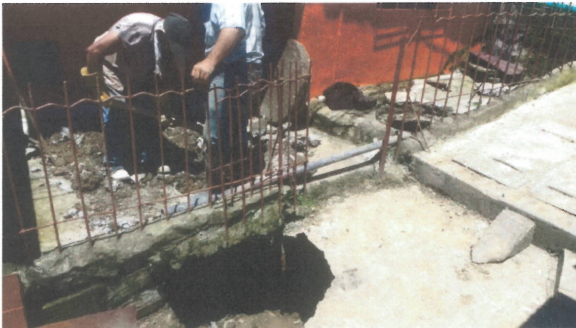
Demolición de andén en vía peatonal y en antejardín para inspección y reparación alcantarillado.
