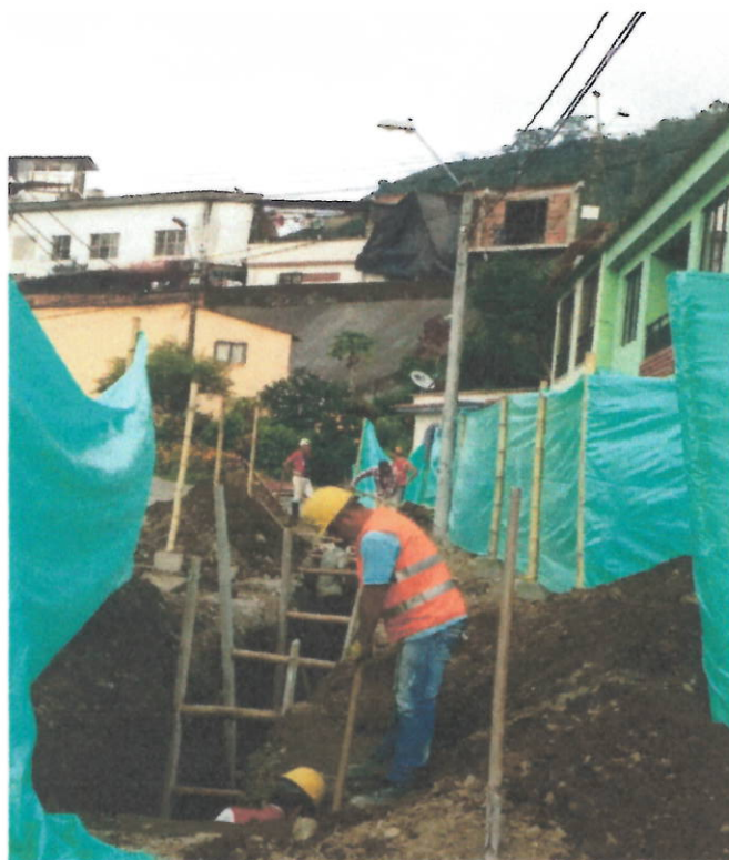
Localizacion de red principal alcantarillado existente en mal estado.
