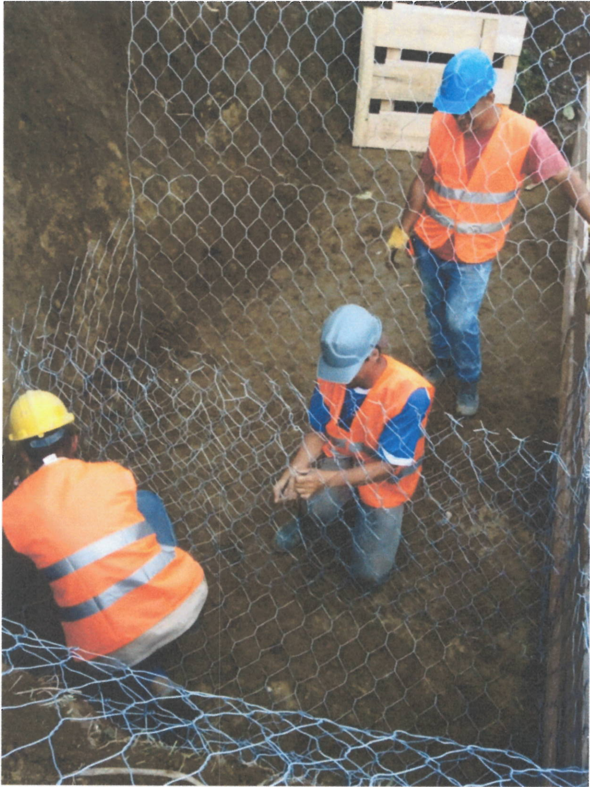
Instalación de gaviones en el sitio
