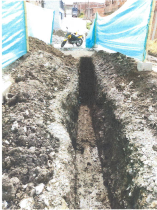
Demolicion de pavimento existente y excavacion en zanja
