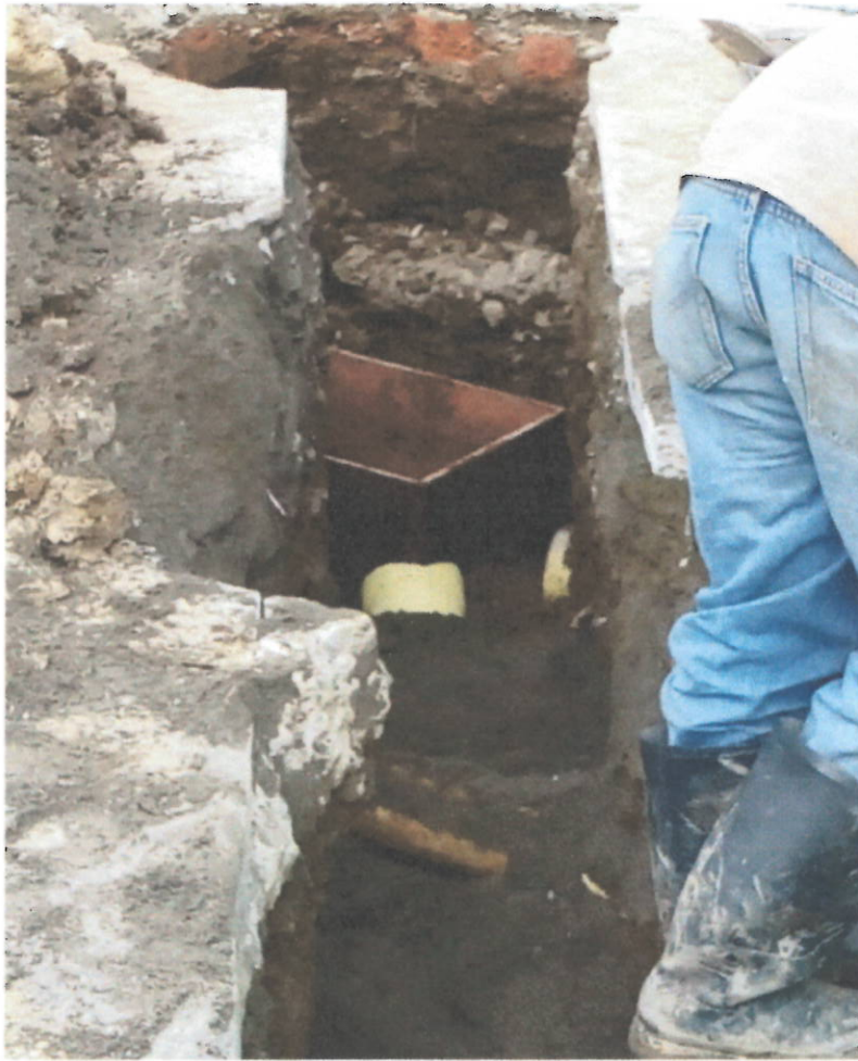
Instalación caja de inspección para domiciliaria de alcantarillado.
