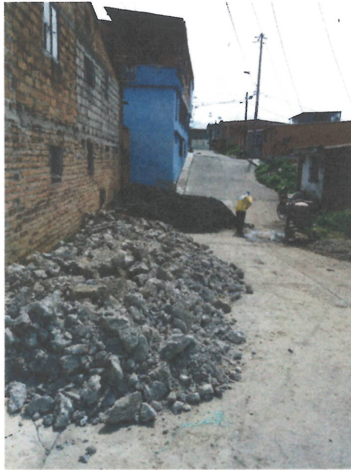
Material de demolición y excavaciones para retiro.
