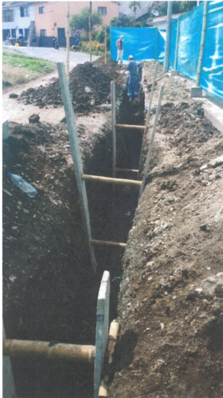
Entibado Tipo 1 en zanja excavada.
