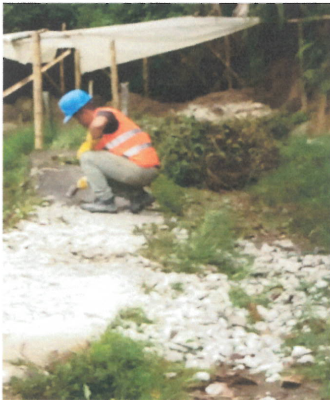
Demolición recubrimiento de gavión existente
