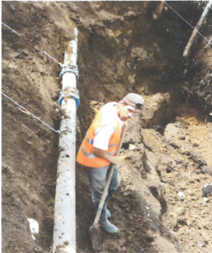
Excavación en material de sitio para reubicación de tubería y nivel de desplante de gaviones
