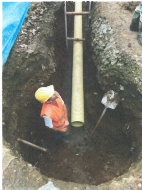
Excavaciones para cámara de inspección de alcantarillado e instalación de tubería.
