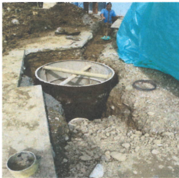
Vaciado de cámara de inicio de alcantarillado
