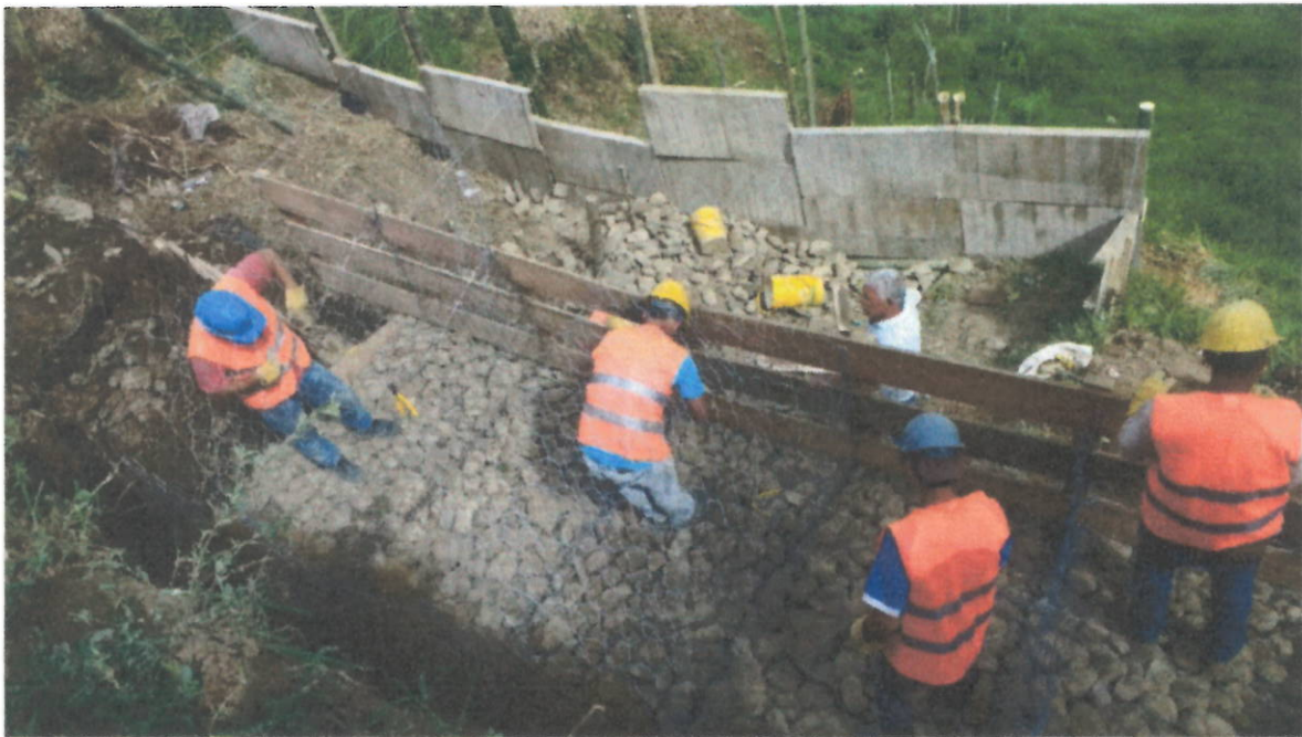
Instalación de gaviones en el sitio
