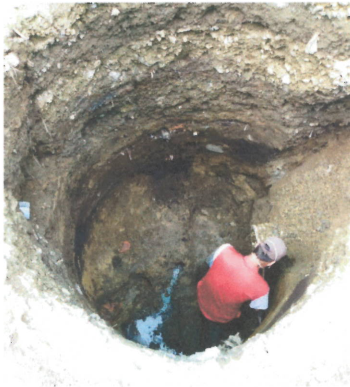
Excavación para cámara de llegada alcantarillado
