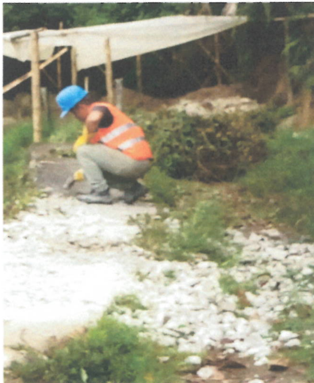
Demolición recubrimiento de gavión existente
