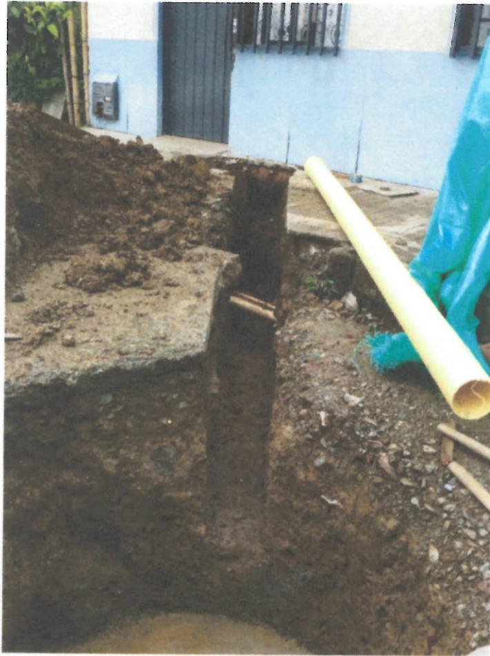
Excavación en zanja para pase de acometida domiciliaria hacia cámara de inspección
