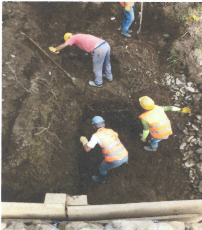
Excavación en material de sitio para reubicación de tubería y nivel de desplante de gaviones
