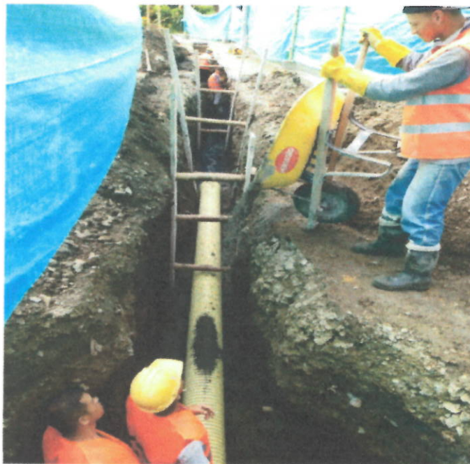
Instalación de tubería 12" red principal con base en arena.
