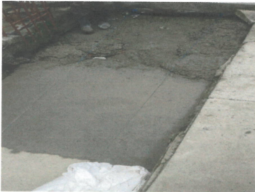
Andén en Concreto 3000 psi.
