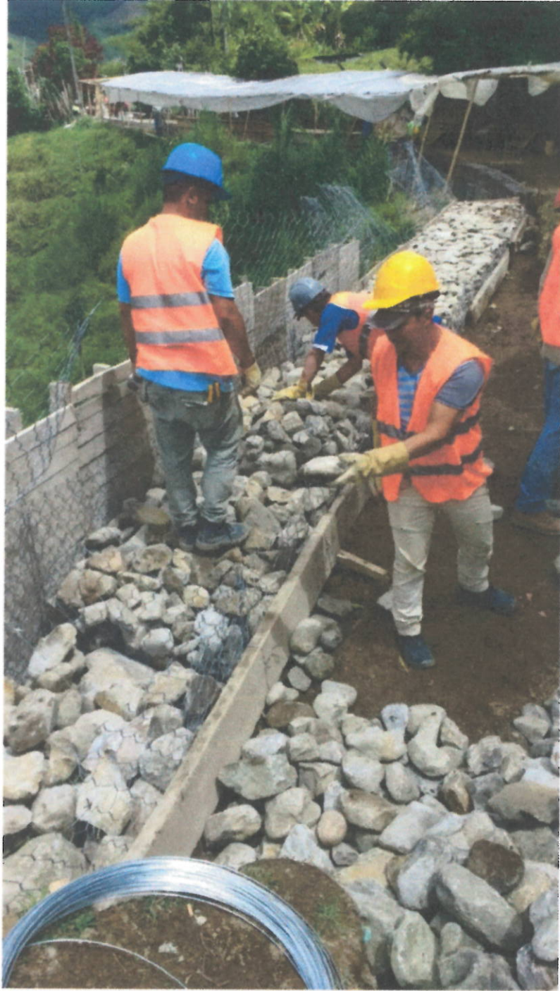
Instalación de gaviones en el sitio
