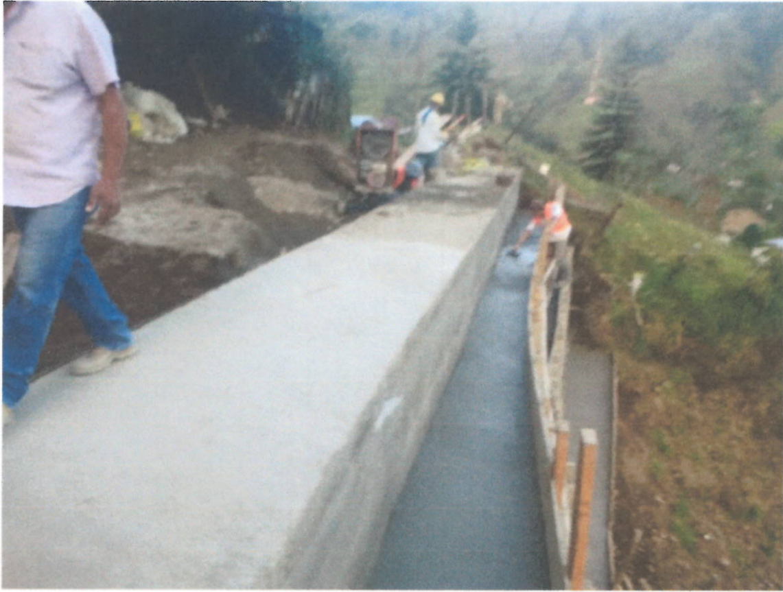
Recubrimiento gaviones instalados
