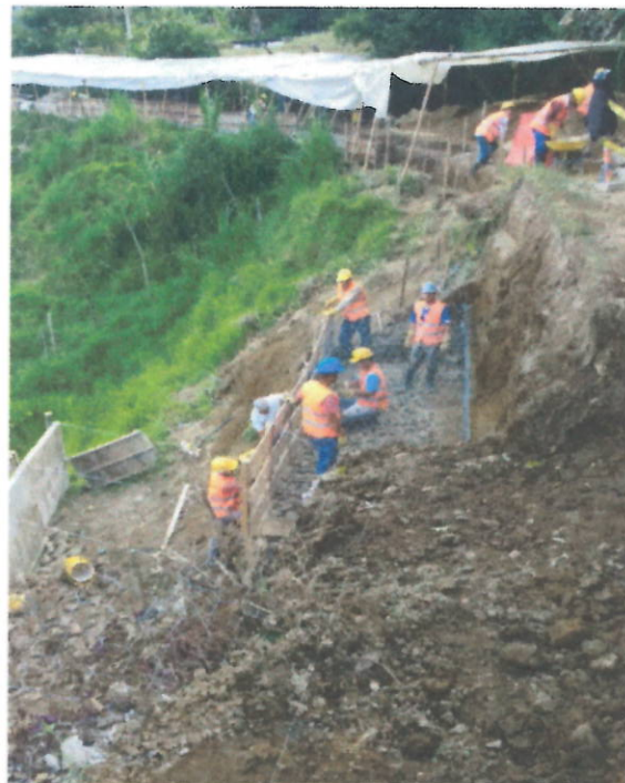
Excavaciones para instalación de nuevo muro de gaviones
