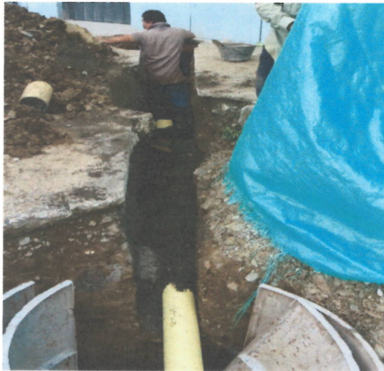
Instalación tubería 6" para domiciliaria de alcantarillado.
