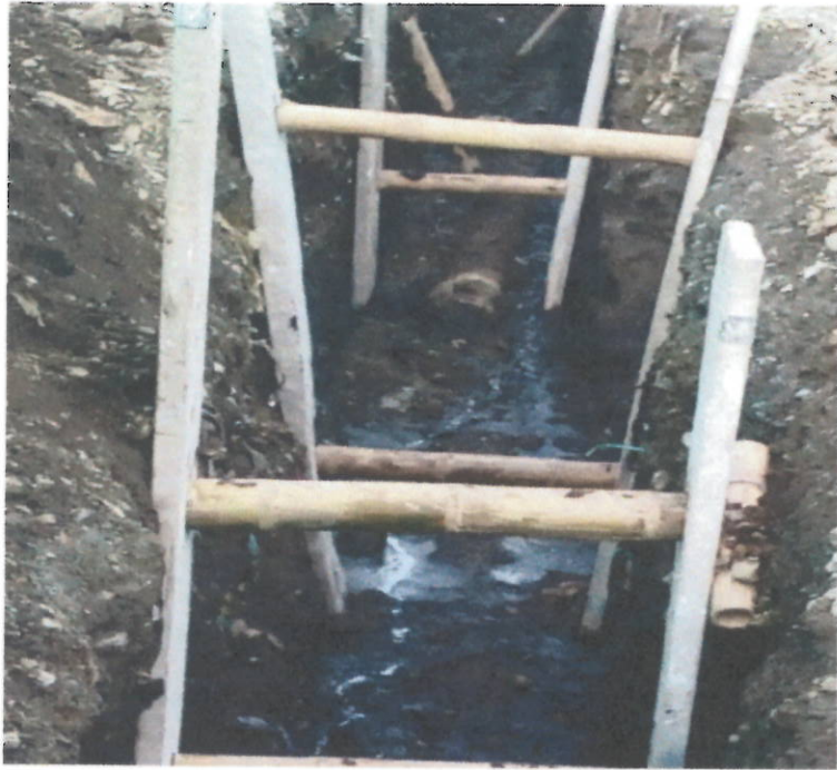
Localizacion de red principal alcantarillado existente en mal estado.
