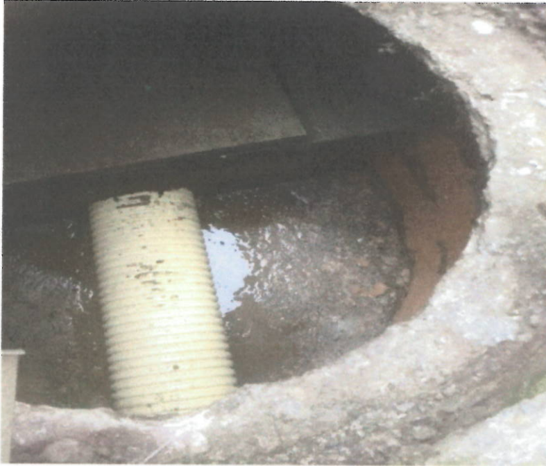
Reparación puntual para captación de aguas de cámara existente y de caja domiciliaria por filtraciones en la zona y hundimiento de andén.
