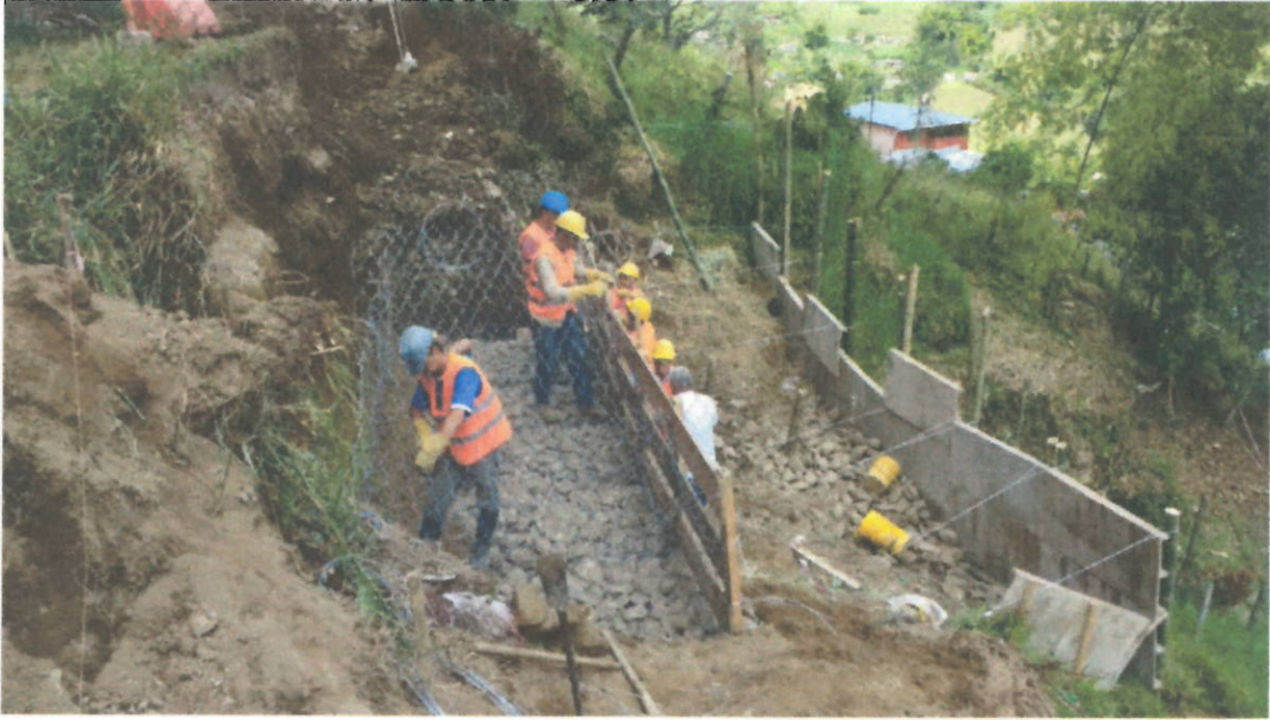
Instalación de gaviones en el sitio
