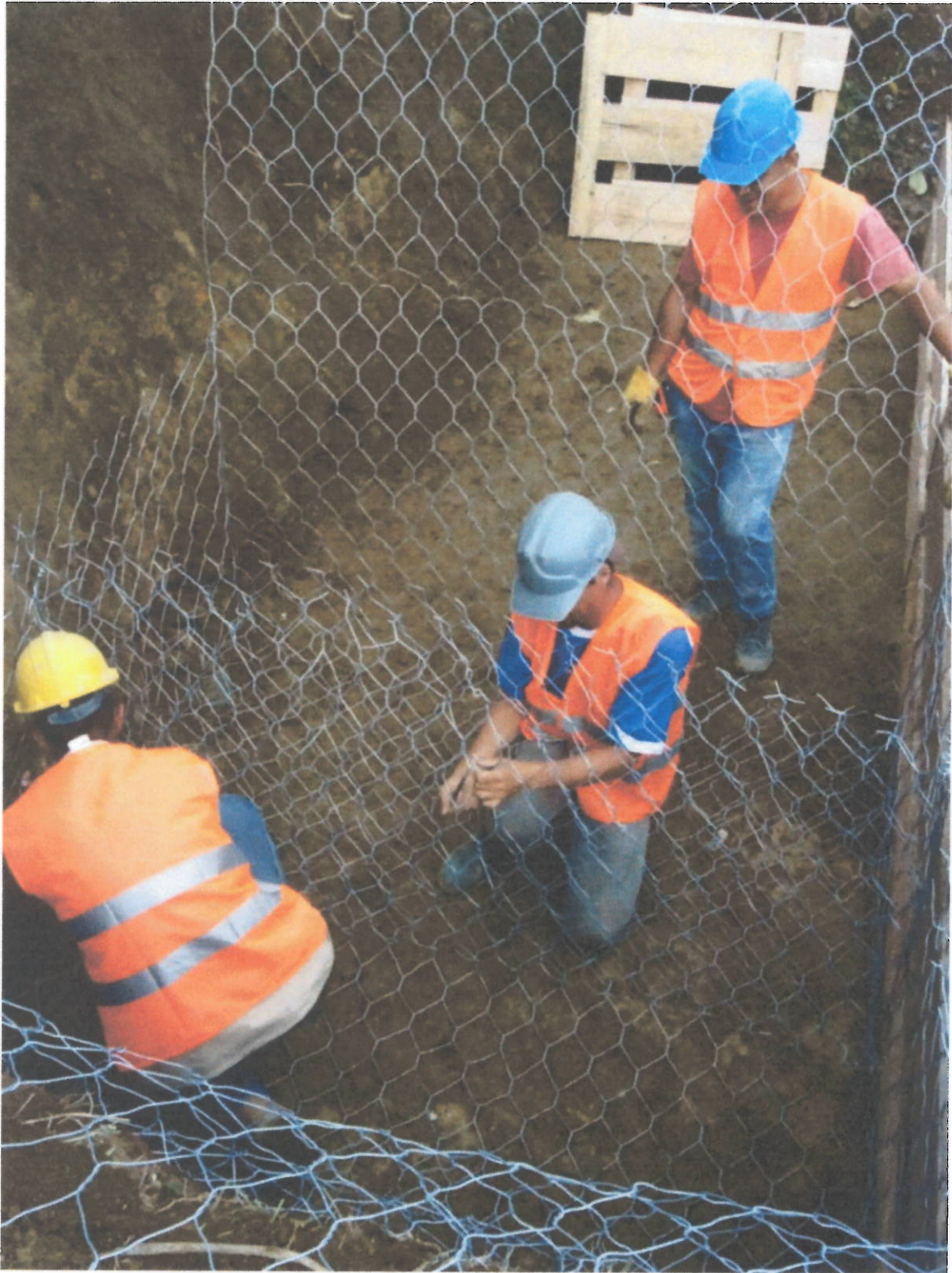
Instalación de gaviones en el sitio
