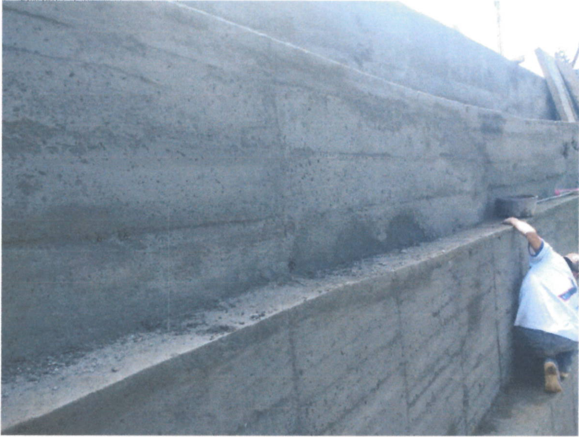
Recubrimiento gaviones instalados
