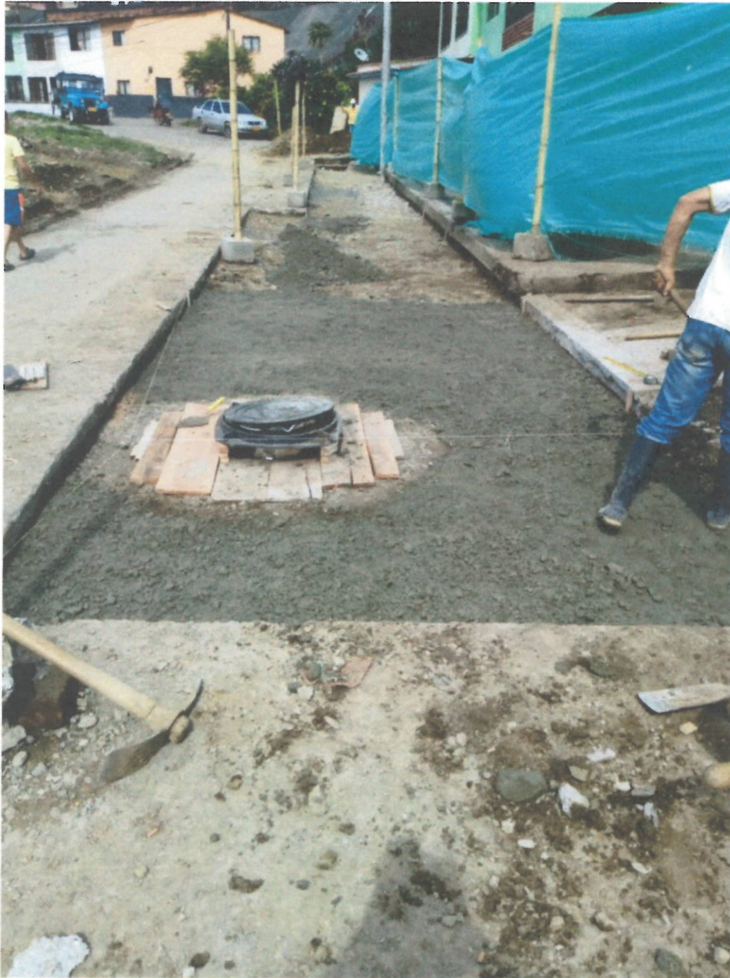
Instalación de subbase para pavimento.
