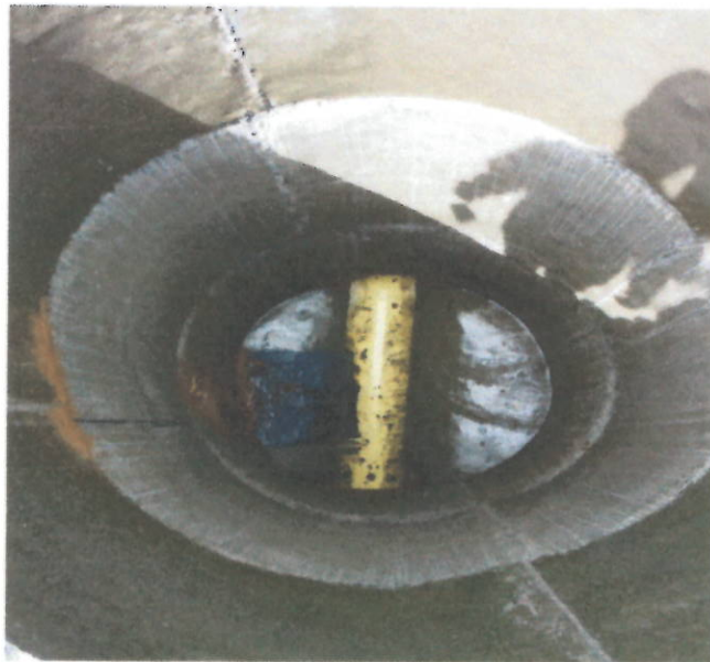
Instalación caja de inspección para domiciliar de alcantarillado.
