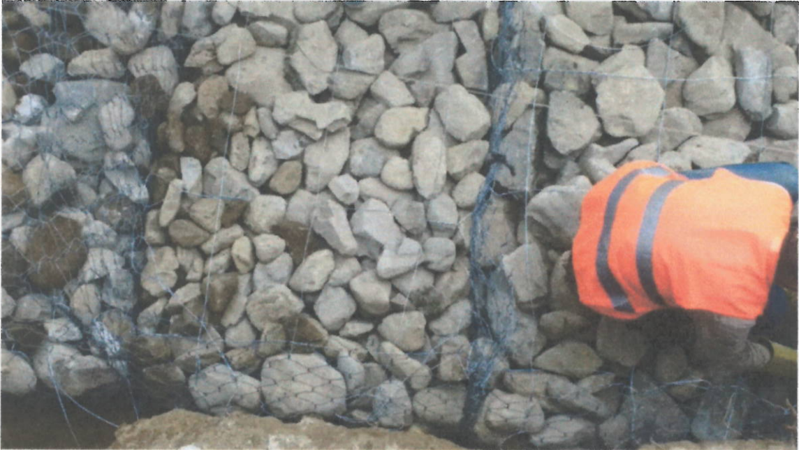
Instalación de gaviones en el sitio
