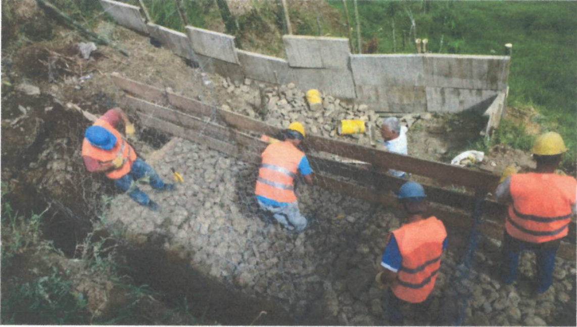
Instalación de gaviones en el sitio
