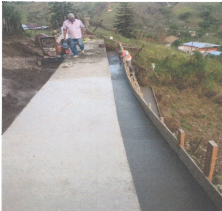
Recubrimiento gaviones instalados
