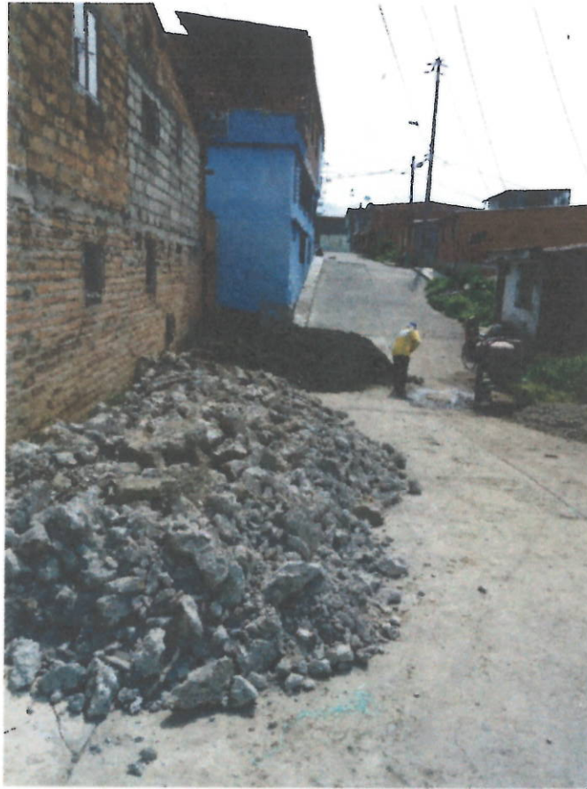
Material de demolición y excavaciones para retiro.
