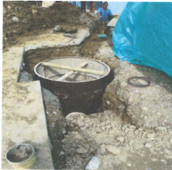
Vaciado de cámara de inicio de alcantarillado
