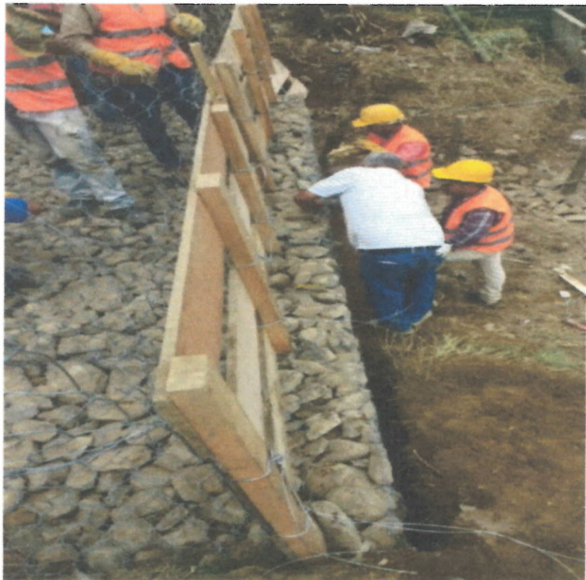
Instalación de gaviones en el sitio
