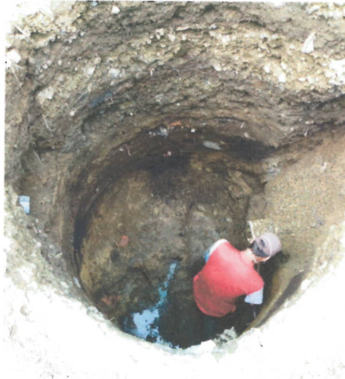
Excavación para cámara de llegada alcantarillado
