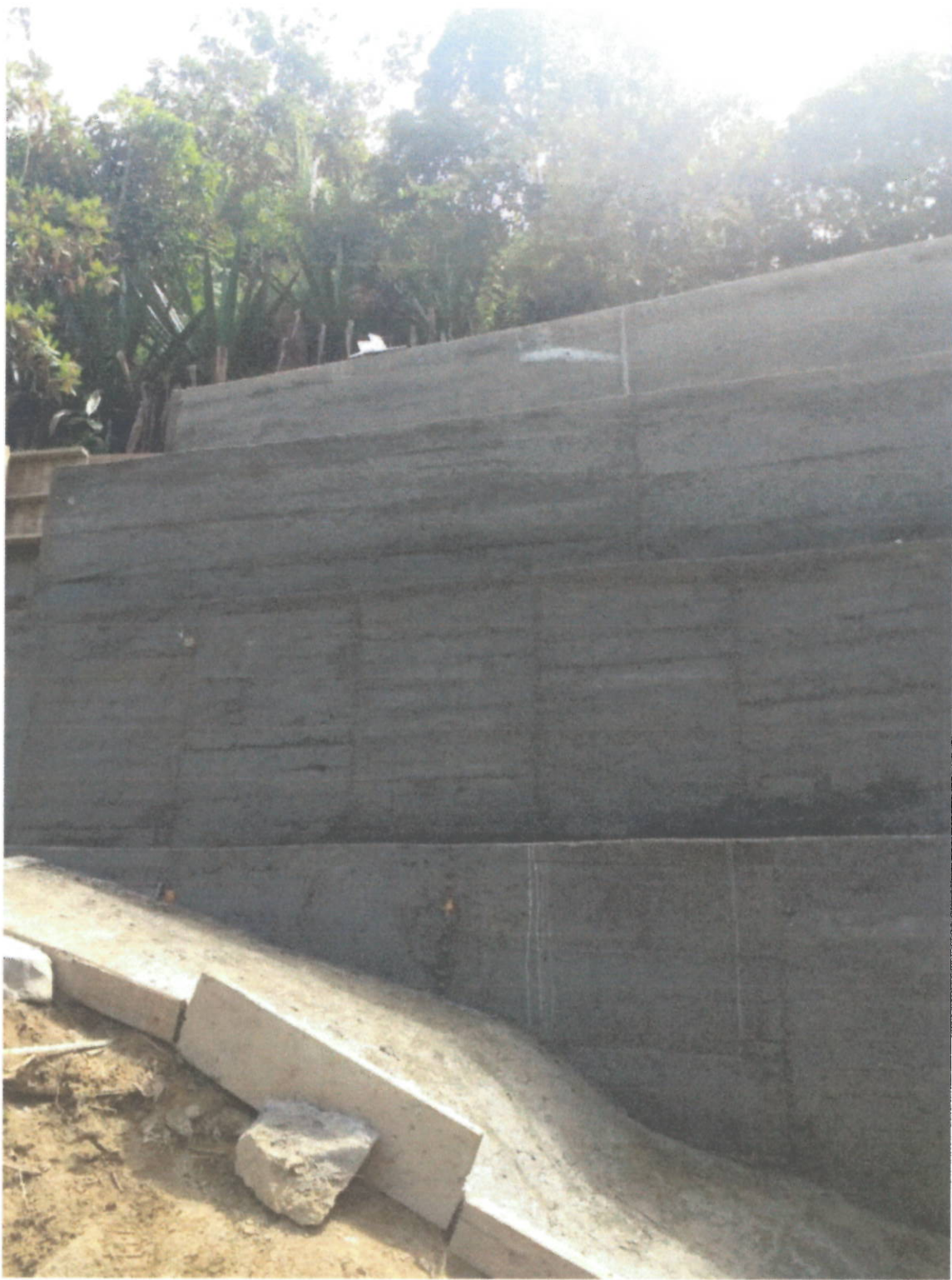
Recubrimiento gaviones instalados
