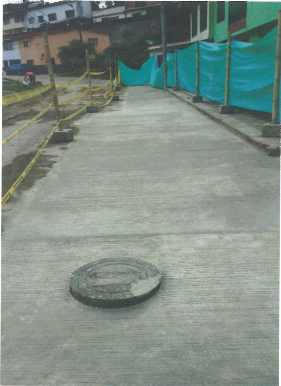
Pavimento MR 42 instalado
