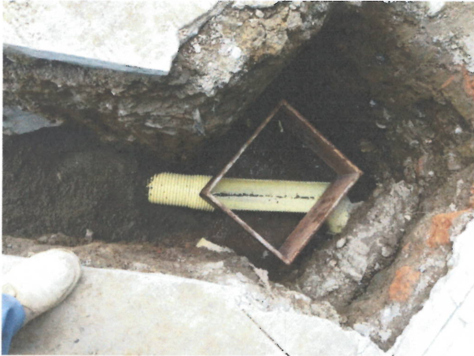
Instalación caja de inspección para domiciliaria de alcantarillado.
