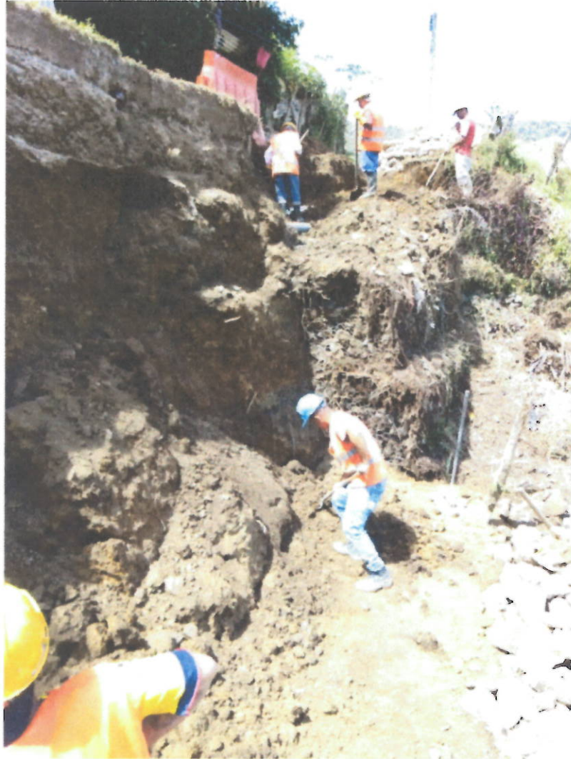
Excavación en material de sitio para reubicación de tubería y nivel de desplante de gaviones
