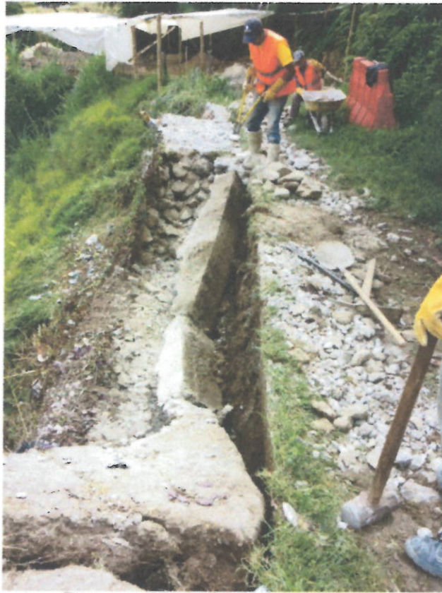
Desmante gavioneria existente
