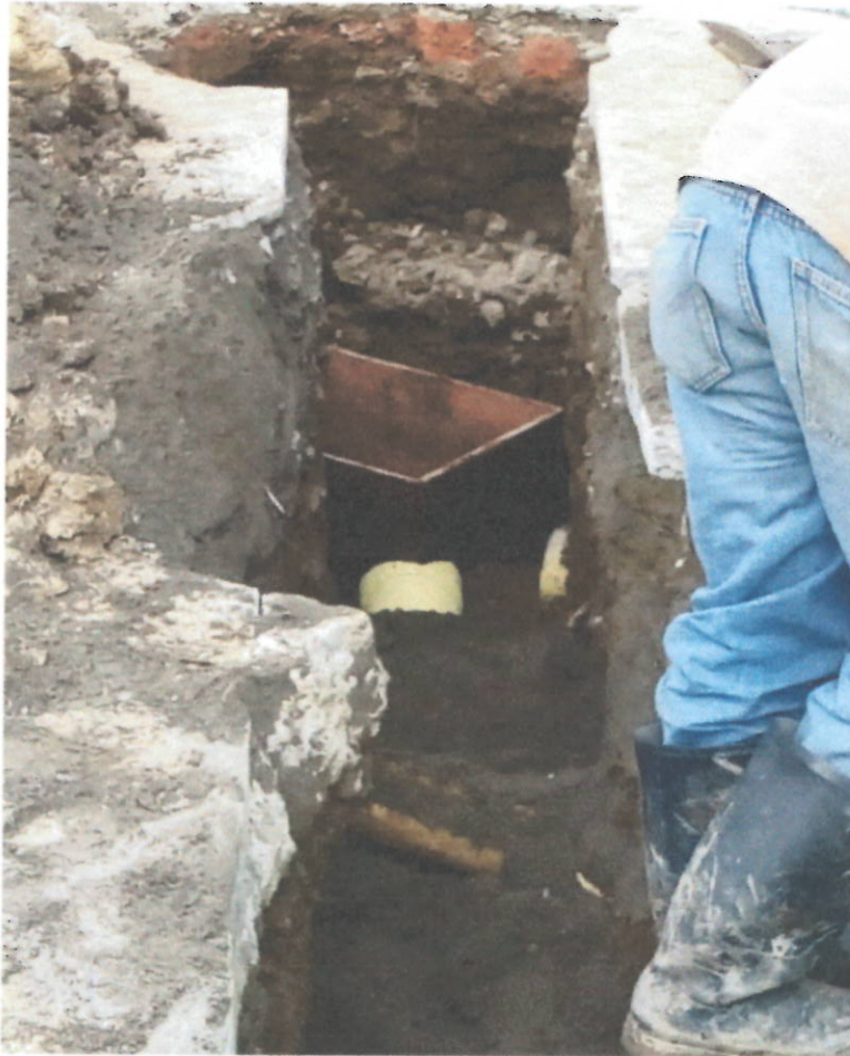
Instalación caja de inspección para domiciliar de alcantarillado.
