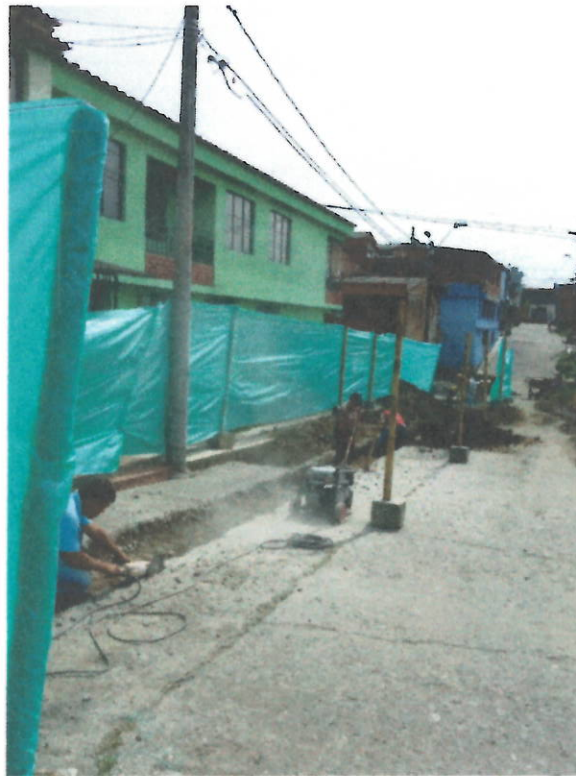
Cerramiento en Yute y corte con disco abrasivo
