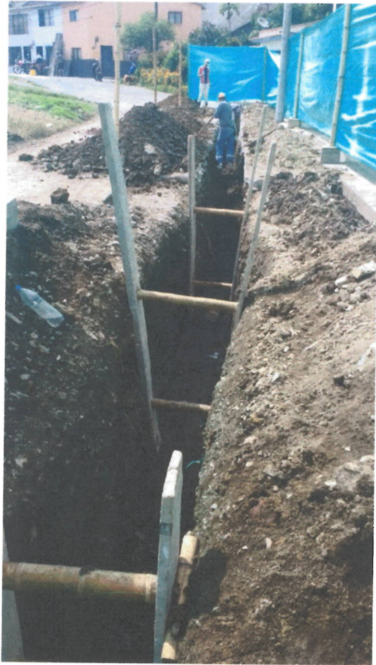
Entibado Tipo 1 en zanja excavada.
