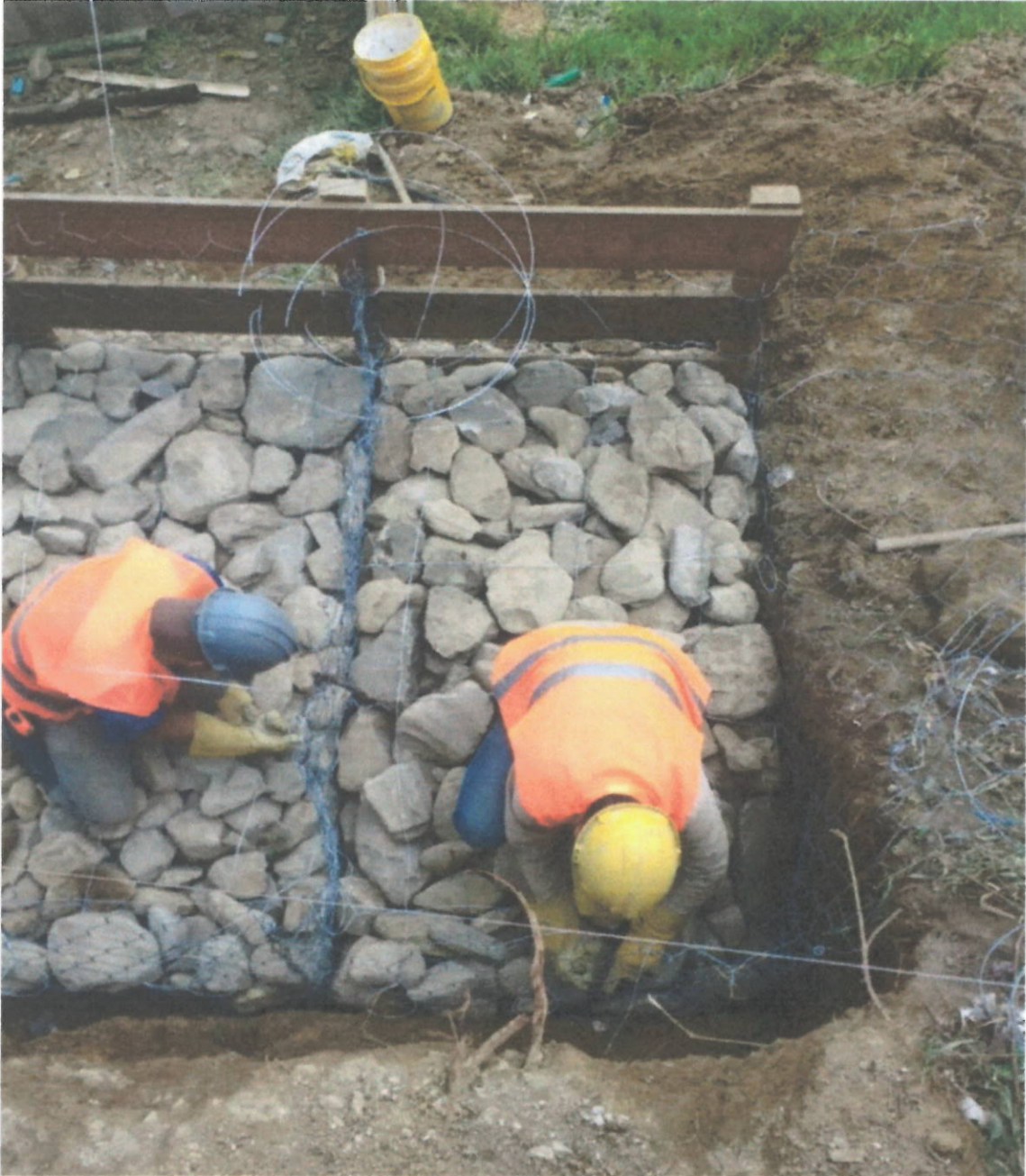
Instalación de gaviones en el sitio
