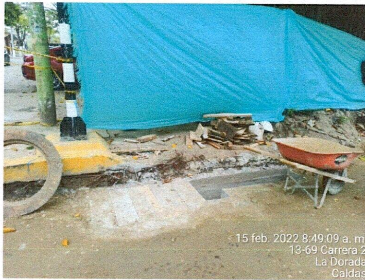
Sumidero de tres rejas, en proceso Constructivo.
