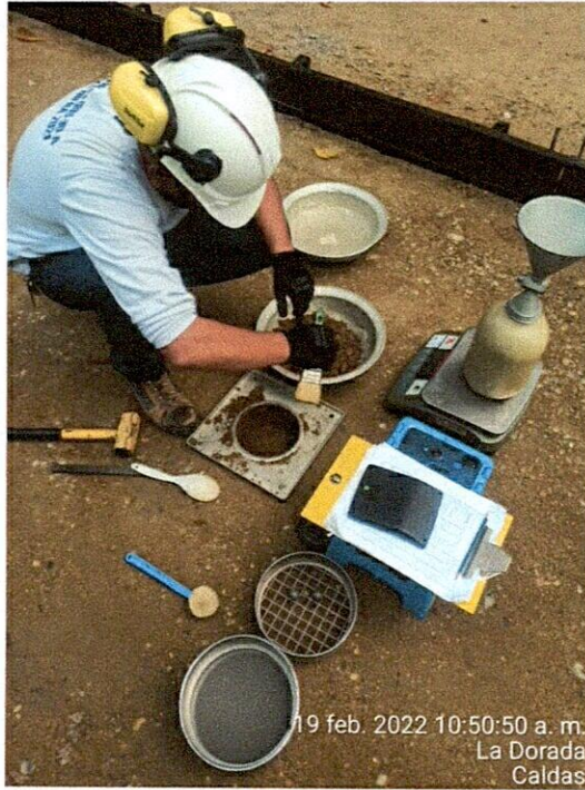
Toma de densidades de campo, sub base granular.
