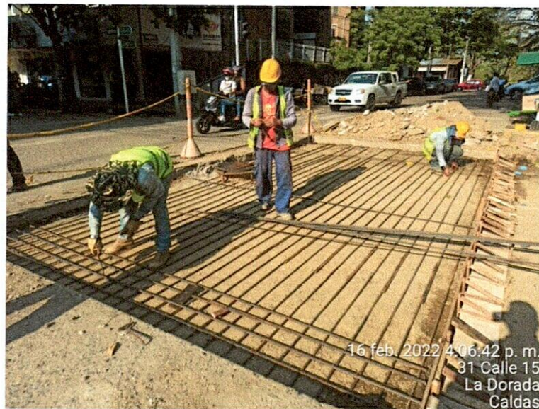
Suministro e instalación acero de refuerzo para pavimento.
