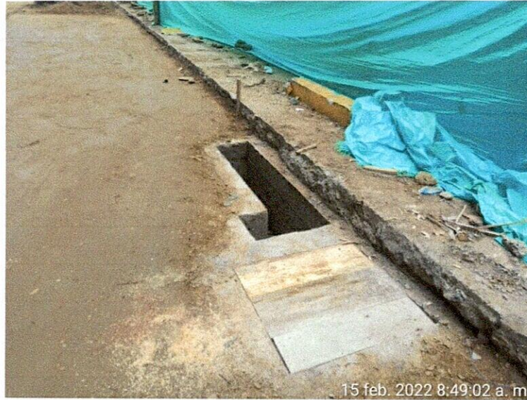
Construcción sumideros o imbornales en concreto.
