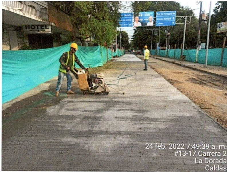
Corte dilataciones o juntas del Pavimento
