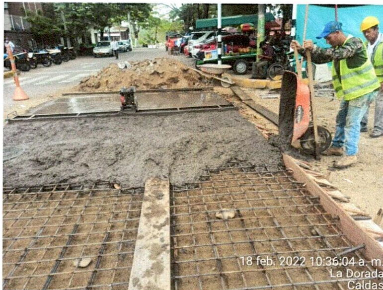
Suministro e instalación concreto para pavimento MR 41.
