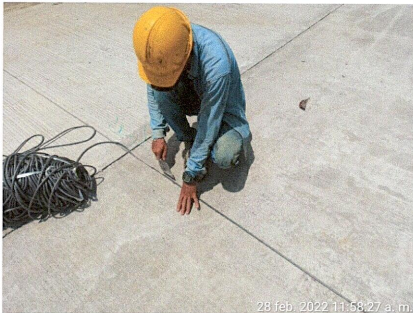
Procedimiento sellado juntas pavimento.
