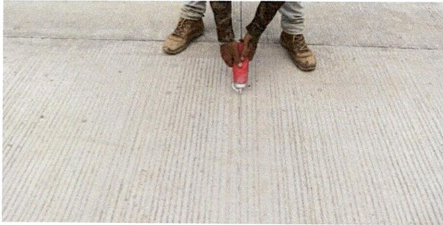
Aplicación sellante elastómero para juntas de pavimento.
