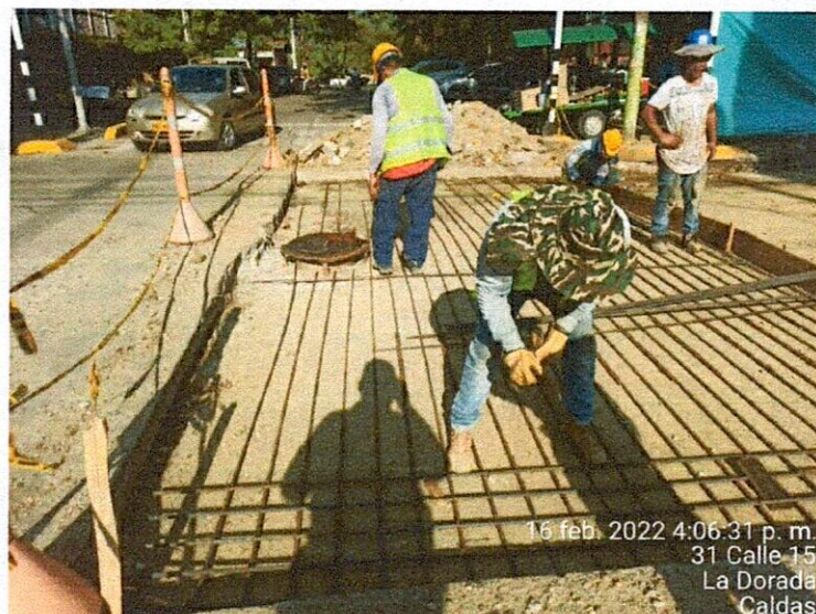
Suministro e instalación de acero de refuerzo.
